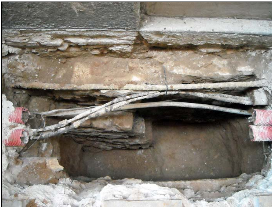
Vista final de la cala un cop excavada
