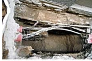
Final d'excavació. Vista zenital.JPG
