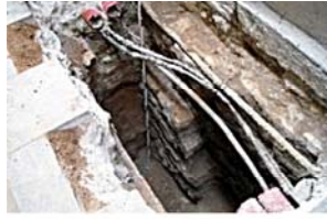
18) Imatge final fonamentació.JPG
