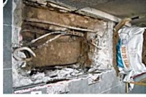
Serveis u.e. 108 i ue 109 i inici fonamentació.JPG
