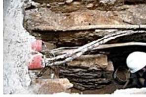
Procés d'excavació manual.JPG
