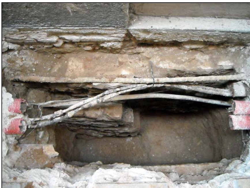
Imatge final de la cala un cop finalitzada la seva excavació
