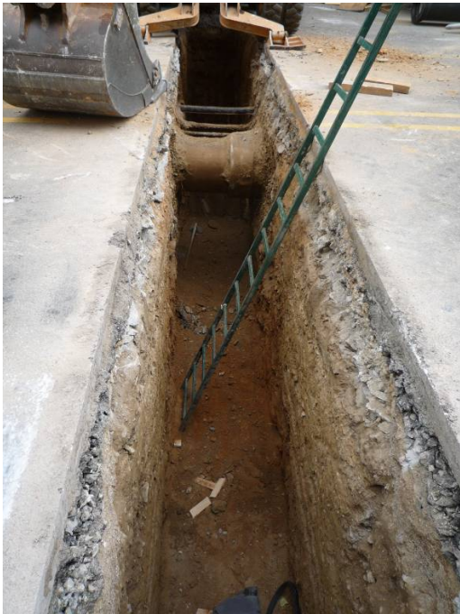
Rasa preparada per posar les canonades.
