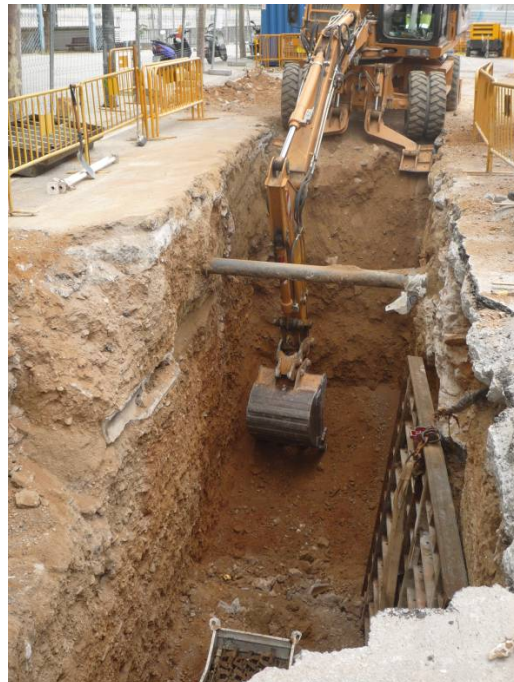
Treballs d'excavació amb màquina.
