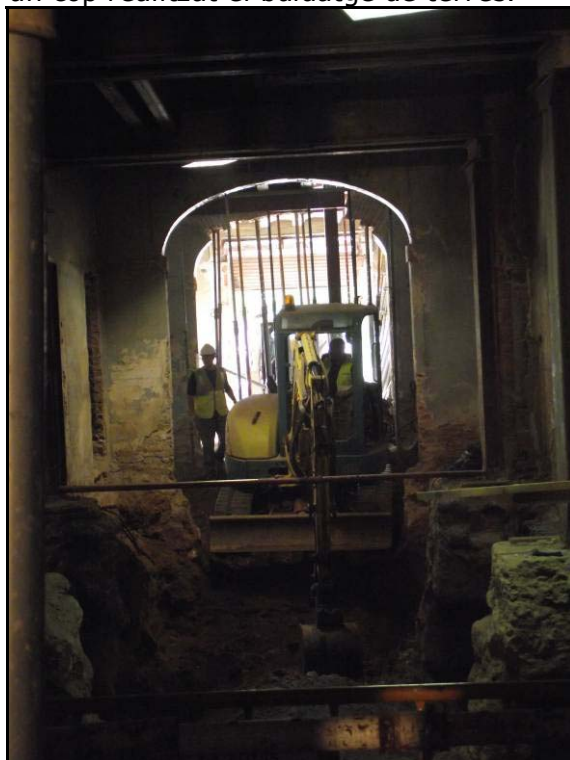
Fotografia 4. Detall dels treballs al pou 3 durant el buidatge de terres.
