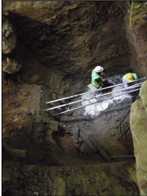
Fotografia 3. Detall dels treballs al pou 2 un cop realitzat el buidatge de terres.
