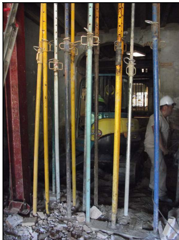
Fotografia 10. Detall de les condicions de l'obra durant la realització de buidatge de terres dels pous.
