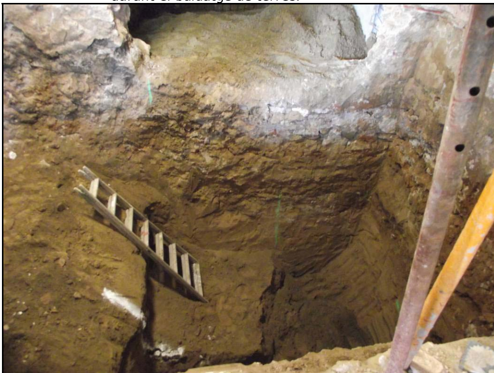
Fotografia 8. Detall del pou 5, un cop realitzat el buidatge de terres.
