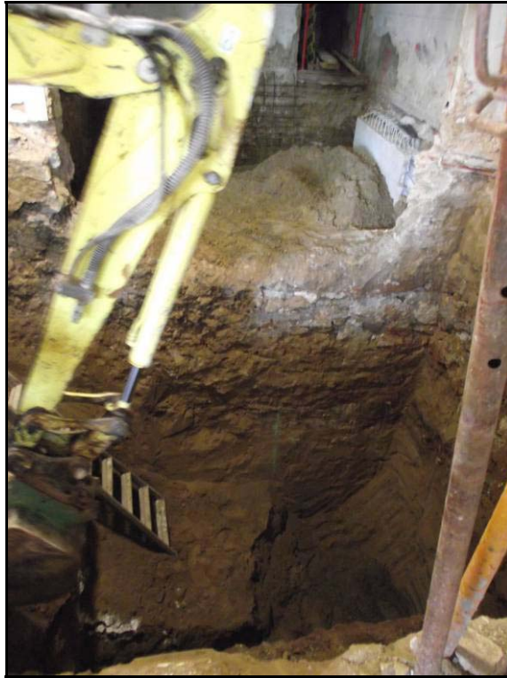
Fotografia 7. Detall dels treballs al pou 5 durant el buidatge de terres.
