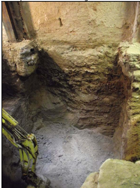
Fotografia 2. Detall dels treballs al pou 2 durant el buidatge de terres.
