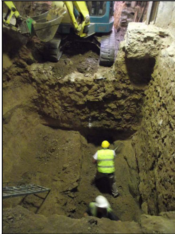
Fotografia 1. Detall dels treballs al pou 1 un cop realitzat el buidatge de terres.
