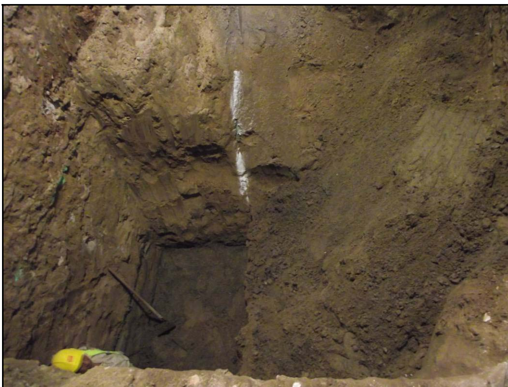
Fotografia 5. Detall del pou 3, un cop realitzat el buidatge de terres.
