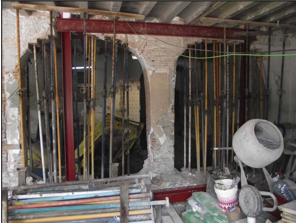
Fotografia 9. Detall de les condicions de l'obra durant la realització de buidatge de terres dels pous.
