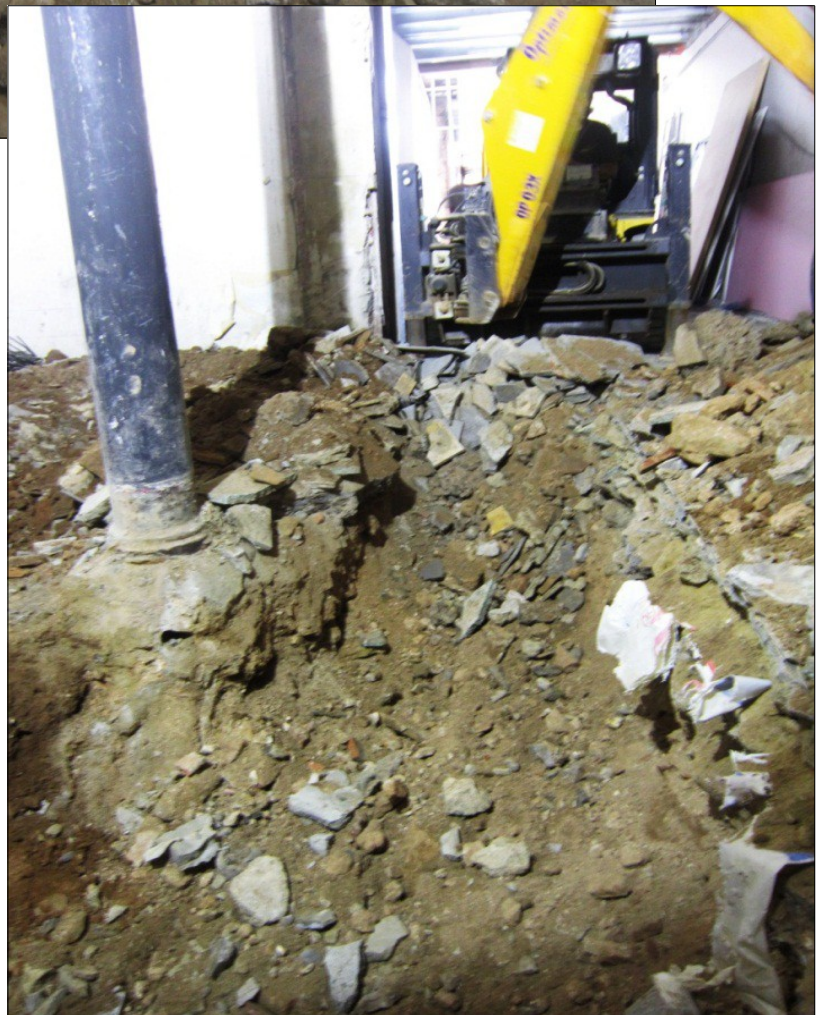
Fig 12 i 13. Fotografies de l'estat de conservació dels perfils i de l'inseguretat dels rebaixos.
