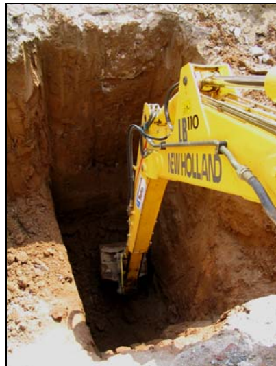
F4: excavació del sondeig 2 (rasa 1)
