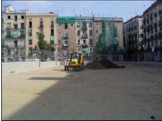
F1: vista general del solar a l'inici dels treballs.
