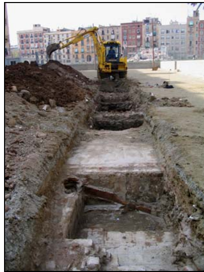
F2: excavació de la rasa 1.
