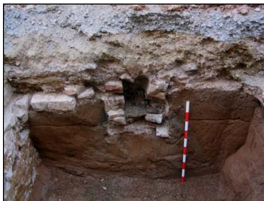
F38: Rasa2-Finca 003/àmbit 3B: claveguera UE 2016.
