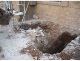
Rasa 4 Afectació u.e. 400
