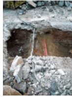
Rasa 2 Serveis soterrats
