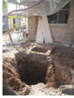
Rasa 5 Tram excavat
