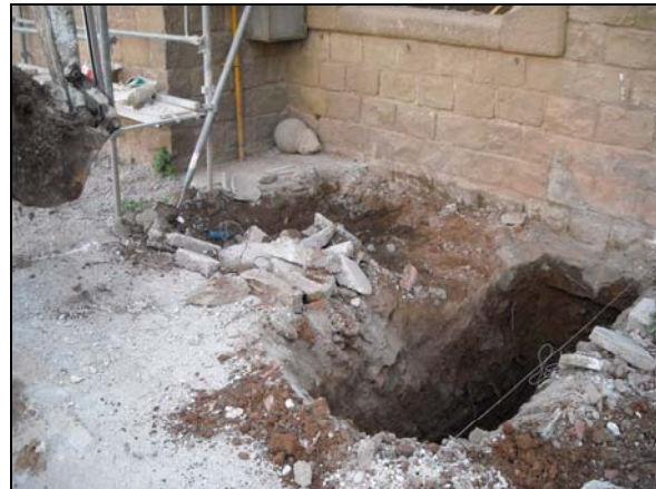
A l'esquerra vista del sector on es marcà la Rasa 4 i a la dreta l'afectació del nivell de formigó u.e. 400
