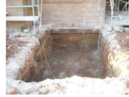
Rasa 4 Vista general des del Nord
