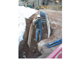
Rasa 1 Desmuntatge tram entibat
