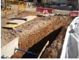
Rasa 1 Vista general des del tram mitjà
