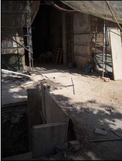
Vista general del sector on s'havia de realitzar la Rasa 3
