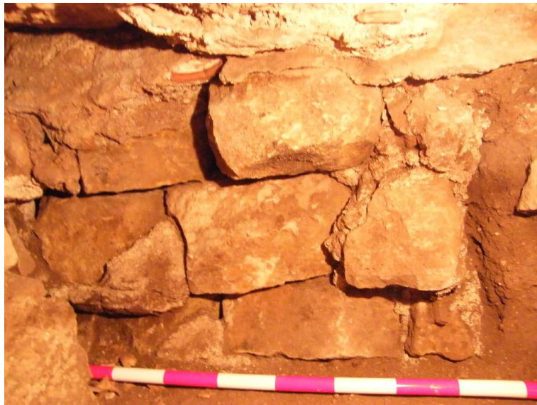
Fig.9 Detall del mur 308.
