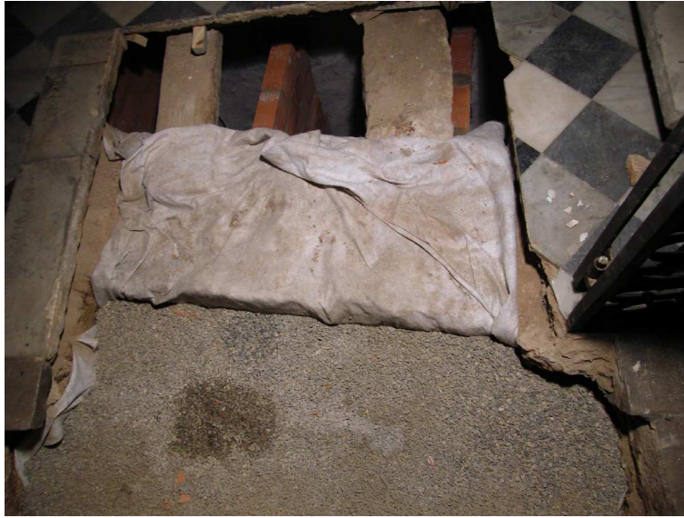
Fig.7 Observem al fons les estructures de maons, al centre el mur cobert amb geotèxtil i a baix la grava que reomplí la trinxera del mur.
