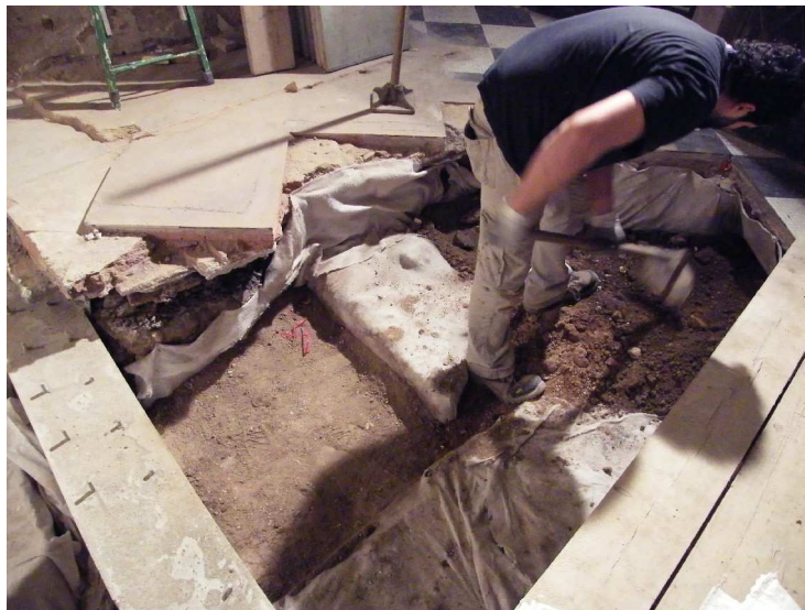
Fig.37 Treballs d'acondicionament i cobriment de les estructures
