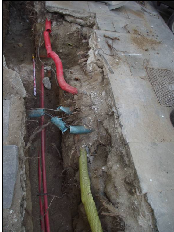
Fotografia 9. Detall de la situació del mur U.E.21.
