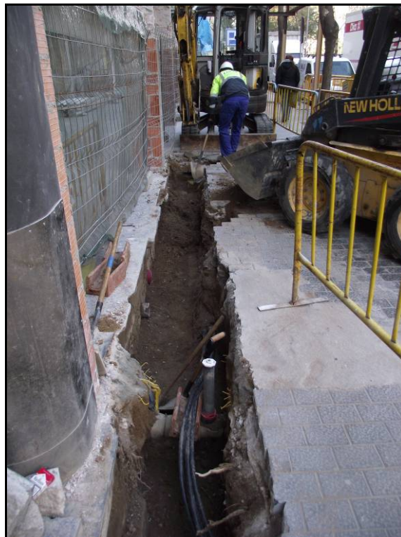
Fotografia 20. Detall on es poden observar els serveis que es troben a la rasa realitzada a la Avda. de les Drassanes 17-25.
