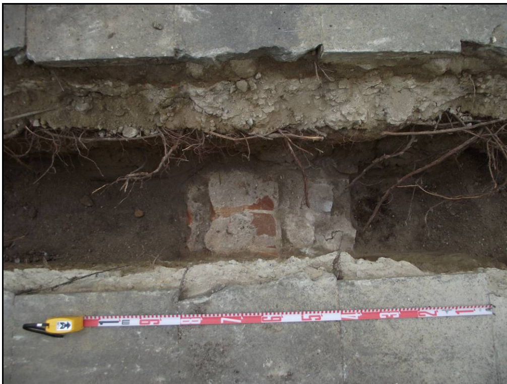
Fotografia 11. Vista zenital del mur U.E.23.
