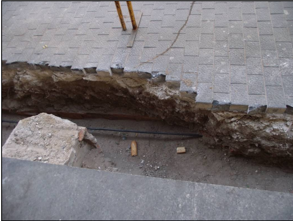
Fotografia 19. Detall on es poden observar els serveis que es troben a la rasa realitzada a la Avda. de les Drassanes 17-25.
