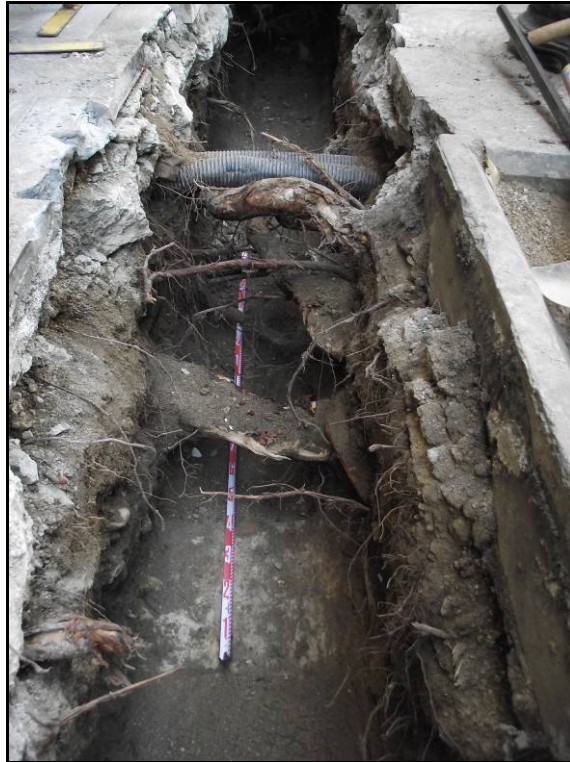
Fotografia 5. Detall del mur U.E. 14, afectat pels serveis i per les arrels.
