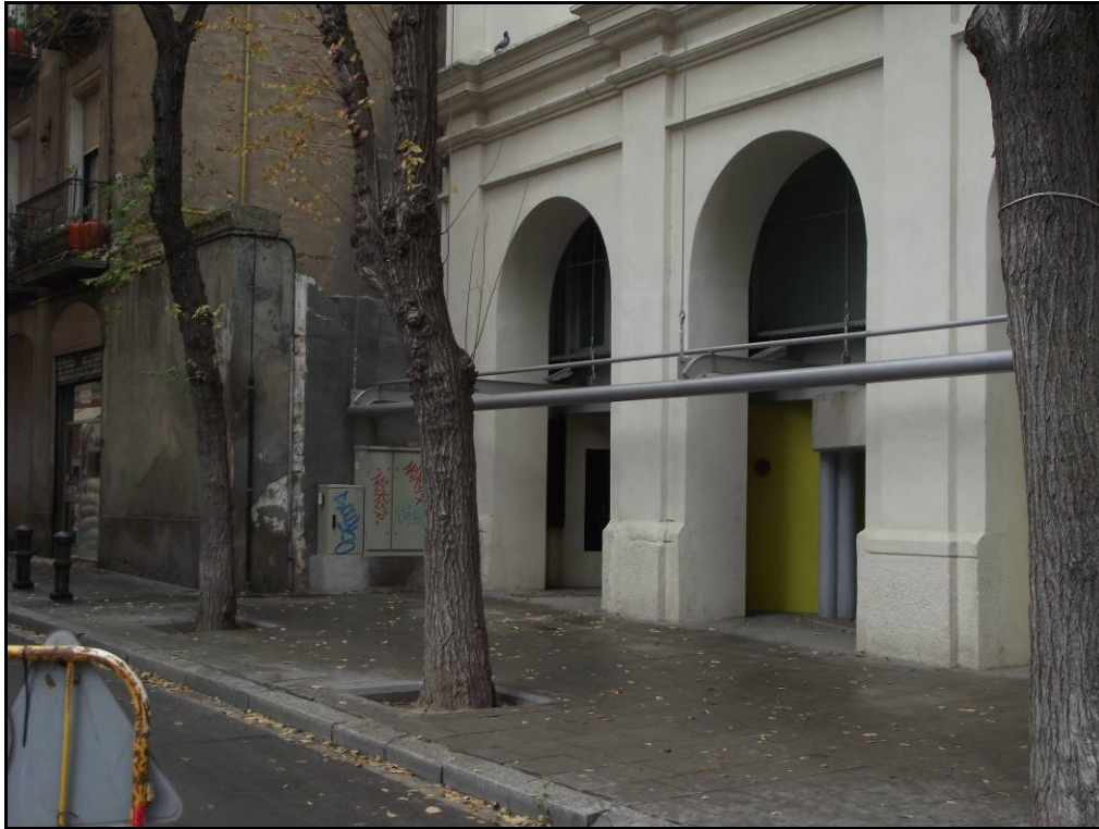
Fotografia 17. En aquesta fotografia es pot observar l'antiga i la nova línia de façana.
