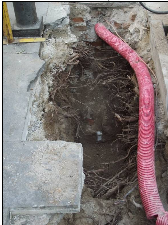
Fotografia 8. Estat del mur U.E.19, molt afectat pel serveis i perles arrels.
