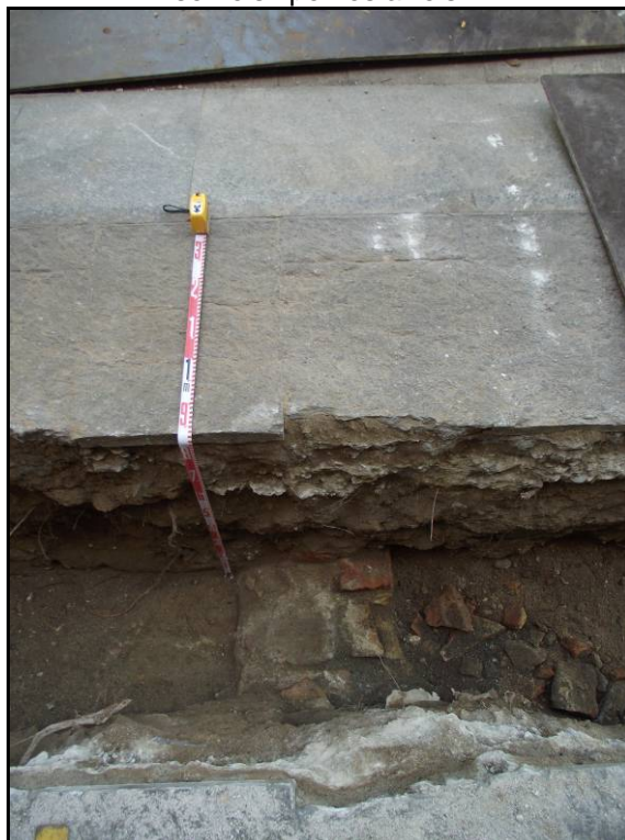
Fotografia 6. Detall de la potència a la que es trobava el mur U.E.16.
