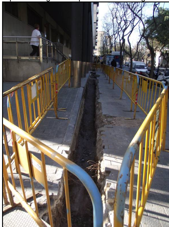
Fotografia 18. Vista general de la rasa realitzada a la Avda. de les Drassanes 17-25.
