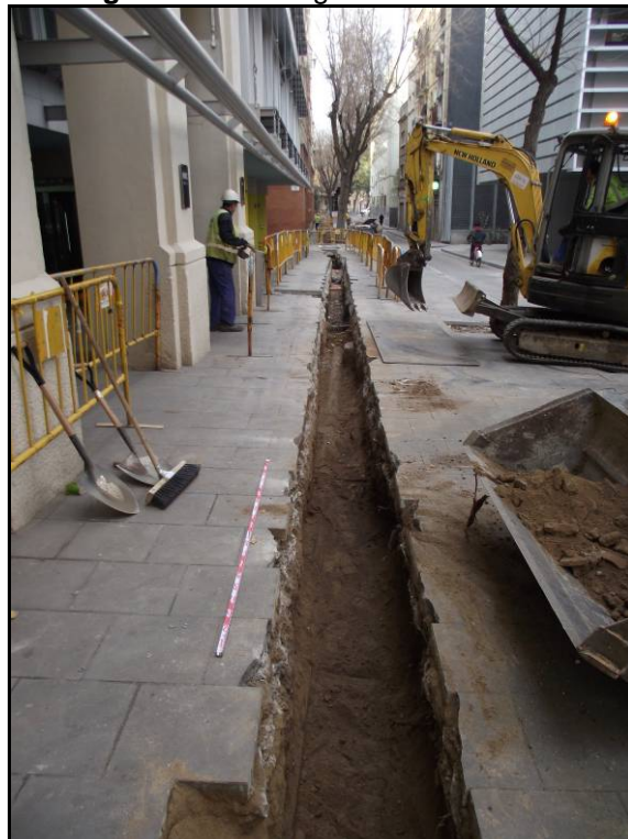
Fotografia 16. Detall de la rasa realitzada al carrer Arc del Teatre
