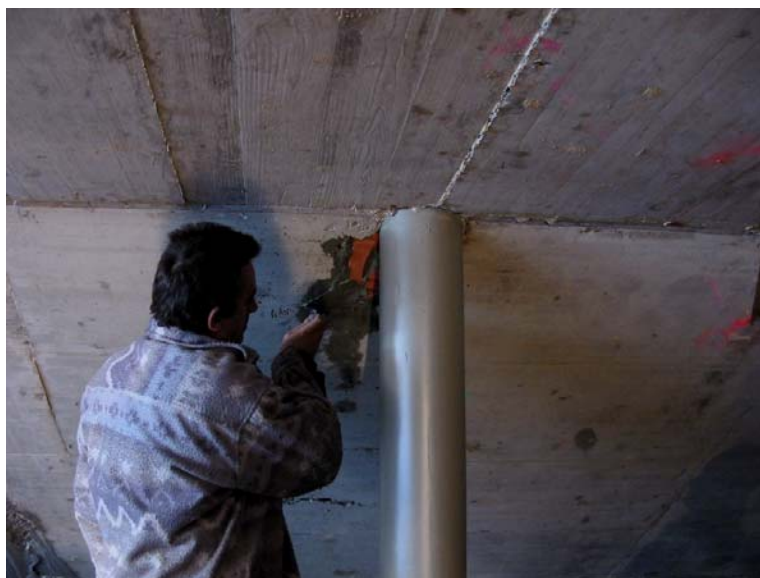
Moment en que l'operari reompla les llacunes i esquerdes de la coberta amb ciment - cola
