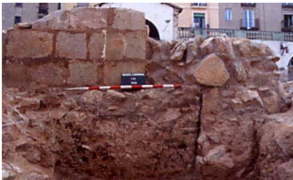
Fotografia núm. 3477. Detall del reforç de contrafort.
