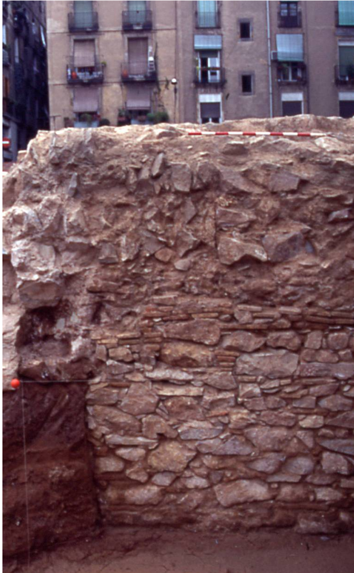
Fotografia núm. 2505. Alçat de la tomba, la part superior és la fonamentació de la capella i l'inferior l'afegit de la tomba.
