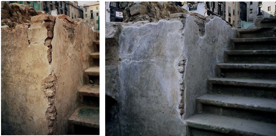
Detall dels treball de bisellat en els lliscats de l'escala d'accés a la cripta
