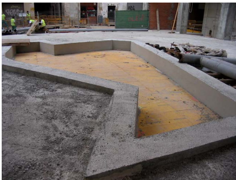
Detalls de la coberta per la part exterior una vegada el formigó ha estat aplicat i es troba en el procés d'adormiment.. Es poden observar les reserves deixades per la col·locació de les lluernes
