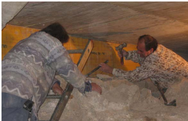
Moment de l'execució dels treballs
