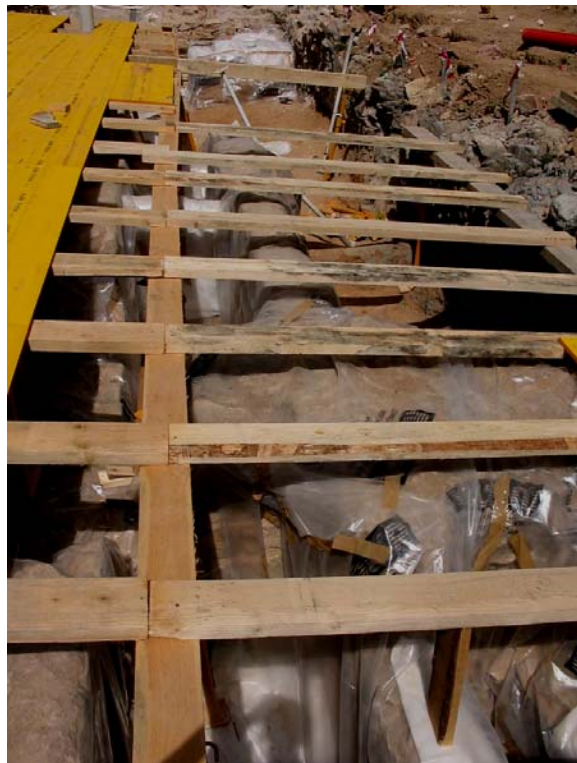
Col·locació dels taulons a sobre de l'estructura composta pels tirants i les corretges
