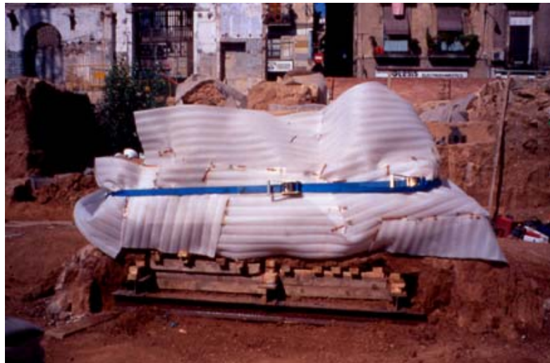
Preparació final del conjunt abans de l'extracció
