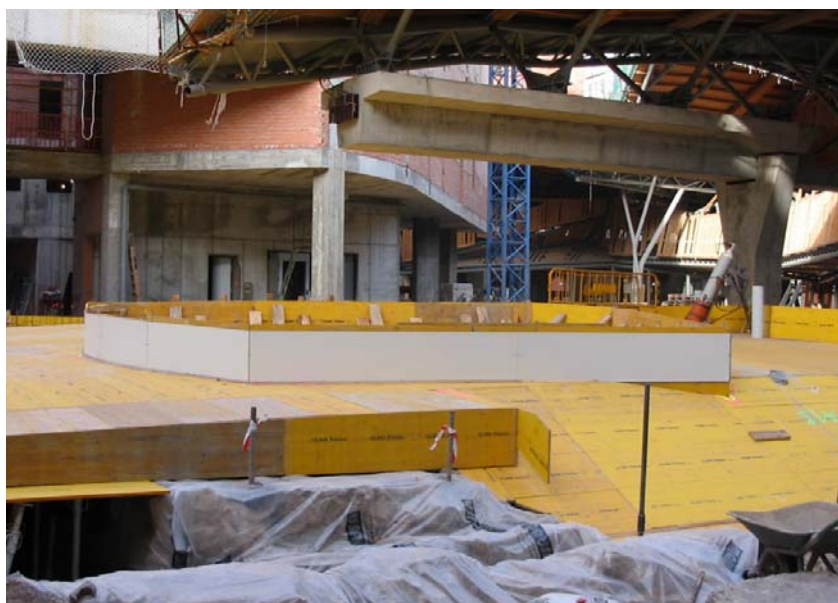
Detall d'una de les reserves de fusta que seran les futures lluernes
