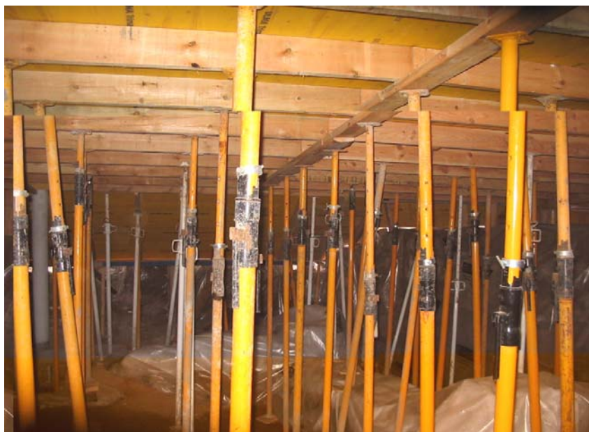
Visió de l'interior de l'encofrat.
