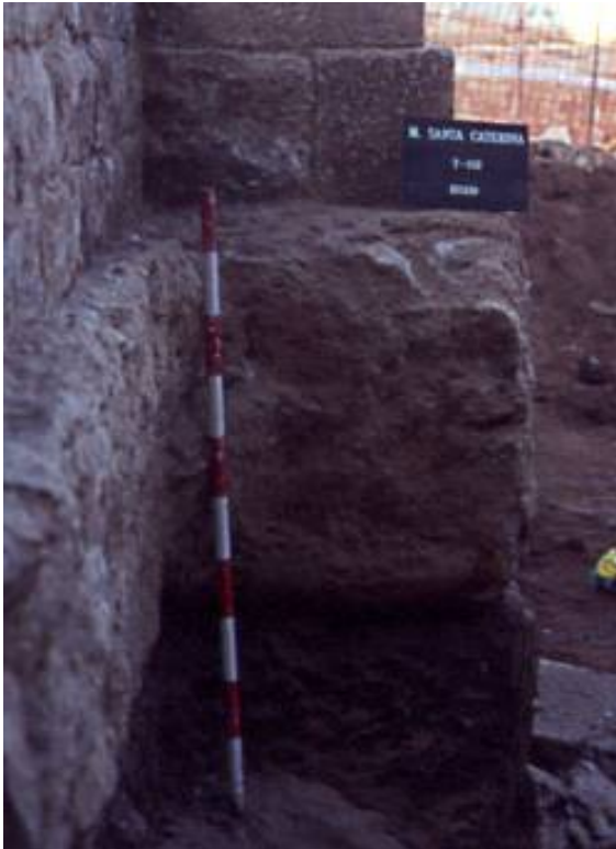
Fotografia núm. 5992. Vista del contrafort.
