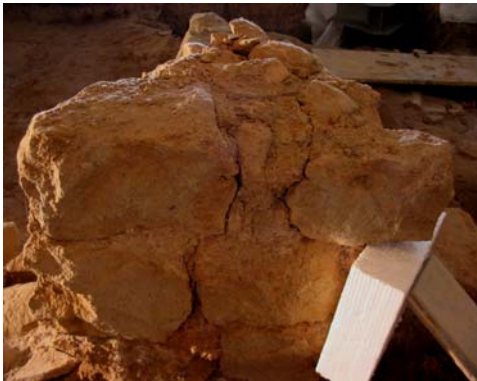
Apuntament en el mur U.E. 9201. Perill d'esfondrament per noves fissures detectades
