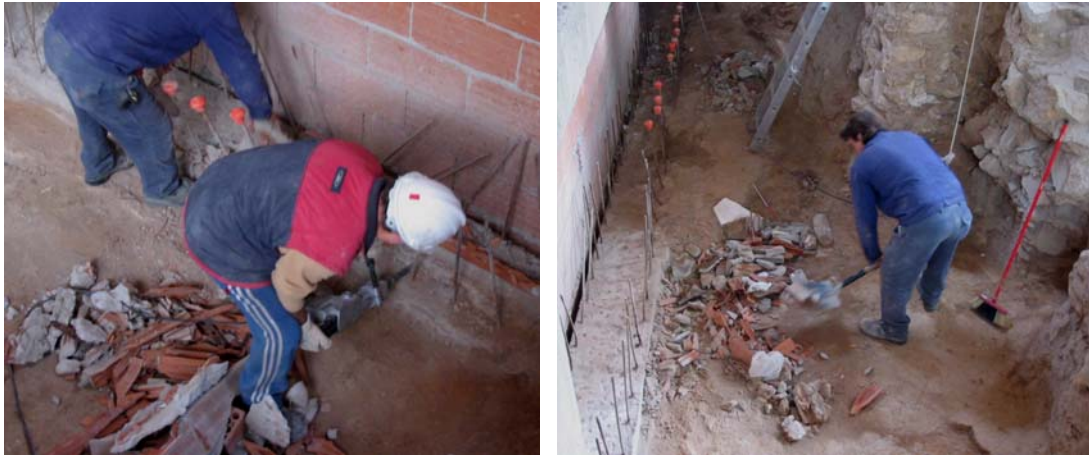
Eliminació del mur de maó amb el martell pneumàtic, després s'elimina la runa mecànicament
