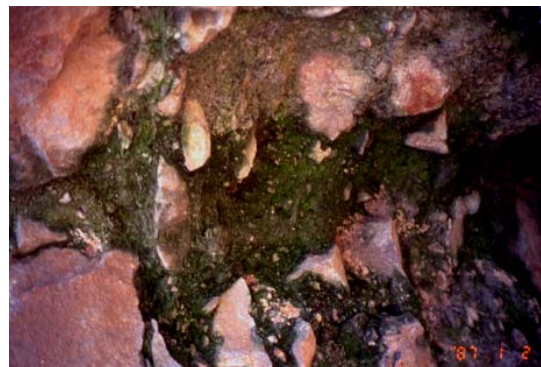
Exemple d'atacs biològics en el fons d'una tomba i a sobre d'un mur
