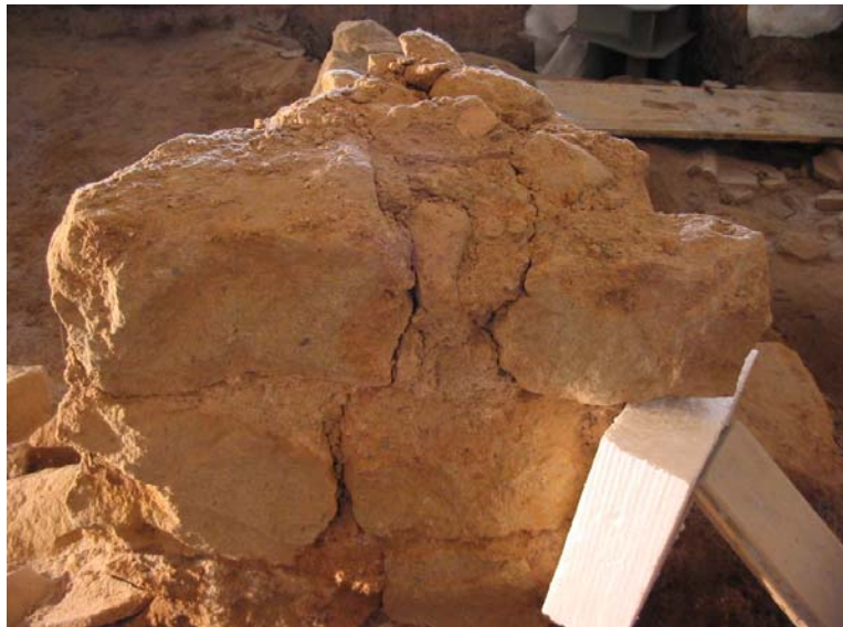
Fissures i esquerdes observades en la U.E. 9206
