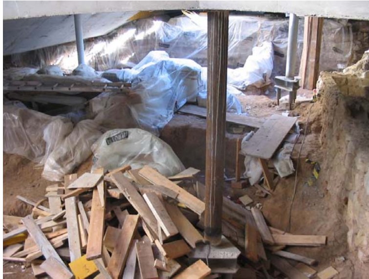
Acumulació de material de les tasques de desencofrat
