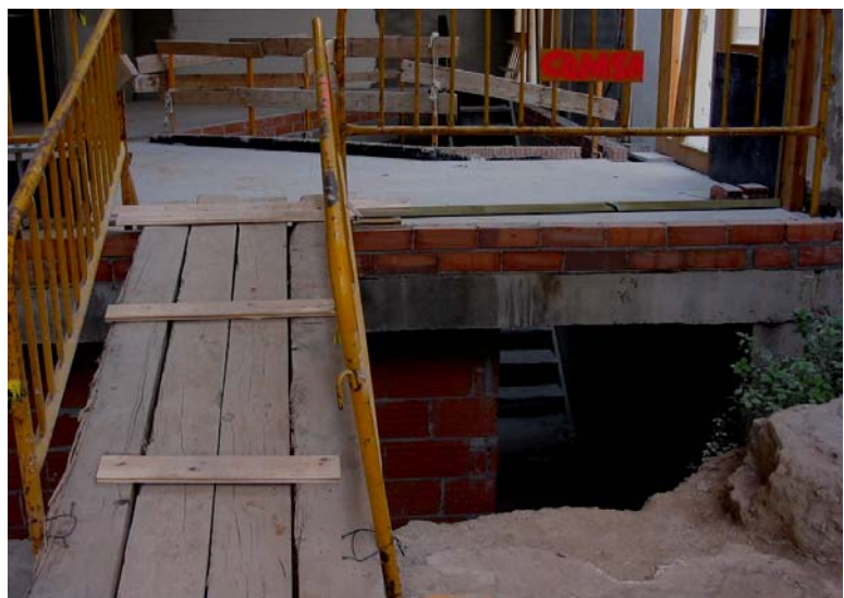
Rampa creada per a limitar l'accés a la zona de reserva
