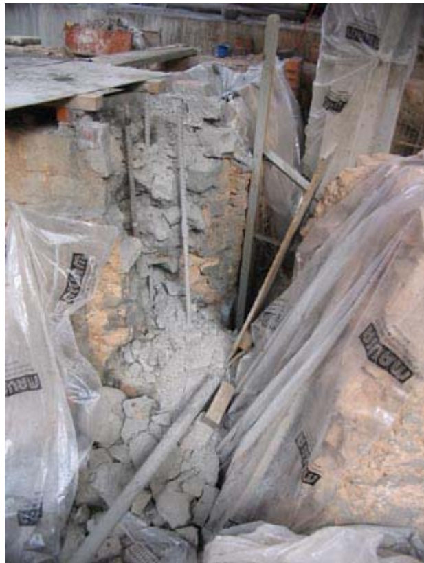
Estat de l'absidiola una vegada finalitzades les tasques de micropilotatge
