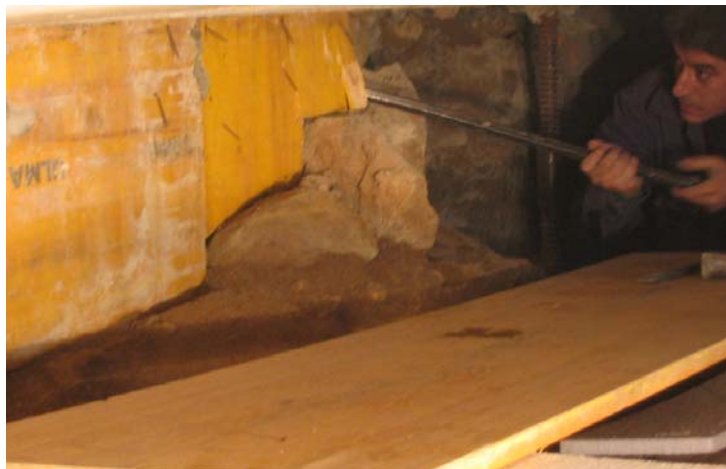
Diversos moments dels treballs d'extracció dels materials d'encofrat
