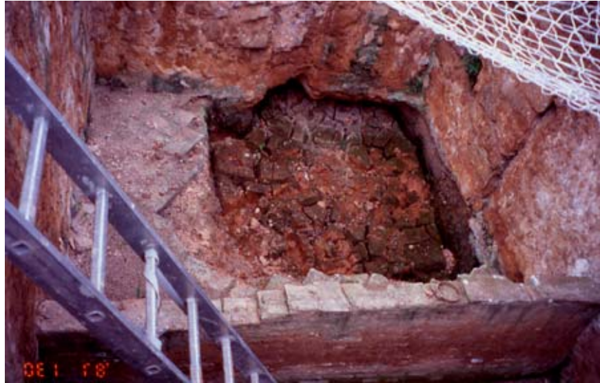
Estat de la U.F. 417 després de la filtració de bentonita
