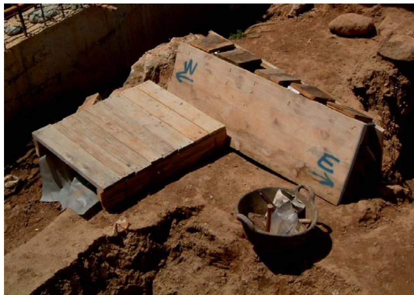
Detall de les proteccions de fusta
