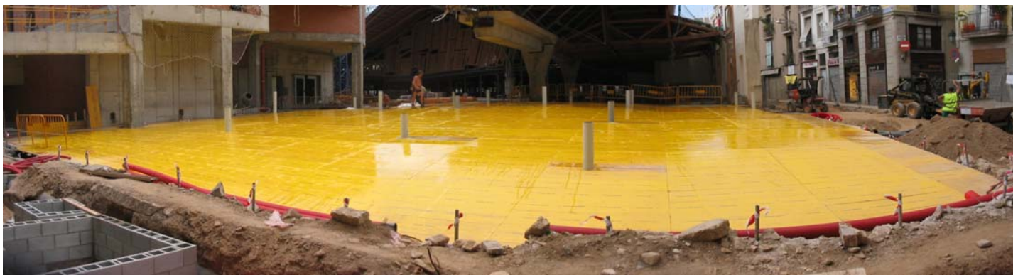
Vista global de l'estat final de l'encofrat
