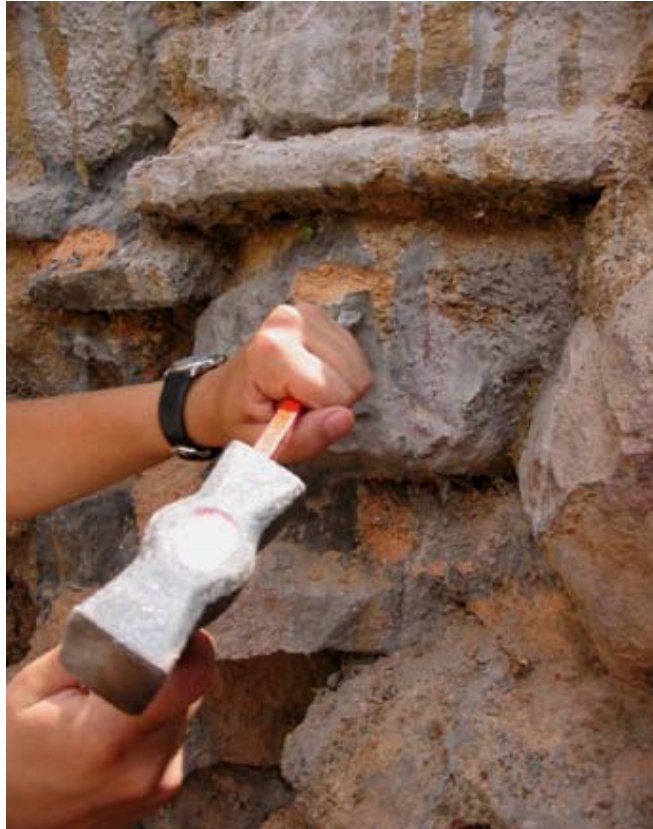
Eliminació mecànica dels ciments ajudant-nos d'escarpes de diferents mides i maceta
