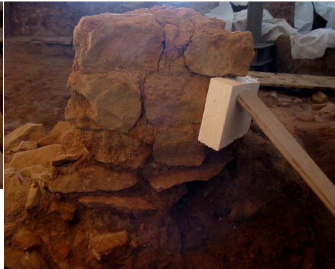
Apuntament en el mur U.E. 9201. Perill d'esfondrament per noves fissures detectades
