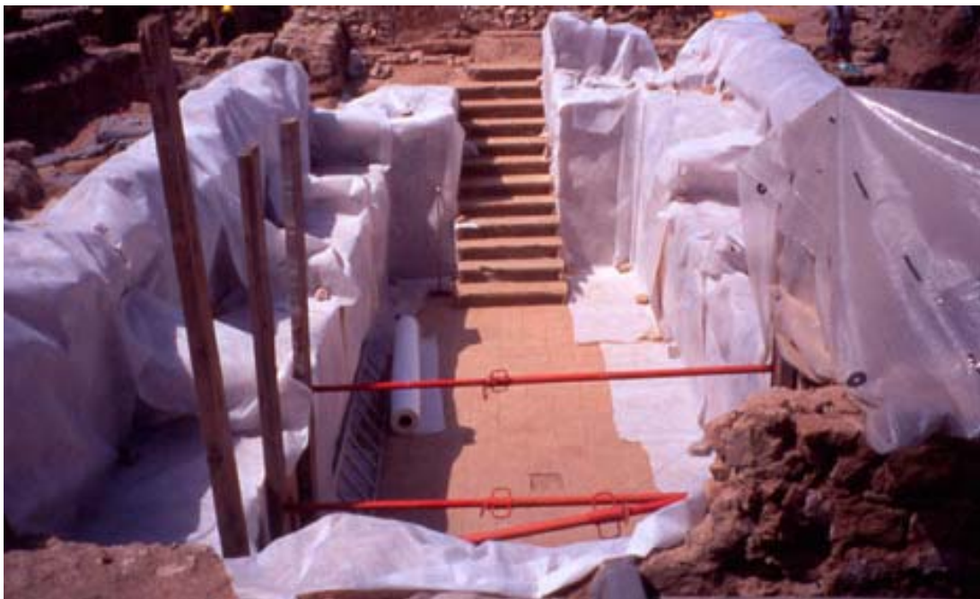
Moment de l'execució de les tasques de protecció de l'estructura
