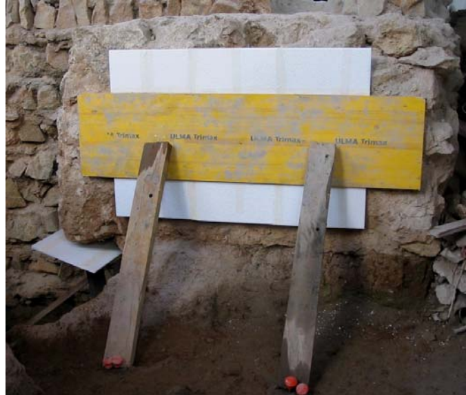
Apuntament de les restes del mur de la Sagristia (U.E.4215)
