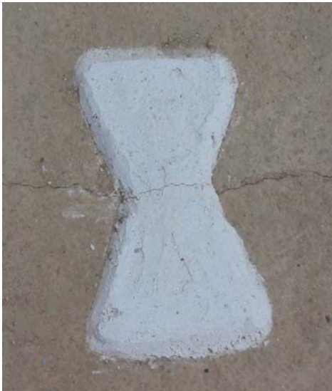
Detall de l'escolada de ciment en la superfície de l' opus signinum . Es pot observar que s'han obert més les fissures ja existents cosa que reflexen els testimonis de guix fets
