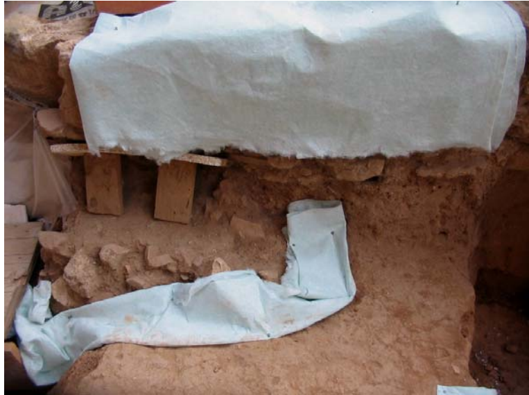
Col·locació de les primeres capes de geotextil
