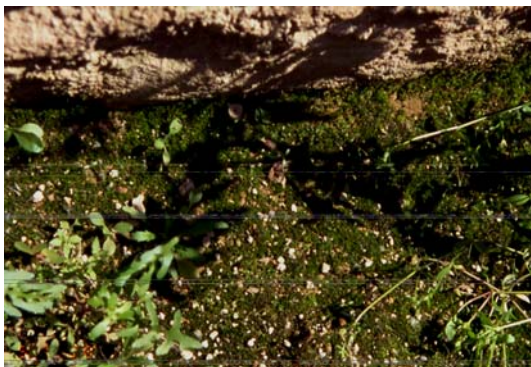
Exemple d'atacs biològics en el fons d'una tomba i a sobre d'un mur
