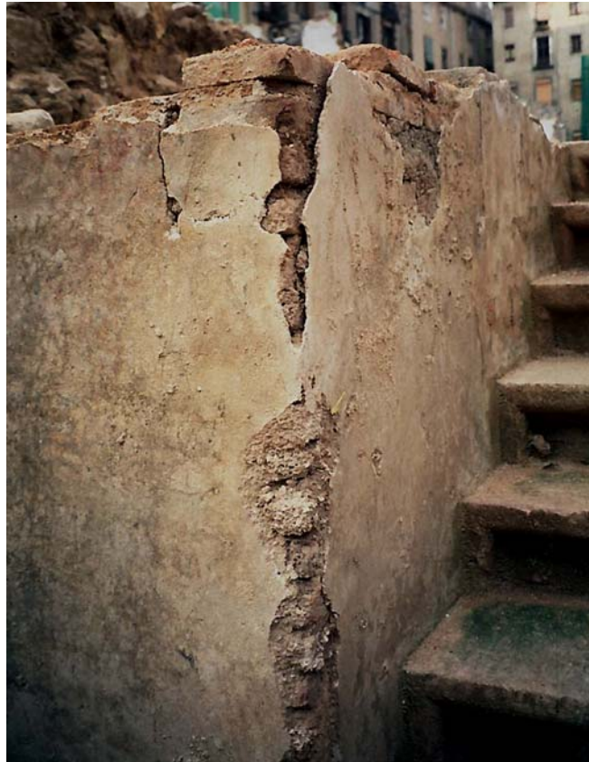
Detall de la cantonada de l'escala d'accés a la cripta
