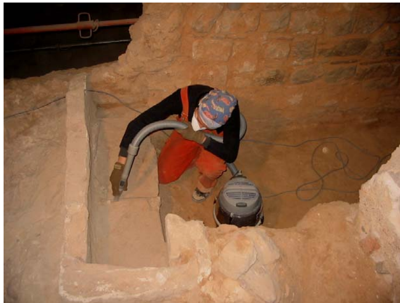
Moment de l'eliminació de l'abrasiu amb l'ajut d'un aspirador
