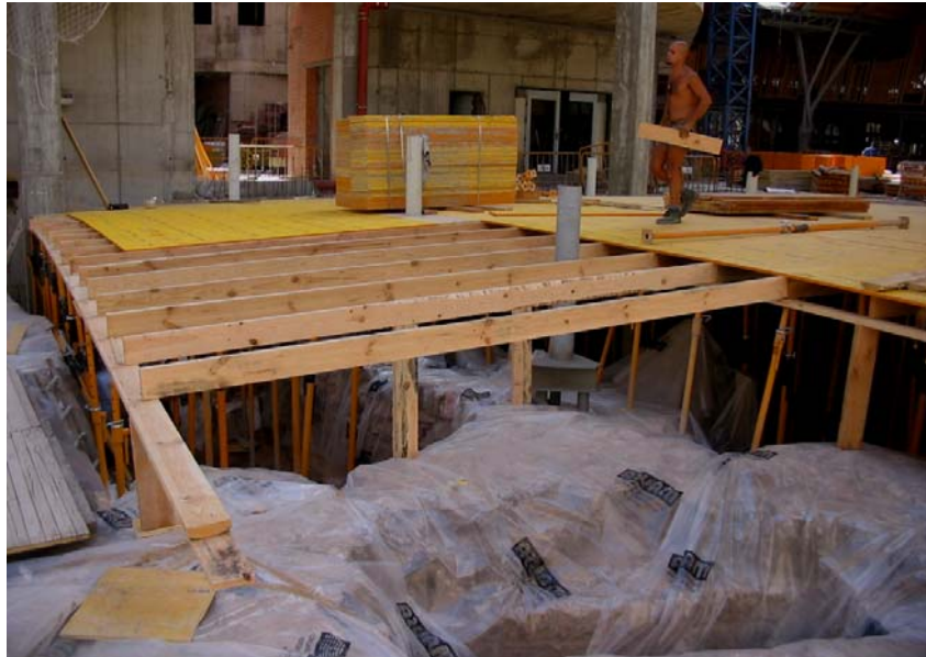
Vista del moment de la col·locació dels taulons, que s'adapten als diversos pilars
