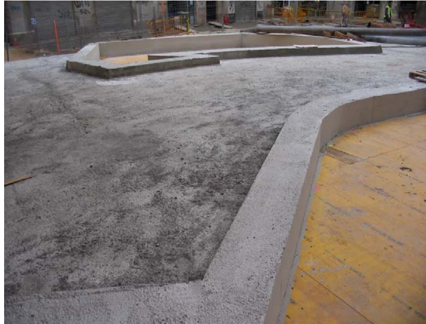
Un altre detall després de l'abocament del formigó
