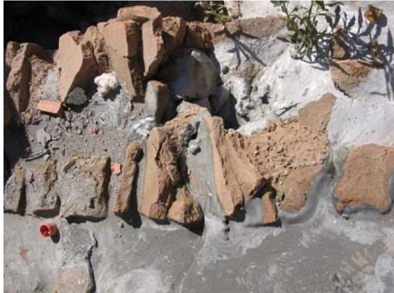
Estat del mur després de les tasques de micropilotatge
