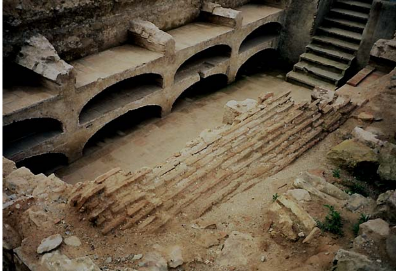
Arrencament de volta conservat
