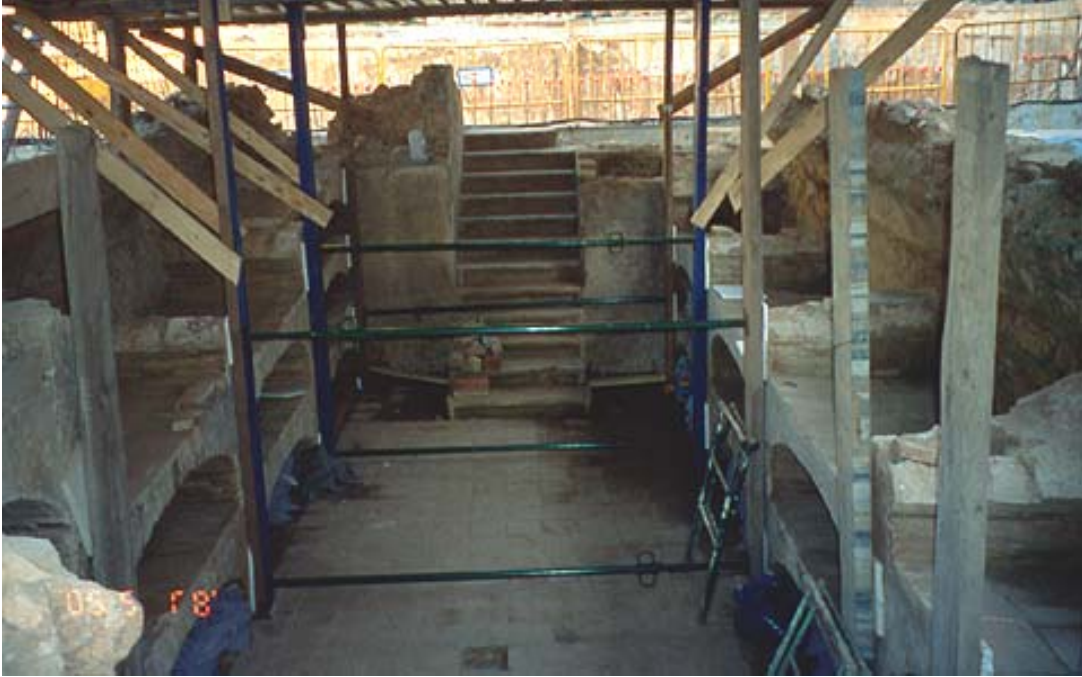
Vista interior de la coberta
