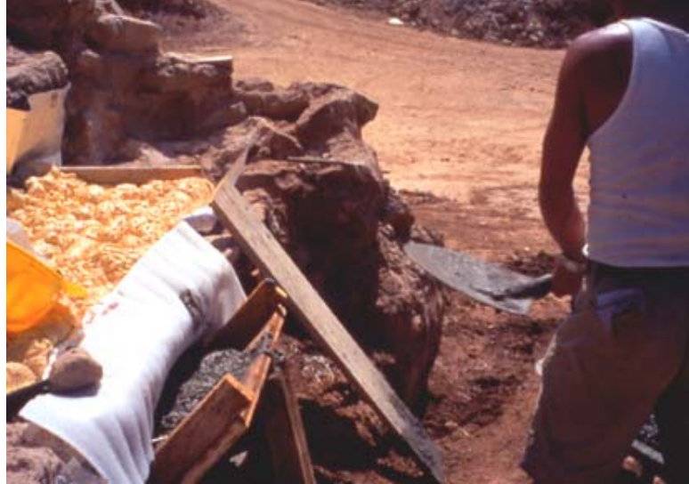
Construcció de la llosa de formigó
