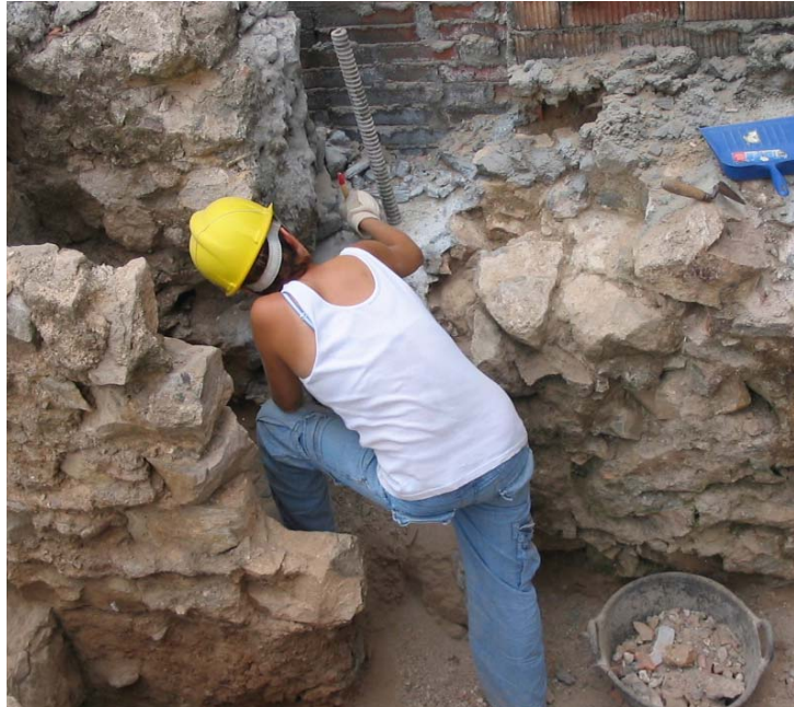
Neteja mecànica al voltat d'un micropilot
