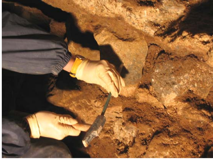
Capçalera poligonal de l'absis. Moment de l'eliminació de ciment amb l'ajut d'escarpa i martell
