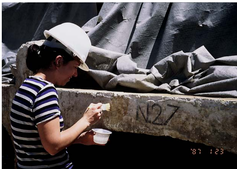
Moment de l'aplicació de l'aigua de calç en els lliscats extersiors dels nínxols
