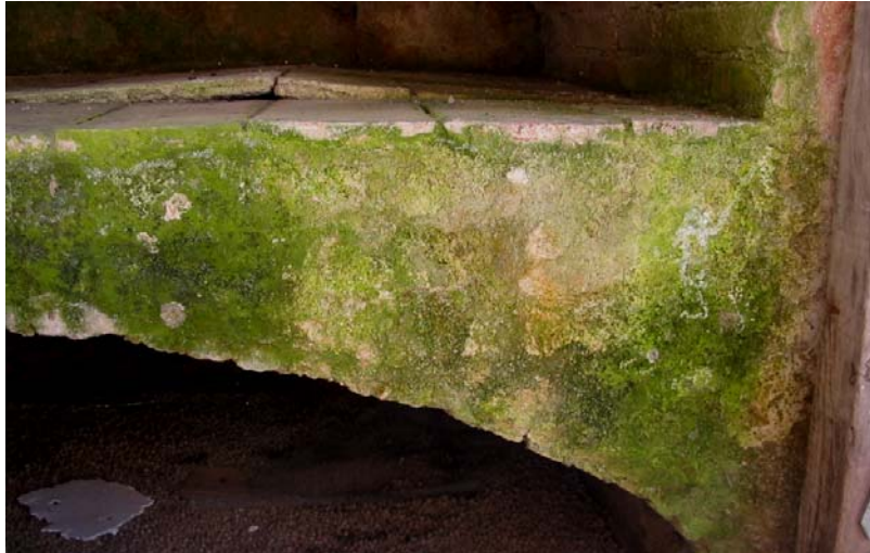
Detall de dues rajoles aixecades en el interior d'un nínxol
