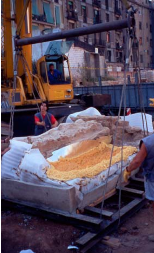
Moment de l'extracció del mur i la formae que té associada
