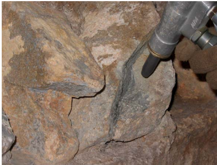
Moment de la projecció amb microesferes de vidre, en el que s'elimina el ciment de la pedra
