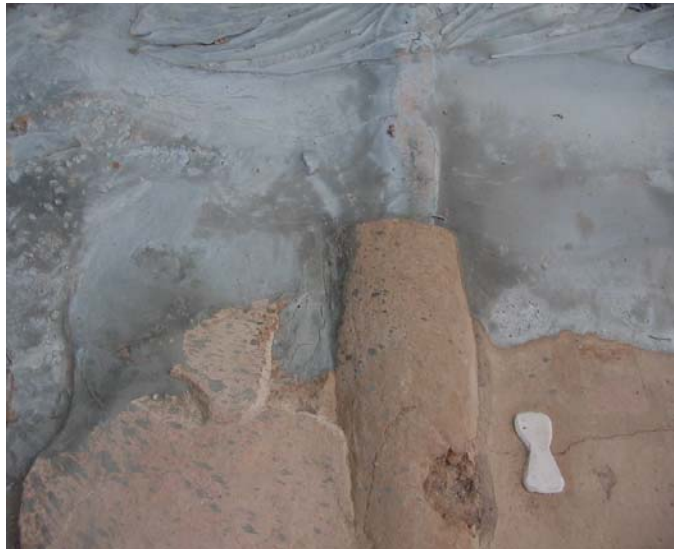
Detall de l'escolada de ciment en la superfície de l' opus signinum . Es pot observar que s'han obert més les fissures ja existents cosa que reflexen els testimonis de guix fets
