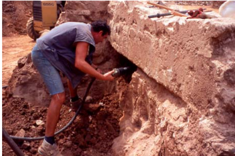
Rebaix de la part inferior del mur associat a la formae
