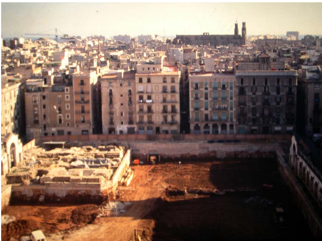
Vista de la zona de reserva preservada, després de la construcció de les pantalles del nou mercat.
