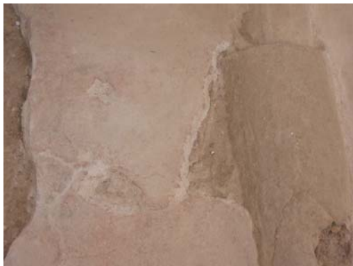
Detall de la reintegració de petites esquerdes i llacunes així com del bisellat de la totalitat del contorn de la tomba
