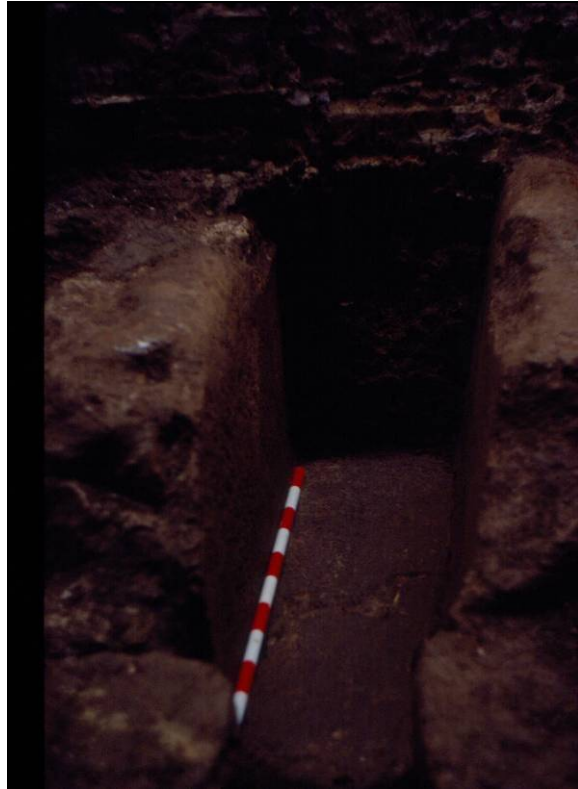
Foto 111: Claveguera romana UE 115, al carreró d'en Groc, un cop excavat el seu farciment
