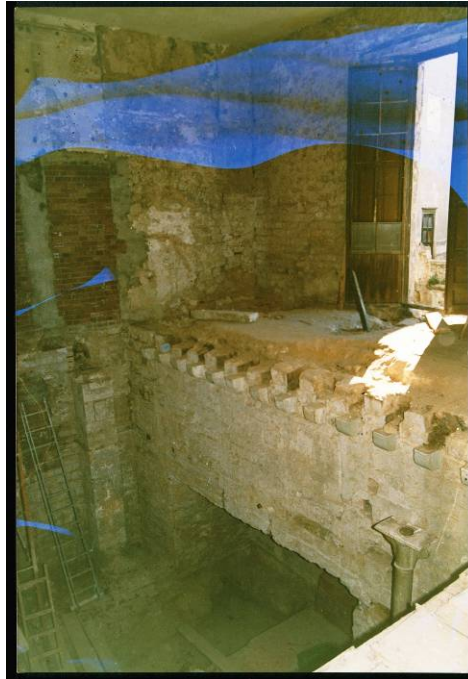
Foto 30: Imatge, parcialment degradada, on s'observa la cavitat artificial oberta al parament fundacional en època medieval i la cota conservada de la muralla, a sobre
