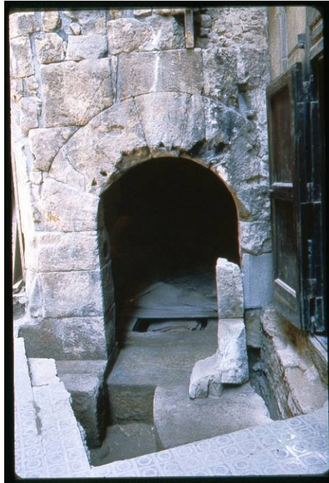
Foto 47: Vista general del costat exterior del pas per a vianants de la porta romana marítima en procés de musealització
