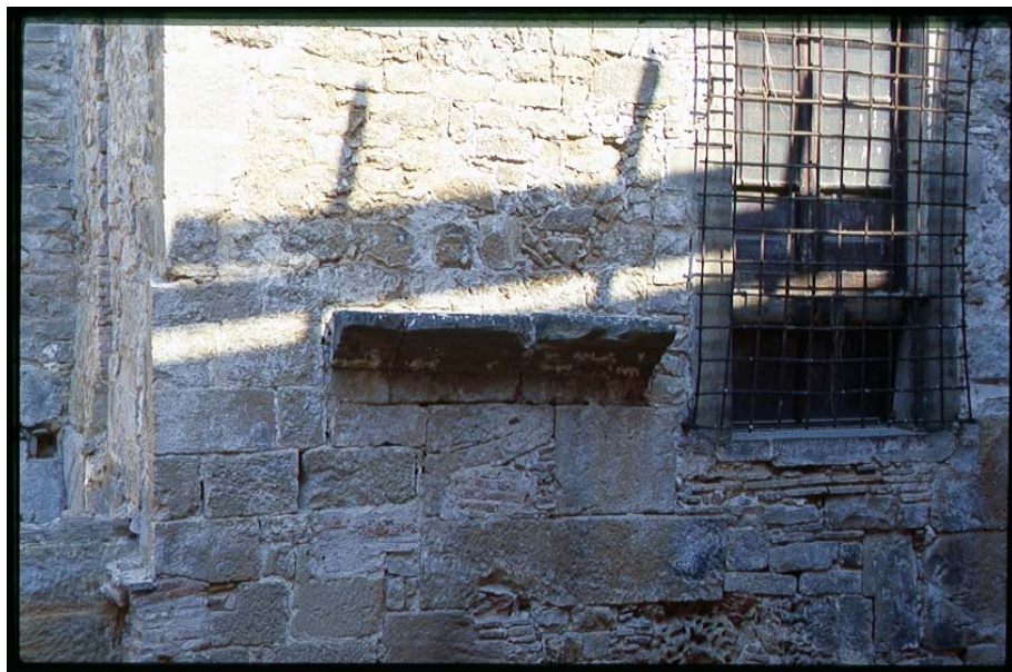
Foto 58: Restes de la cornisa original que rematava la part de les torres baiximperials construïda amb opus quadratum. Torre 35 al pati amb accés des de Correu Vell i carreró d'en Groc
