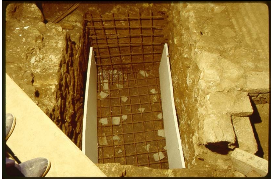
Foto 84: Palau Llimona – Protecció amb planxes de poliestirè expandit (EPS) conegut normalment com a “porexpan” abans de formigonar la cala per a la nova fonamentació de l'edifici
