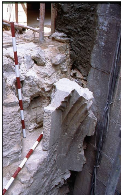
Foto 23: Arrencament d'una aresta pertanyent a una de les voltes originals de la capella de Sant Cristòfol, reformada durant la segona meitat del segle XIX
