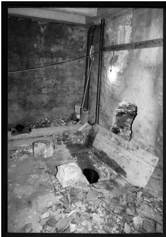
Foto 60: Localització d'un pou a l'edifici d'origen gòtic del Pati d'en Llimona
