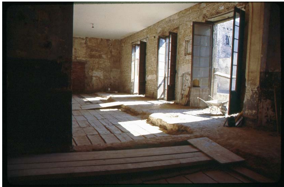
Foto 19: Una altra imatge de la sala noble. Aquesta sala tenia el doble d'amplada que la planta baixa en aprofitar el pas de ronda de la muralla romana (part on el paviment és massís, sense fustes)
