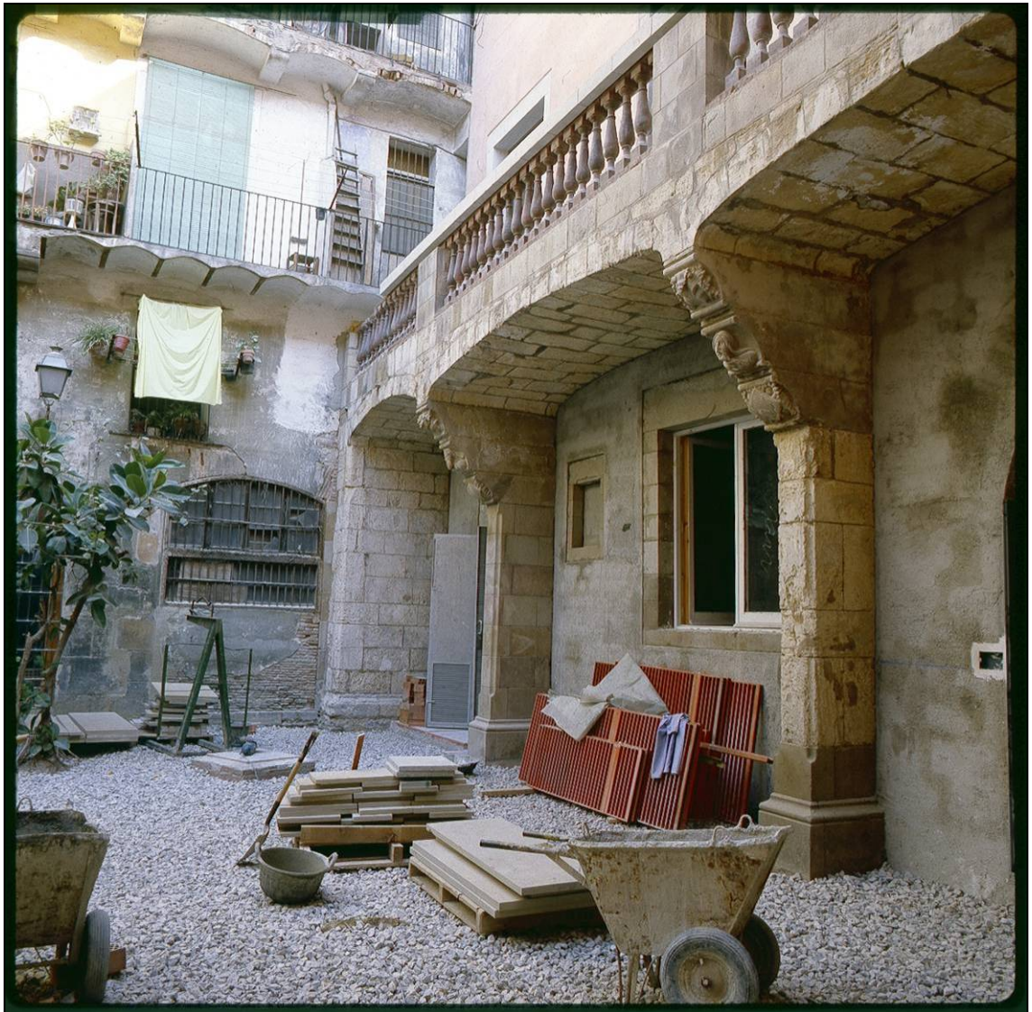
Foto 52: Treballs d'adequació del Pati d'en Llimona amb la naia gòtica ja restaurada
