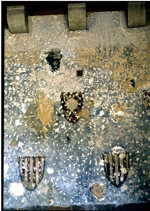
Foto 08: Pintures medievals amb motius heràldics descoberts durant el procés de restauració
