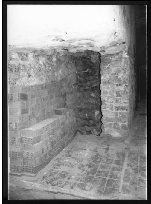
Foto 03: Vista de l'escapçament que s'efectuà en època medieval al costat interior de la muralla romana fundacional. Àmbit 0.08 amb la cala 84-85 en primer terme (vista uns anys més tard de la seva realització)
