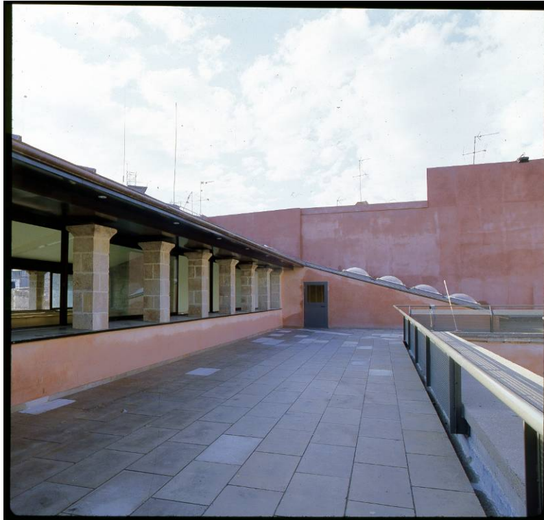
Foto 62: Part superior de l'edifici del Pati d'en Llimona un cop finalitzada la restauració-adequació
