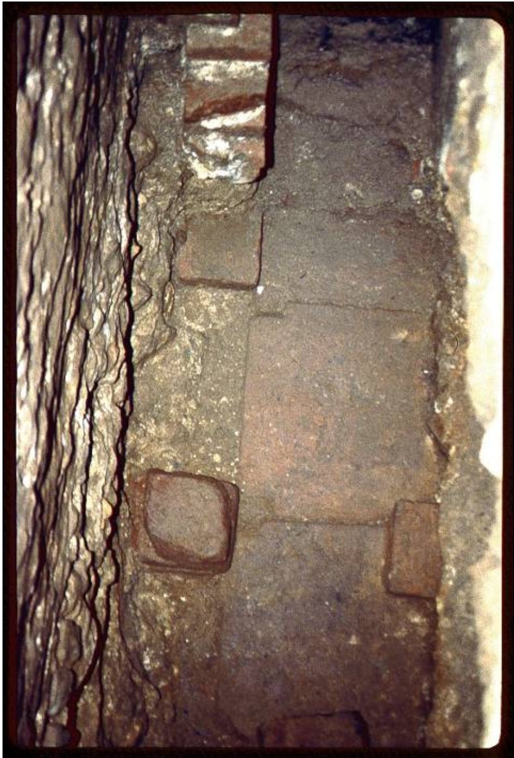
Foto 81: Palau Llimona – Detall de les restes del sistema de suport de la suspensura de la sala calefactada localitzada mitjançant el sondeig D
