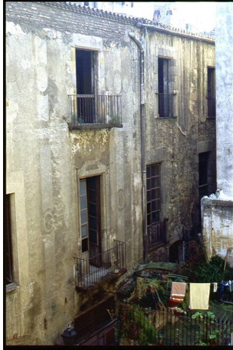
Foto 07: Vista de la façana d'època moderna de l'edifici del carrer de Sant Simplicí / Pati d'en Llimona, abans de la seva restauració
