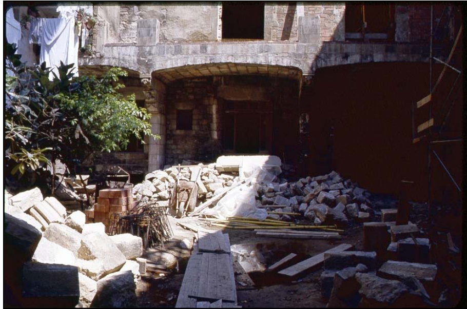
Foto 50: Pati d'en Llimona durant els treballs de restauració
