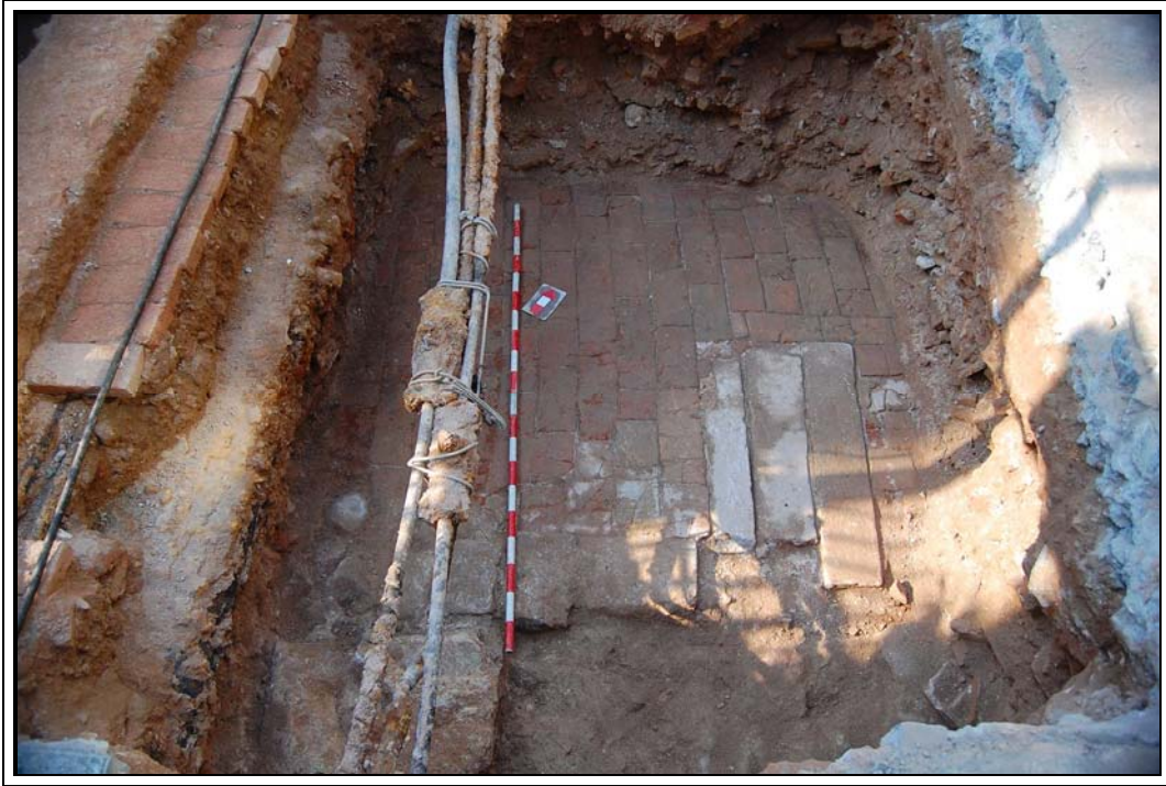
Foto 6. Vista general del paviment Ue 203 i coberta 204 al sondeig 2.
