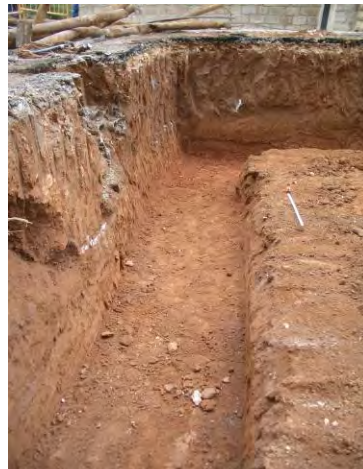
Detall de la rasa per la realització del muret guia en la zona oest
