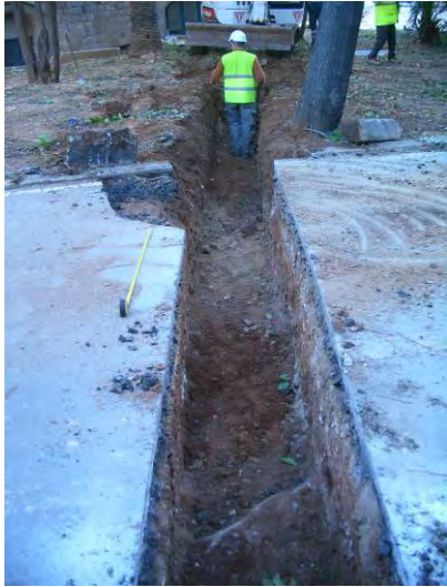
Vista SO-NE de l'inici de la rasa 1000
