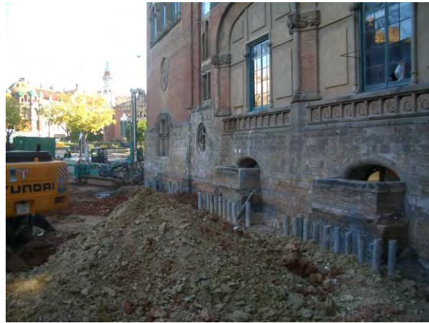
Vista SO-NE de la línia de micropilots al voltant de l'edifici d'Administració
