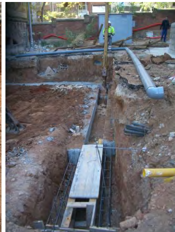
Detall de la realització de la rasa per les pantalles
