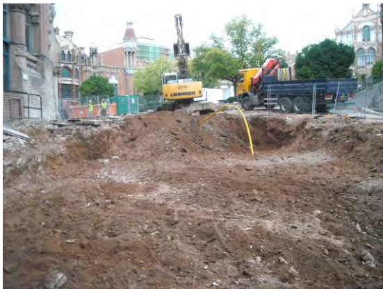
Vista SE-NO del rebaix realitzat davant el pavelló d' Administració
