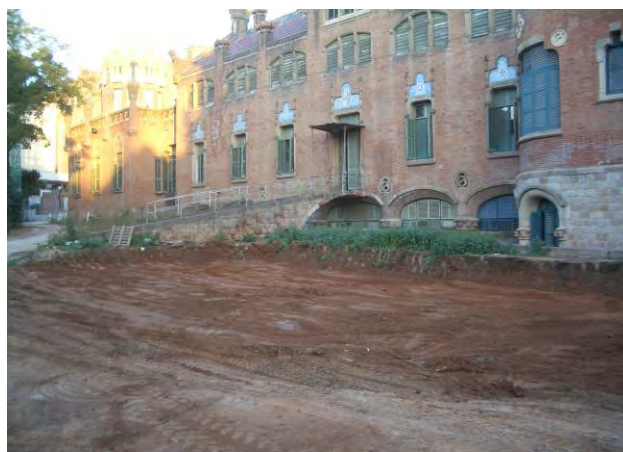
Vista NE-SO de l'inici del rebaix, amb el pavelló de Mare de Deu de la Mercè al fons
