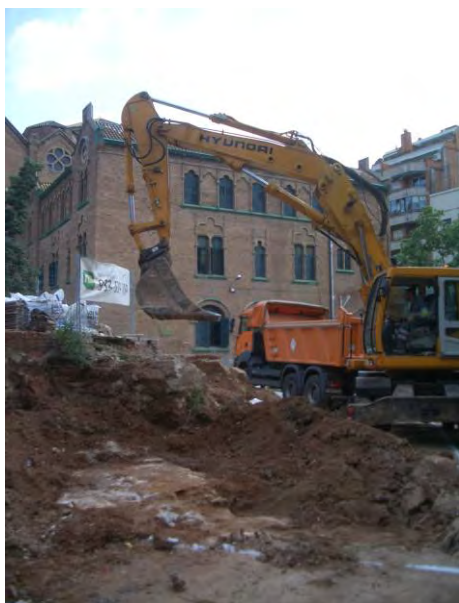
Situació del rebaix, amb l' església i l'Escola d'Infermeria al fons
