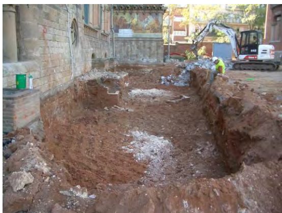
Vista NE-SO del rebaix realitzat davant el pavelló d' Administració
