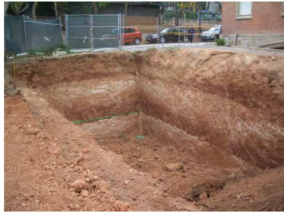
Vista SE-NO del rebaix finalitzat, amb l'estratigrafia documentada
