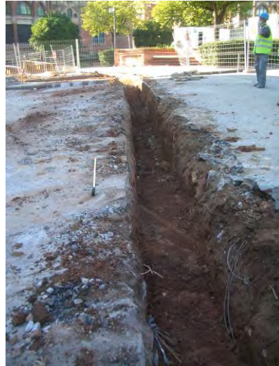
Vista SE-NO del tram final de la rasa 1000
