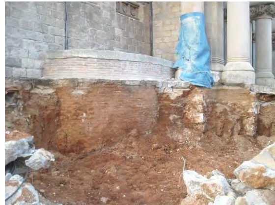
Detall de la fonamentació de l'edifici
