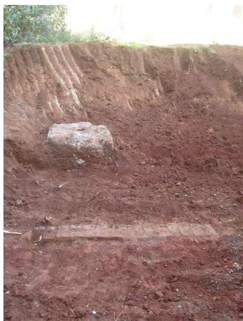
Vista S-N de l'estructura ue 205 durant el procés de rebaix, amb l'ue 204 i diferents serveis relacionats amb l'Hospital
