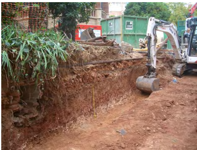
Vista SO-NE de la rasa, amb les argiles naturals a 1.85 m de la superfície
