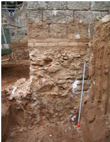
Detall de la fonamentació de l'edifici d'Administració
