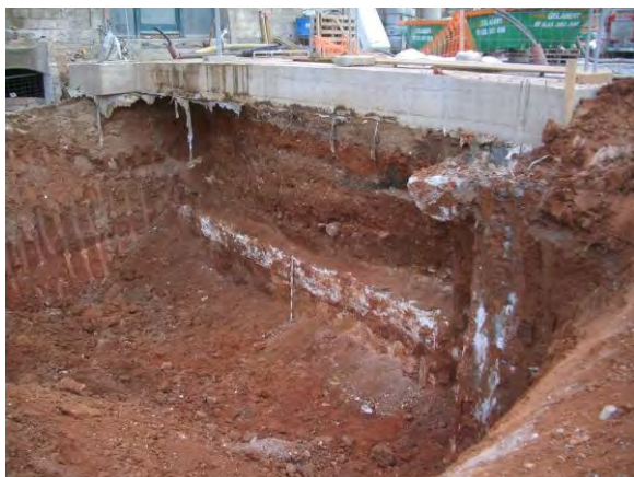
Vista E-O del mur ue 1004, documentat en l'entrada del túnel, amb la façana d'Administració al fons
