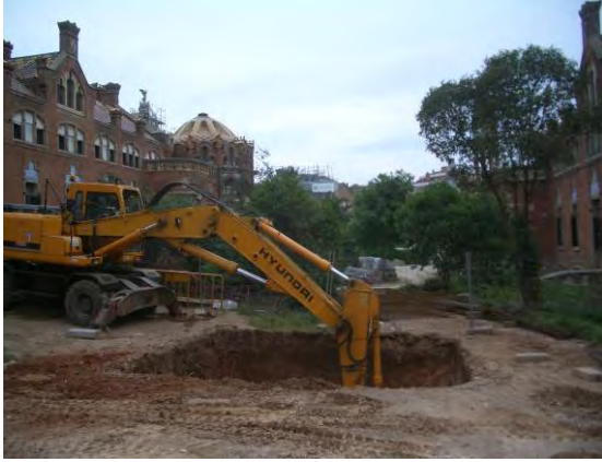
Vista O-E de la situació del rebaix entre els dos pavellons
