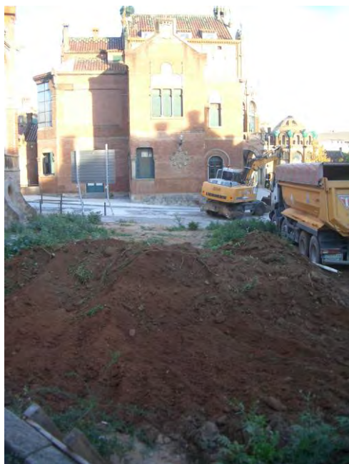
Vista O-E de les feines de rebaix, amb el pavelló d'Operacions al fons
