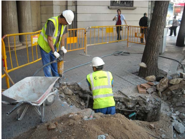
Procés manual d'eliminació de la pavimentació.
