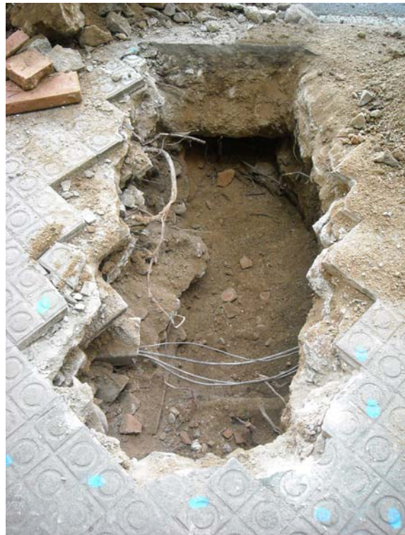
Tram inicial de la rasa on s'aprecia amb claredat el cablejat dels semàfors i un paquet de runa. És el punt que es va assolir més fondària.
