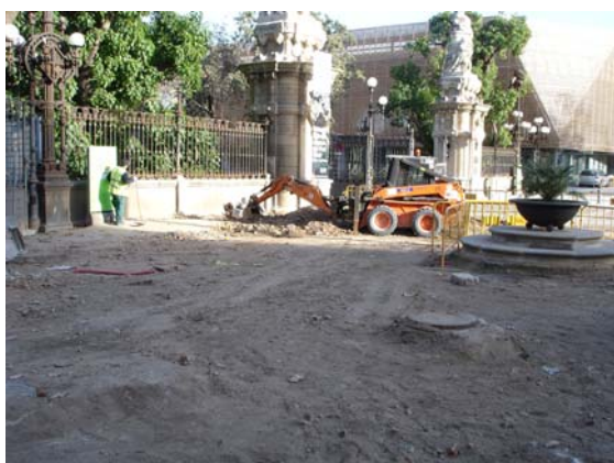
Vistes dels treballs de rebaix del nivell superficial de sauló del passeig.
