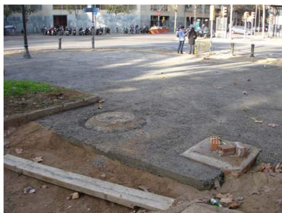
Vistes dels treballs de recobriment del passeig amb sauló i formigonat del xamfrà nord-oest.
