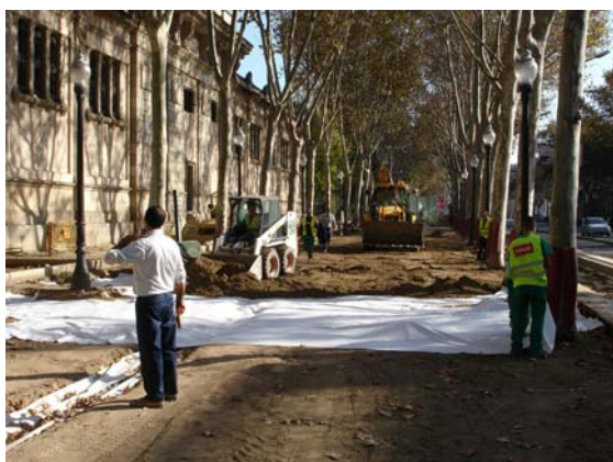
Vistes dels treballs de recobriment del passeig amb sauló i formigonat del xamfrà nord-oest.
