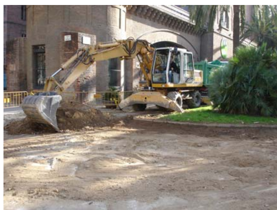
Vistes dels treballs de rebaix del nivell superficial de sauló del passeig.
