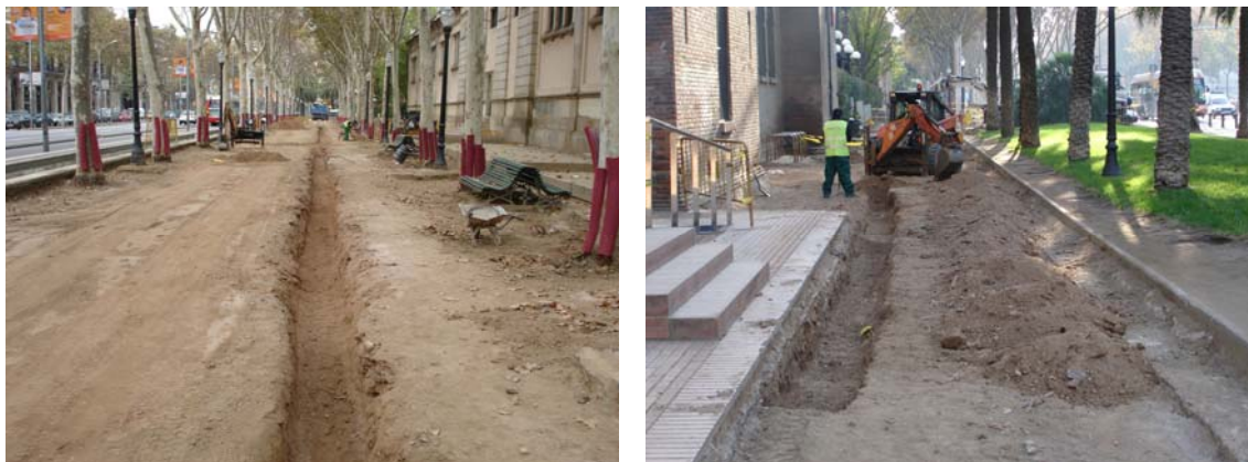
Vistes dels treballs d'excavació mecànica de la rasa.
