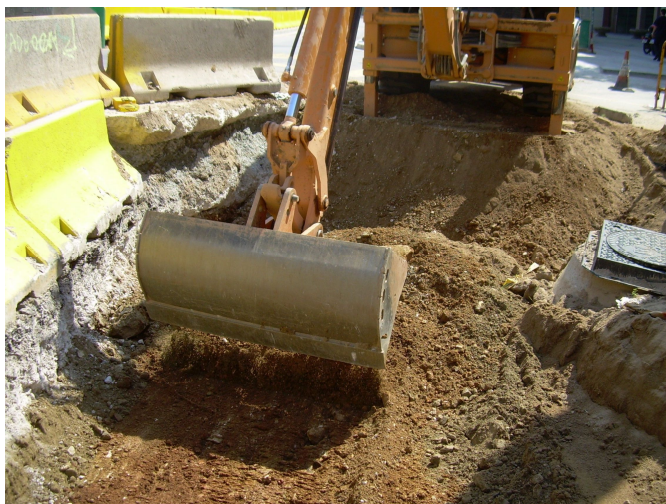
Maquina excavadora rebaixant el reompliment
