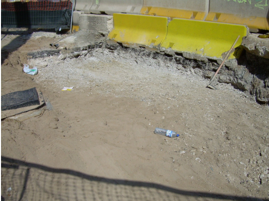
Zona objecte de l'excavació en el moment de la nostra arribada
