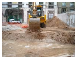
DSCN0377 Rebaix mecànic Rasa 4
