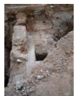
DSCN0374 Excavació paviment 1015
