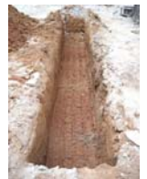
DSCN0334 Rasa 3 Final primer tram
