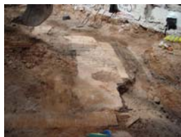
DSCN0376 Rebaix mecànic
