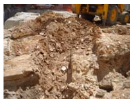
DSCN0372 Excavació en extensió tasques de rebaix...
