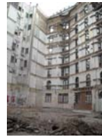
DSCN0272 Vista reforç estructural
