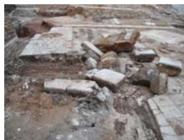
DSCN0482 Afectació paviment u.e. 1013
