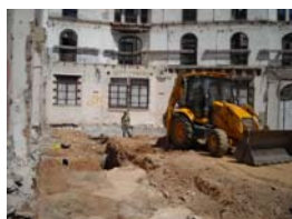
DSCN0371 Excavació en extensió tasques de rebaix...
