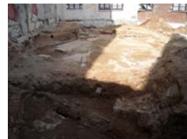
DSCN0399 Vista general des de l'Oest
