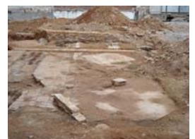
DSCN0479 Detall àmbit casa
