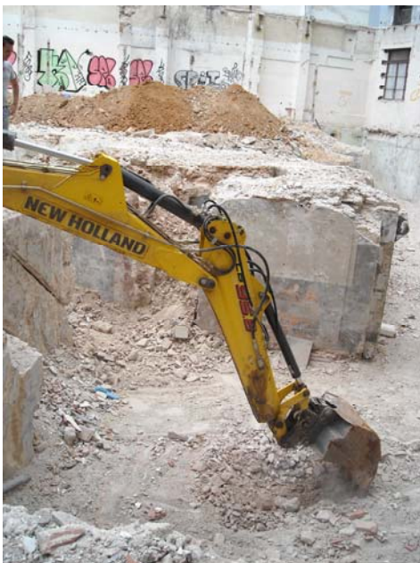
Procés d'excavació del sondeig i detall on s'observen les argiles naturals
