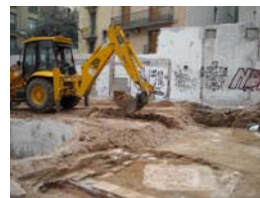
DSCN0378 Rebaix mecànic Rasa 4
