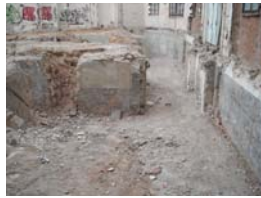
DSCN0270 Vista soterrani
