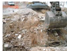
DSCN0483 Afectació estructures documentades
