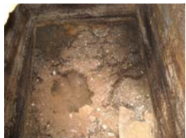
DSCN0289 Rasa 1 interior col·lector u.e. 1009
