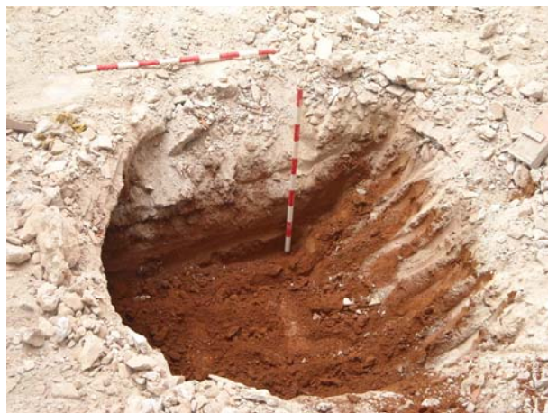
Procés d'excavació del sondeig i detall on s'observen les argiles naturals
