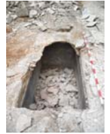
DSCN0314 Fossa sèptica costat Rasa 2
