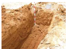
DSCN0335 Rasa 3 Final primer tram
