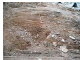
DSCN0484 Inici segona fase
