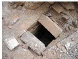
DSCN0286 Rasa 1 Col·lector u.e. 1009
