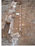
DSCN0521 u.e. 1042 i mur 1043
