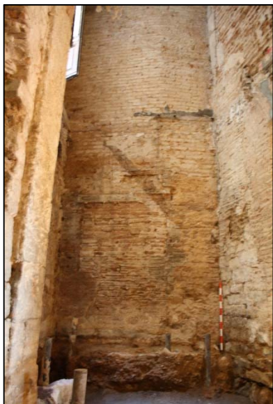
Fotografies 192 i 193. Mur de la finca del segle XVIII UE810 amb detall de la banqueta de fonamentació.
