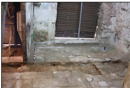
Fotografia 5. Reparació amb maons del paviment de lloses UE105
