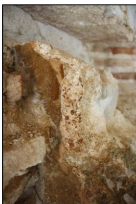
Fotografia 185. Detall de l'interior de l' specus revestit amb opus signinum
