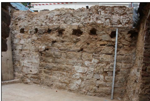
Fotografia 133. Mur que limita amb el pati elevat, UE7025.
