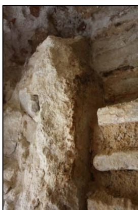
Fotografia 185. Detall de l'interior de l' specus revestit amb opus signinum
