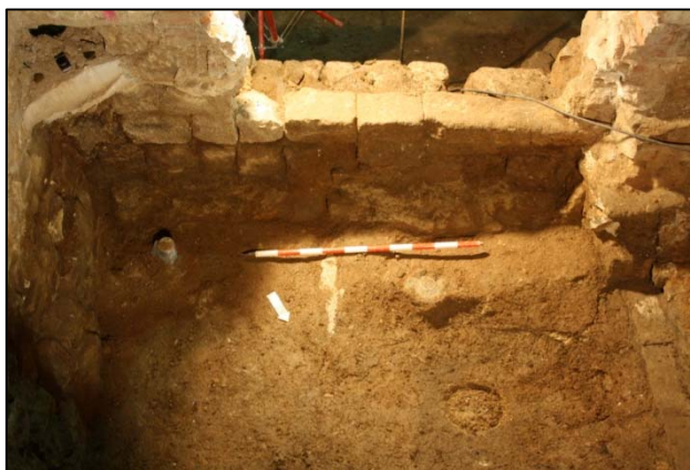
Fotografia 110. Cara exterior del mur de façana de l'hostal d'en Garcia amb banqueta de fonamentació.
