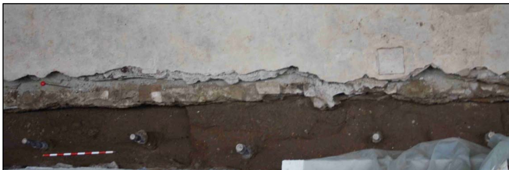
Fotografia 126. Detall de la reparació de la via romana UE639.
