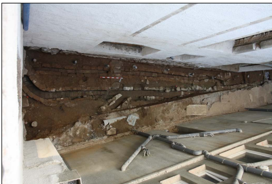
Fotografia 118. Vista general amb sortida de la claveguera medieval UE5014 i nivell de circulació de l'androna UE642.
