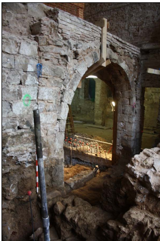
Fotografia 158. Mur de tancament nord de la finca segle XIII UE761 amb mur i arcada UE749.
