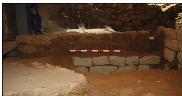
Fotografia 170. Alçat mur UE788.
