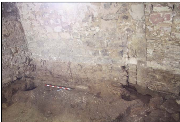
Fotografia 73. Banqueta de fonamentació del mur del segle XVI UE505.
