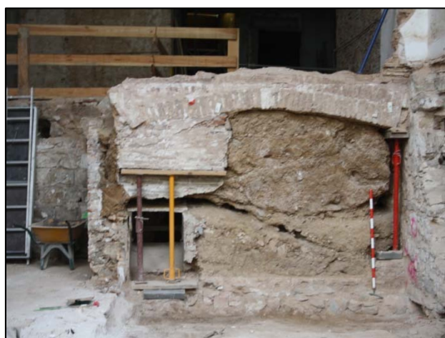
Fotografia 135. Mur de tapia UE700.
