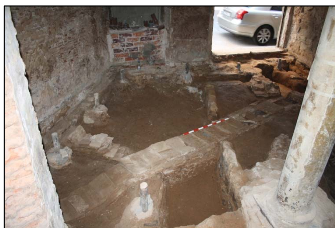
Fotografia 196. Claveguera UE802 amb ramals UE803 i UE804 i envà UE823.
