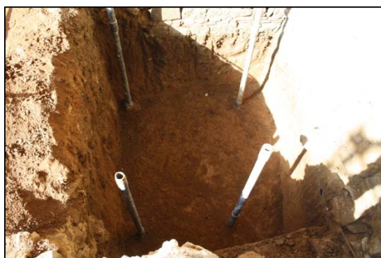
Fotografia 148. Final pou ascensor.
