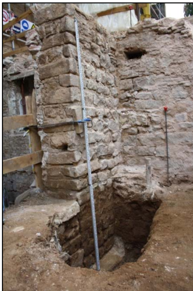
Fotografia 188. Opus vittatum UE7006 del pilar II.
