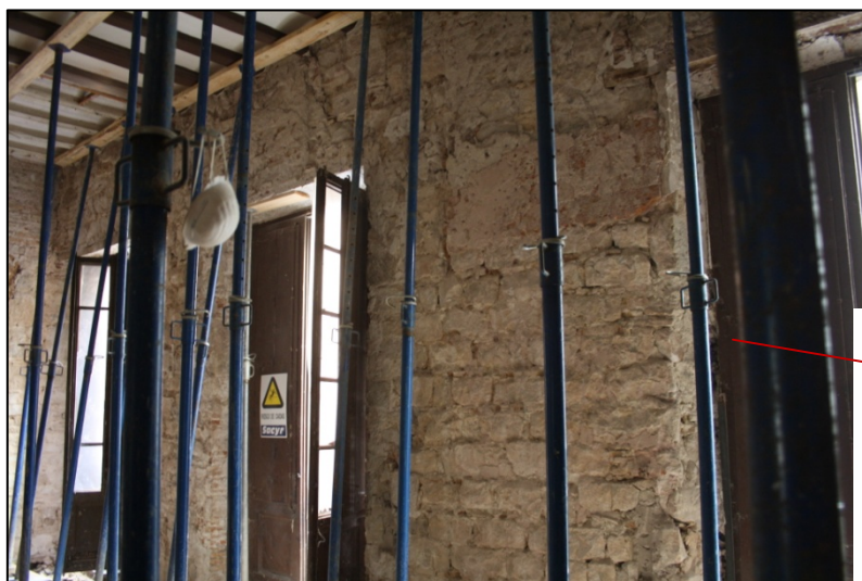
Mur construït amb pedres quadrangulares lligades amb morter de calç.
