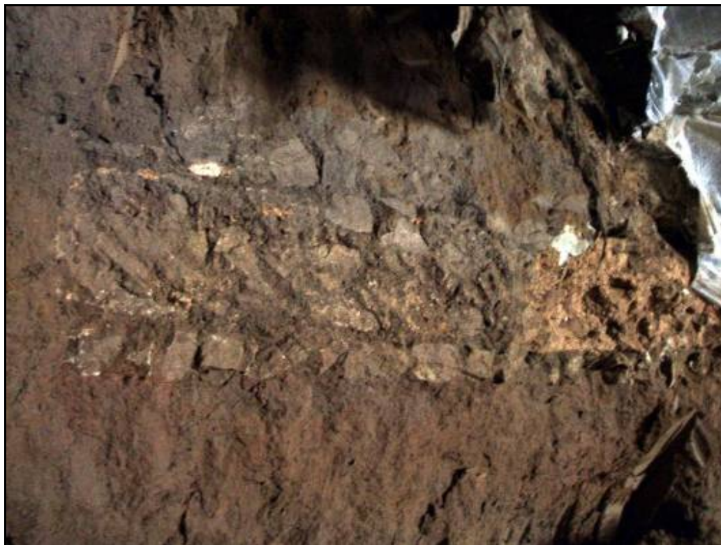
Fotografia 10: Detall del mur anterior
