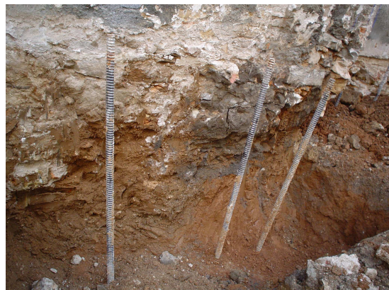
Estat de la fonamentació
