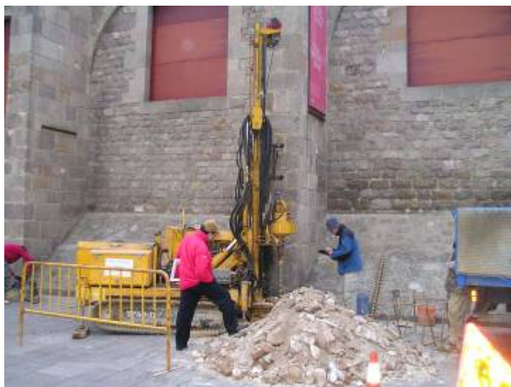
Foto 2. Sondeig geològic previ a la excavació.
