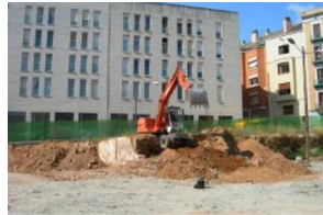
8) Vista general Sector 1.JPG
