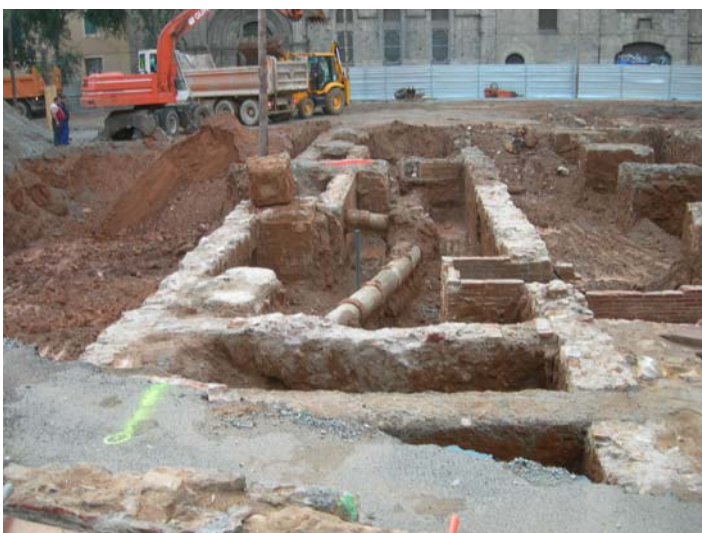
En primer terme els dipòsits 4 i 5. A l'esquerra el mur u.e. 2018 i a la dreta el mur u.e. 2020
