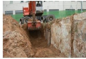
4) Excavació i neteja mur u.e. 1002.JPG
