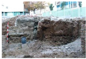
47) Zona A Mur 4073.JPG
