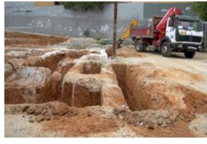
42) Dipòsit 6 i mur u.e. 2020.JPG
