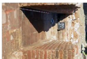
22) Detall rampa sud cendres.J
