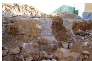
32) Zona B Afectació.JPG
