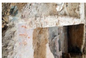
70) Zona B Vista mur Est soterrani.JPG
