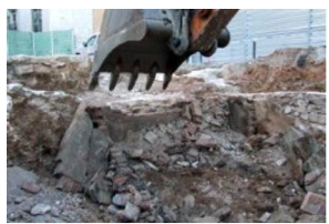
53) Zona A Afectació dipòsit 4023.JPG
