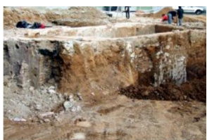
73) Zona B Vista general Soterrani en direcció Sud.JPG
