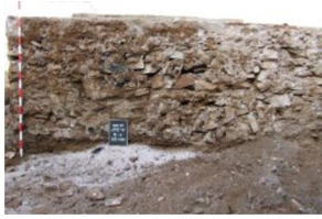
1597 Zona C Mur 4100.JPG
