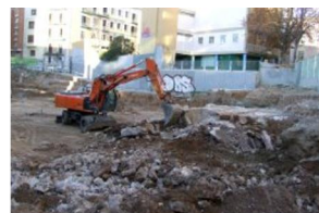
24) Zona B Afectació.JPG
