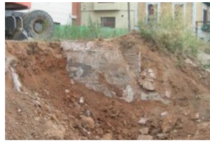
3) Excavació mur u.e. 1002.JPG
