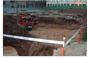
5) Final rebaix Sector 3.JPG
