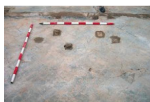
Zona B Fixacions a paviment.
