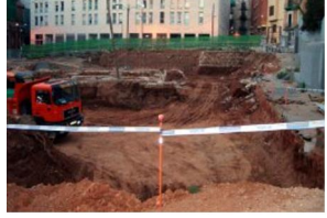
6) Final rebaix Sector 3.JPG
