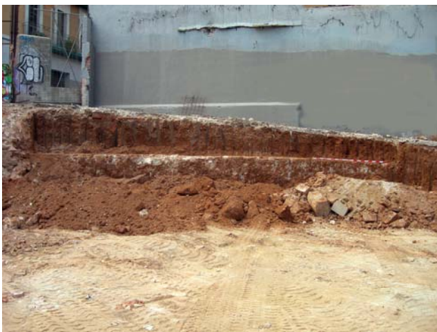
Vista de la canalització u.e. 2004
