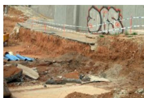
B desmuntatge paviments por
