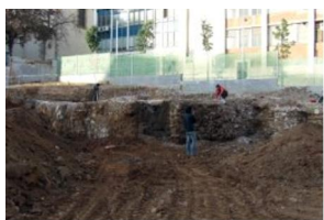
59) Zona B Vista general.JPG
