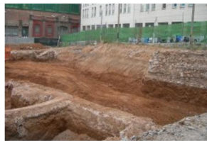
4) Final excavació Sector 1.JP
