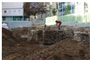
60) Zona B Vista general.JPG
