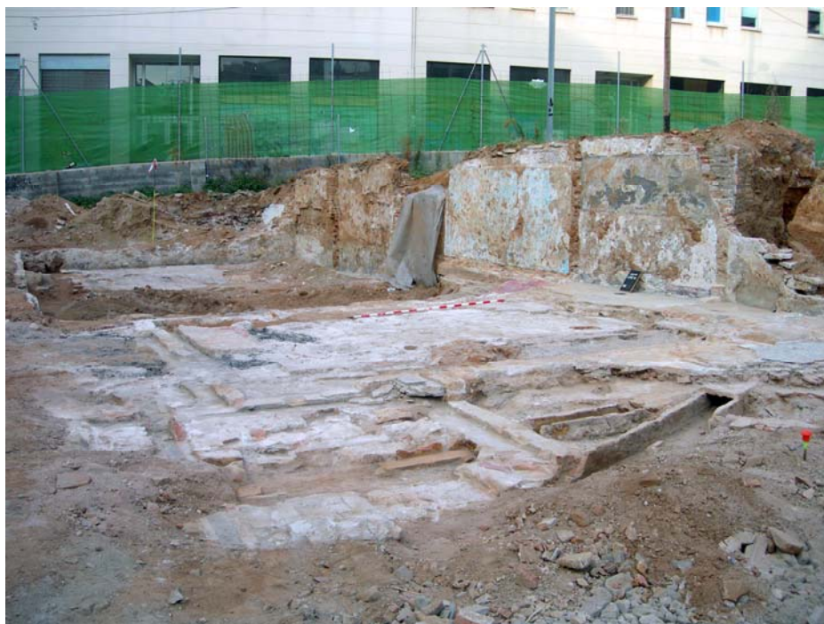
Vista general de l'Espai 1 i l'Espai 2 de l'àmbit 1 (Sector 1) un cop acabada la seva documentació
