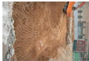
5) Final excavació Sector 1.JP
