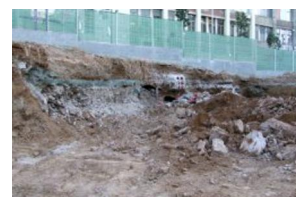
35) Zona B afectació general.JPG
