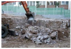
3CF1658 Zona C Afectació Mur 4105
