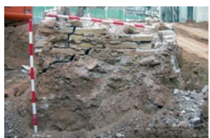
21) Zona A Arqueta.JPG
