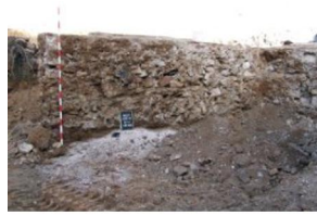
1598 Zona C Mur 4100.JPG
