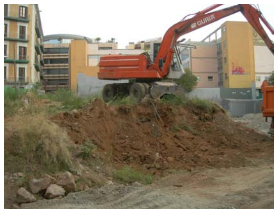
Rebaix del Sector 1
