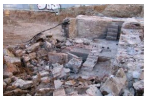
26) Zona B Afectació soterrani.JPG
