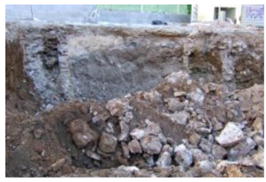
3CF1674 Zona C Afectació.JF
