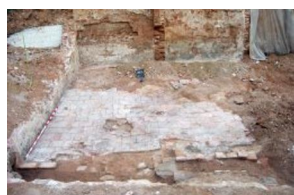
23) Àmbit 1 Paviment u.e. 1015.JPG
