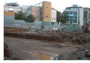
45) Vista general des de l'Oest.JPG
