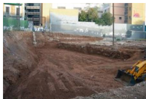
3) Final excavació Sector 1.JP
