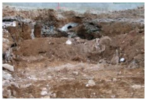
3CF1678 Zona C Afectació.JF
