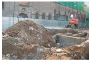
53) Treball mecànic espais entorn soterrani.JPG
