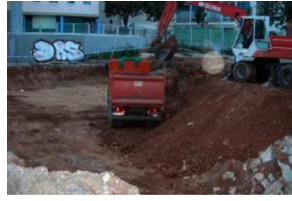
4) Rebaix mecànic Sector 3.JPG
