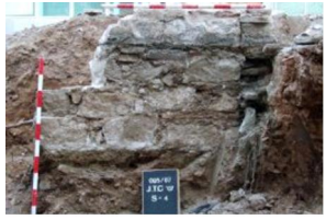
45) Zona A Mur 4073.JPG
