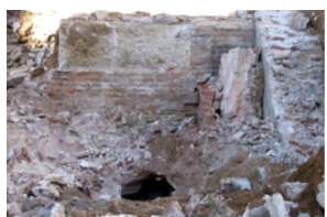
31) Zona B Afectació.JPG
