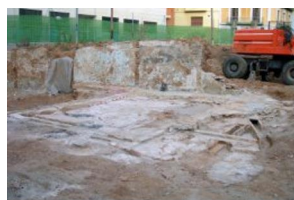
3) Vista general àmbit Sud.JPG
