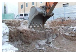
52) Zona A Afectació dipòsit 4023.JPG
