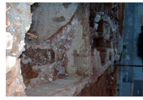
60) Vista àmbit soterrani.JPG
