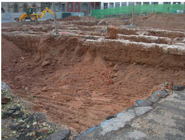
Vista general del Sector 3 un cop efectuada la intervenció
