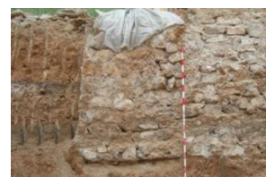
10) Detall mur u.e. 1049 en alçat.JPG
