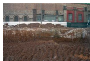
19) Desmuntatge mur u.e. 1049.JPG
