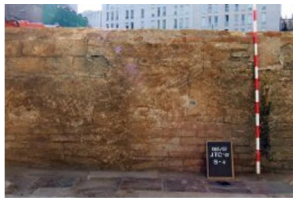
48) Zona B Alçat Mur Oest Soterrani.JPG
