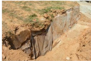
7) Vista mur u.e. 1002 .JPG
