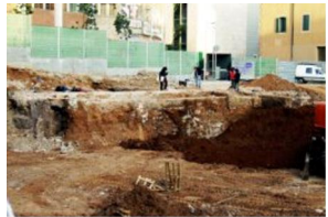
1) Zona B Vista GENERAL.JPG
