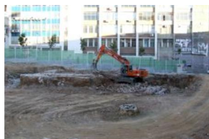
22) Zona B Afectació.JPG
