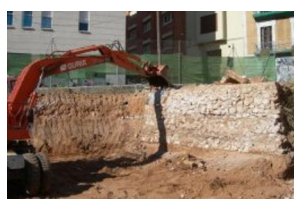
18) Desmuntatge mur u.e. 1049.JPG
