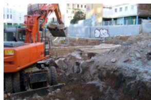
23) Zona B Afectació.JPG
