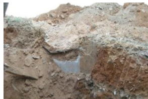
13) Detall mur u.e. 1002.JPG
