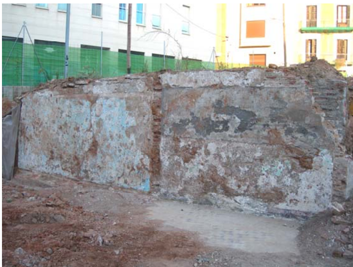
Vista general del mur u.e. 1002 amb les restes dels envans divisoris
