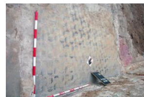
50) Paviment u.e. 1018.JPG
