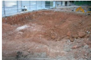
Primeres estructures Zona A.J
