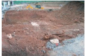
Primeres estructures Zona A.J
