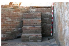
14) Zona B Escalles soterrani.JPG
