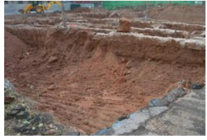
4) Rebaix mecànic Sector 3.JPG
