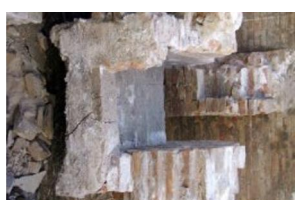
61) Zona A Detall paret dipòsit 4069.JPG
