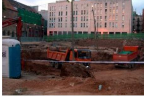
7) Final rebaix Sector 3.JPG
