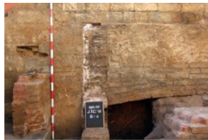
46) Zona B Alçat Mur Oest Soterrani.JPG
