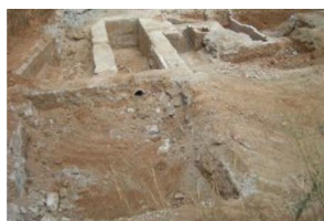
27) Vista dipòsits 1, 2 i 3.JPG
