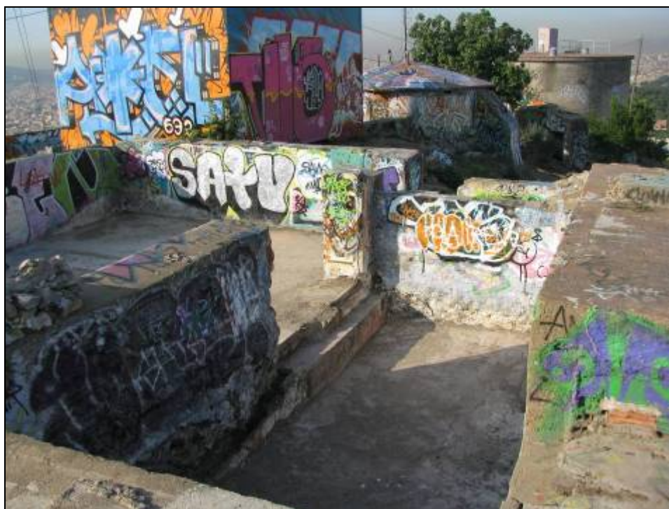
Foto 33: Vista general de lloc de comandament un cop finalitzat la seva neteja.
