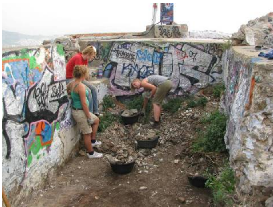
Foto 31: Treballs de neteja del lloc de comandament.
