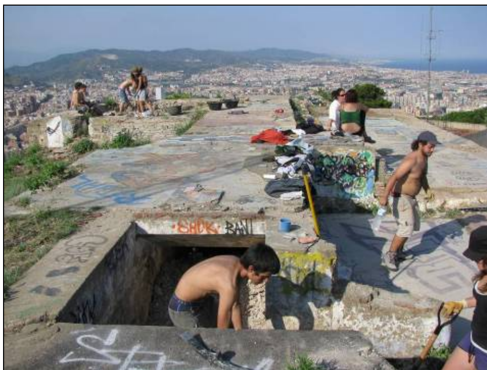
Foto 25: Vista general del projecte de bateria antiaèria de 1937 amb els voluntaris.
