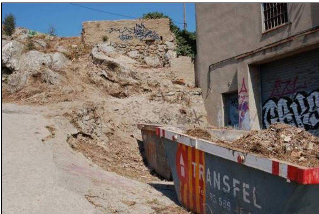
Foto 6: Ubicació dels containers, al carrer Marià Labèrnia.
