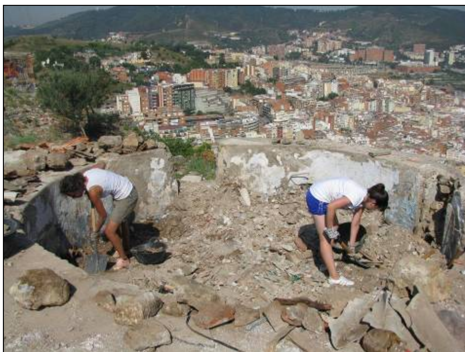
Foto 22: Voluntàries durant els treballs de recuperació de la plataforma de tir de la bateria antiaèria.
