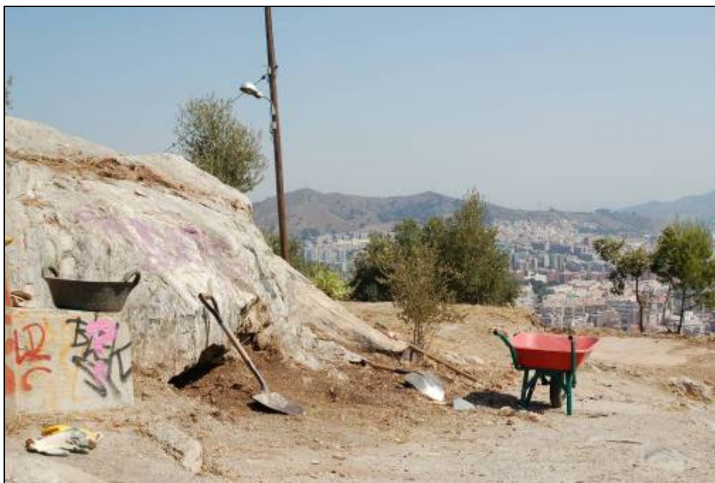
Foto 2: Vista del moment de la neteja de l'accés a la bateria antiaèria.
