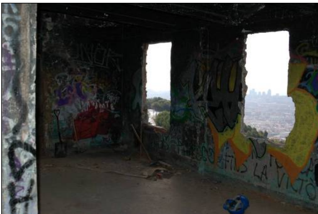
Foto 13: Vista del pavelló de dormitoris durant els treballs de retirada de la runa existent.
