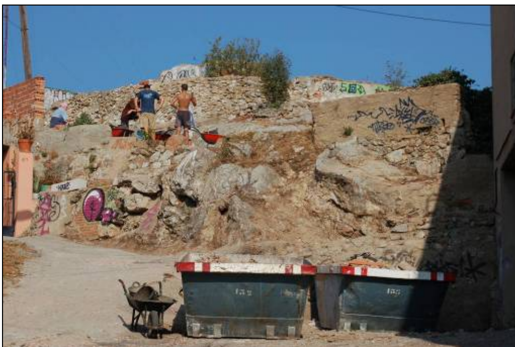
Foto 7: Vista general del transport de la runa.
