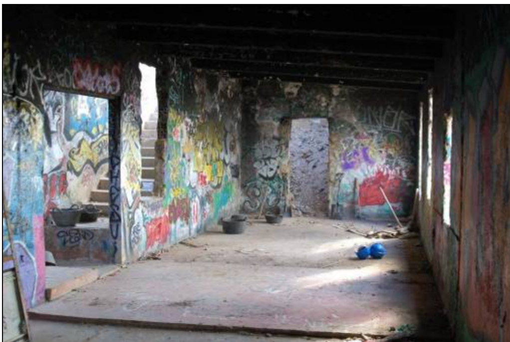
Foto 14: Habitable dins del pavelló de dormitoris en el moment de la retirada de la runa.
