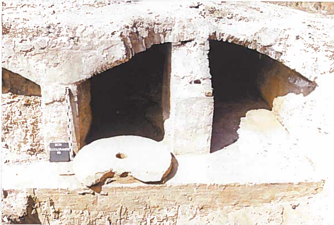
Foto 3. Arcada d'un dels desaigues del pont de la fàbrica, sobreposada a l'estructura dels carcabans d'un antic molí.
