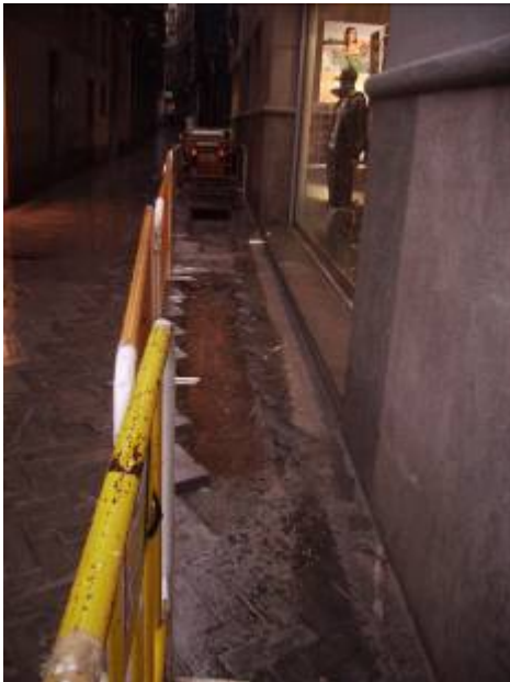
Foto 1. Obertura de la rasa carrer Bertrellans
