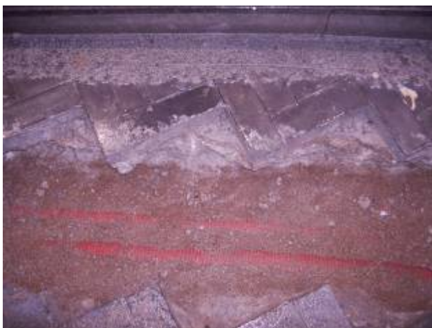
Foto 2. Obertura d'un tram de la rasa del carrer de la Canuda
