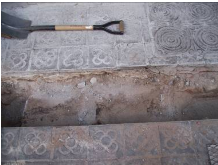
Foto 2. Tram de la rasa en procés de ser rebaixat
