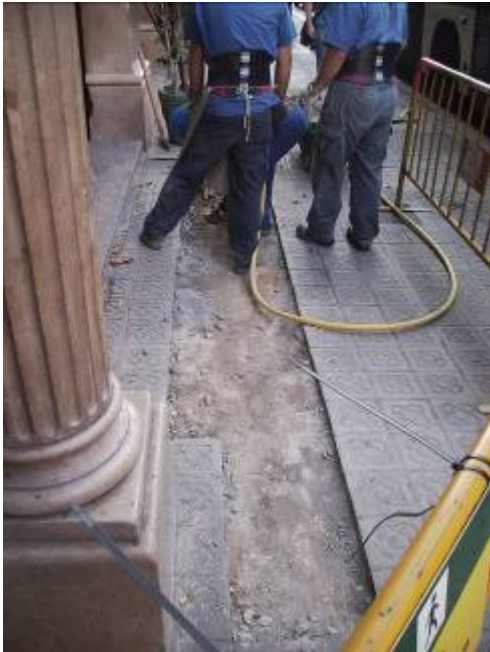
Foto 1. Obrers començant a rebaixar un tram de la rasa
