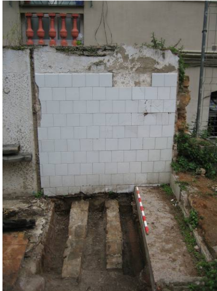
FOTO 17. Vista dels envans UE 63 i UE 64 que sustentaven el paviment (UE 61) del lavabo de les escoles. Interior del sondeig 4.
