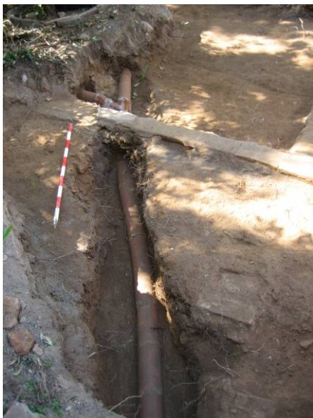
FOTO 3. Vista de les canalitzacions UE 13 i UE 16 a l'interior del sondeig 1.
