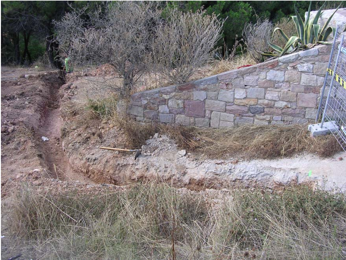
Detall de la conducció aigües castell, baluard nord avinguda castell-passeig de migdia
