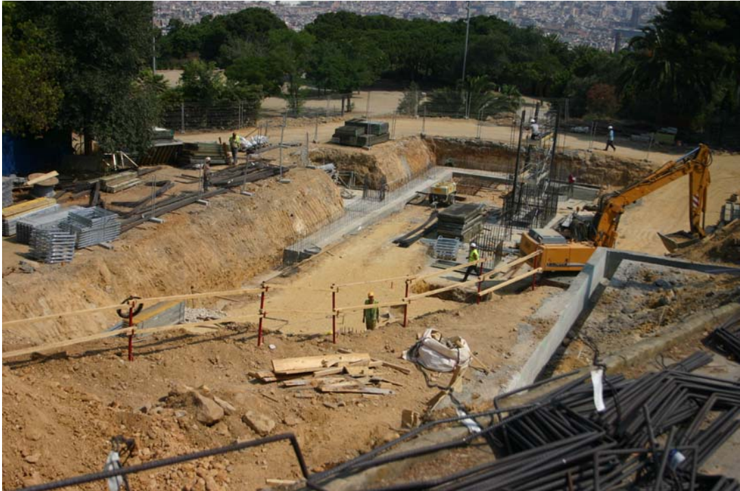
Vista de l'àrea afectada pels treballs de l'estació de la carretera de Montjuïc.
