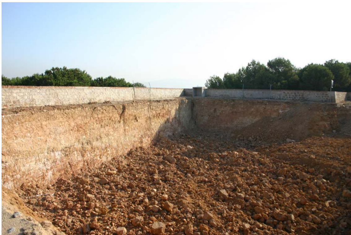
Murs exteriors del baluard. U.E. 1002 i 1004
