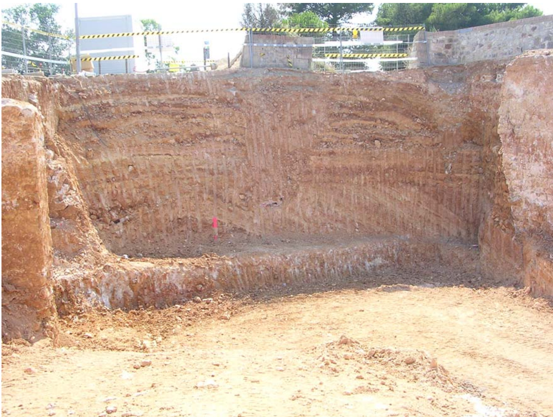
Detall de l'estratigrafia del subsòl del baluard (costat oest). S'aprecien els estrats de rebliment antròpic (part superior) i el substrat geològic (part inferior) així com una rasa de serveis contemporània a la part central.
