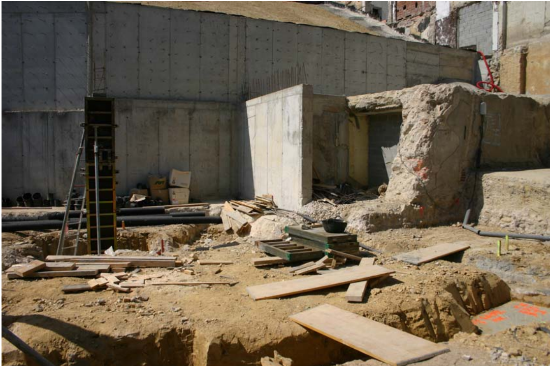
Vista de la zona de treball corresponent a l'estació inferior (Avinguda de Miramar)
