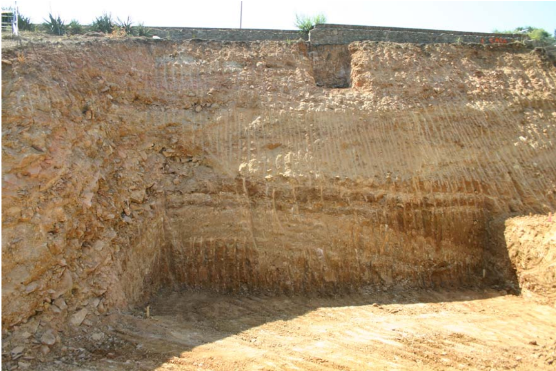
Vista general de la zona afectada un cop finalitzats els moviments de terres.
