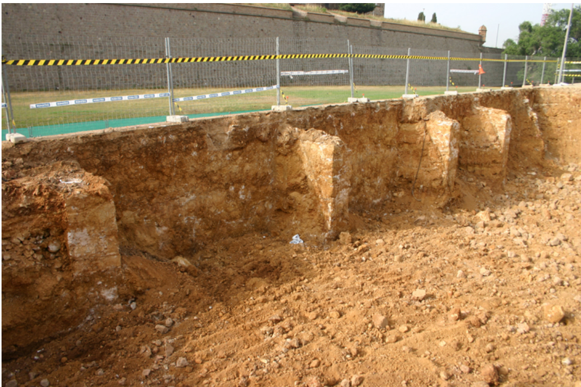
Vista dels contraforts del mur 1003.
