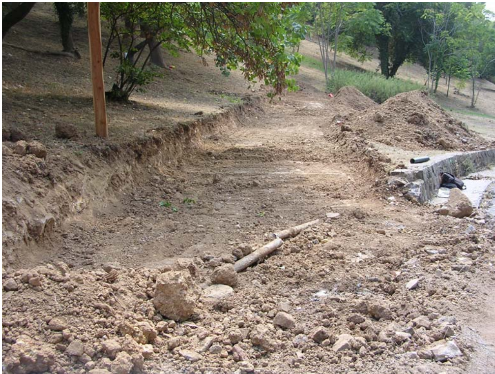
Imatge de la conducció aigües del castell, al baluard nord avinguda castell-passeig de migdia
