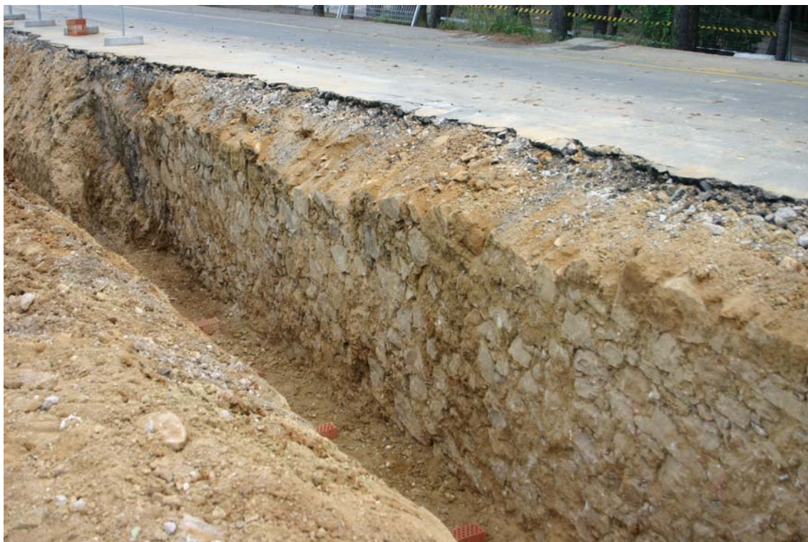
Vista del mur localitzat a la rasa de la carretera de Montjuïc
