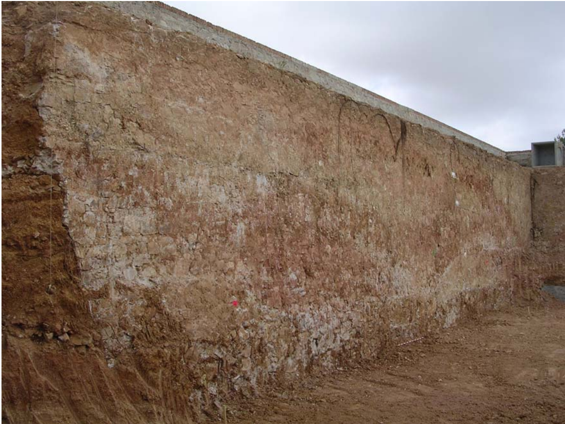
Vista del parament intern del mur 1002, un cop assolida la fondària requerida pel projecte del dipòsit.
