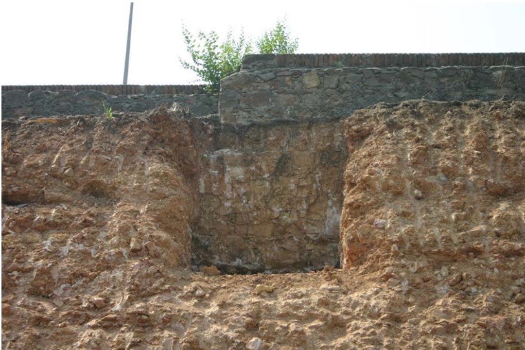
Detall del parament extern de la muralla del castell de Montjuïc, localitzat en el decurs dels moviments de terres.
