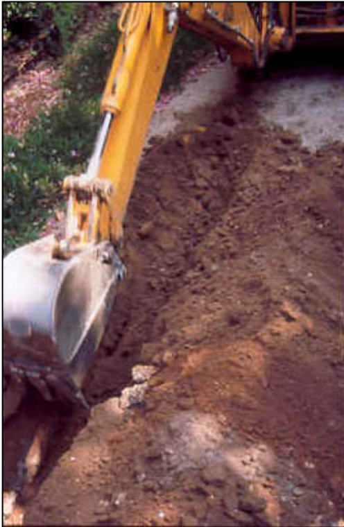
FOTO 1: Treballs mecànics d'excavació de la RASA 100.
