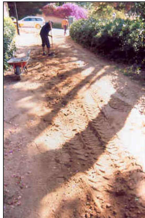
FOTO 6: Imatge dels treballs de rebliment de la RASA 100 finalitzada la col·locació dels nous serveis.
