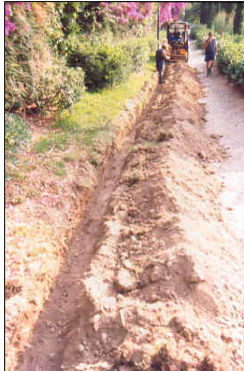
FOTO 2: Vista general de la RASA 100 durant els treballs d'excavació.
