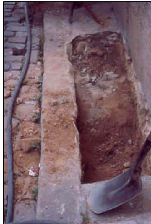
FOTO 4: Vista parcial de la RASA 200 durant la seva excavació.
