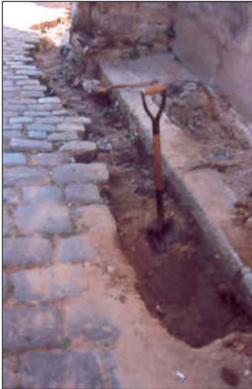
FOTO 5: Excavació de la rasa en el carrer de la Baixada del Monestir.
