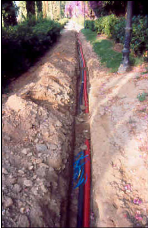
FOTO 3: Vista general de la RASA 100 durant la col·locació dels nous serveis.
