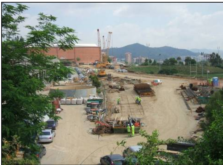
Fotografia 1: Vista general de la zona de treball del Dipòsit de trens de Sant Genís
