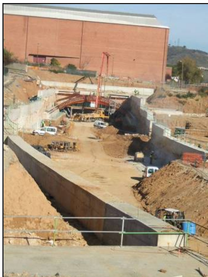
Fotografia 8: Vista general de l'àrea del Dipòsit amb les pantalles
