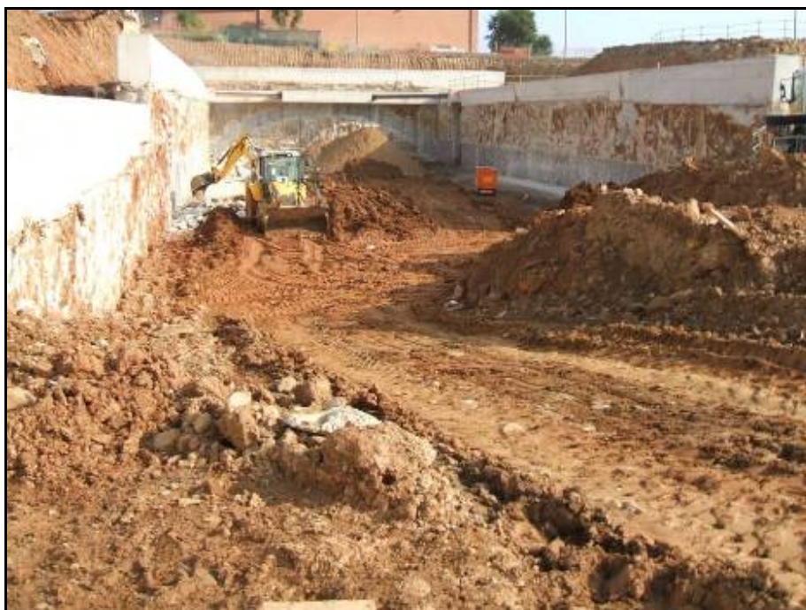
Fotografia 7: Buidament de terres a l'interior de les pantalles
