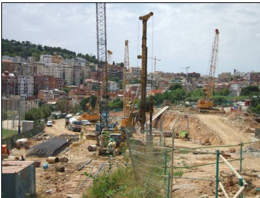
Fotografia 6: Construcció de les pantalles de formigó a l'extrem sud del Dipòsit de Sant Genís
