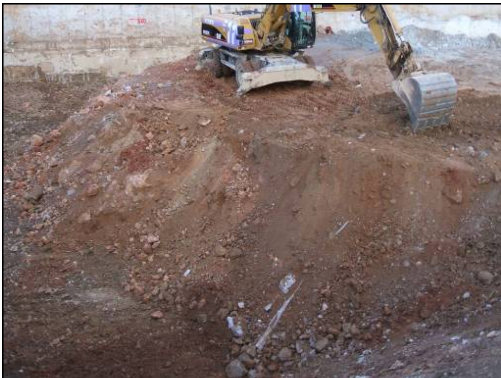
Fotografia 9: Rebaix de terres amb giratòria a la zona de la Nova Estació de Vall d'Hebron
