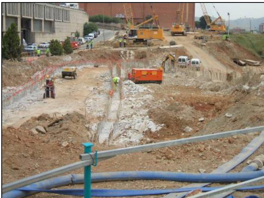
Fotografia 4: Construcció de carrils de sortida d'emergències
