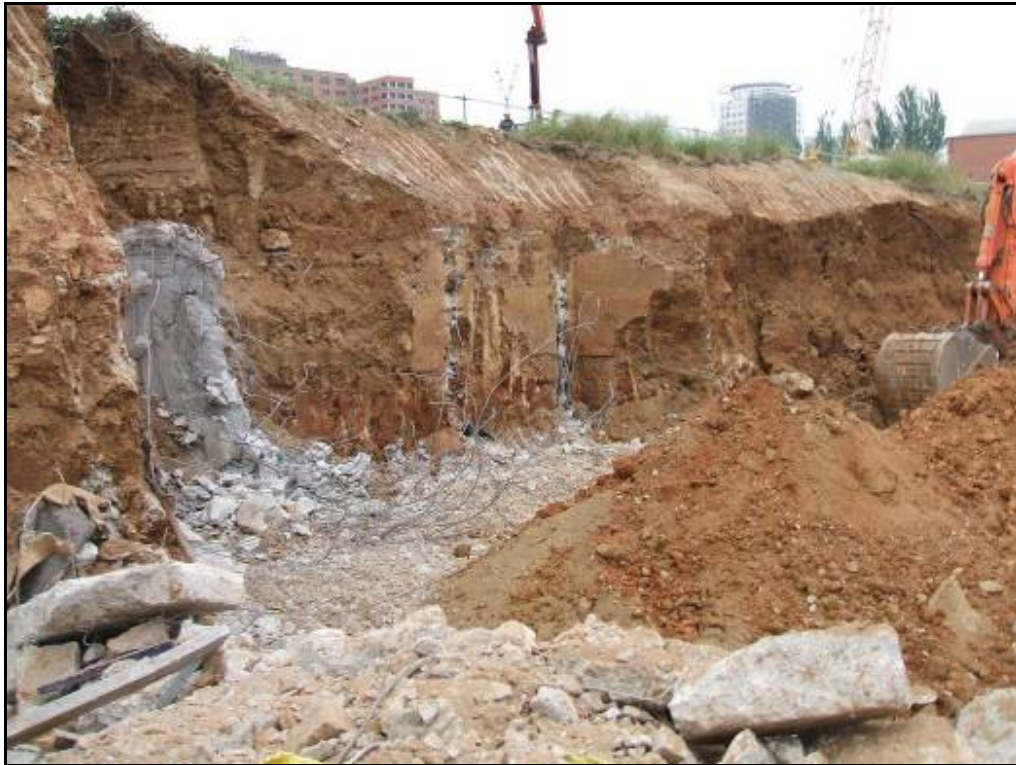
Fotografia 3: Eliminació de restes constructives dels Jocs Olímpics del '92
