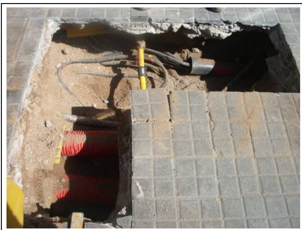
Fotografia 3. Rasa 1000. Detall dels serveis instal·lats anteriorment.
