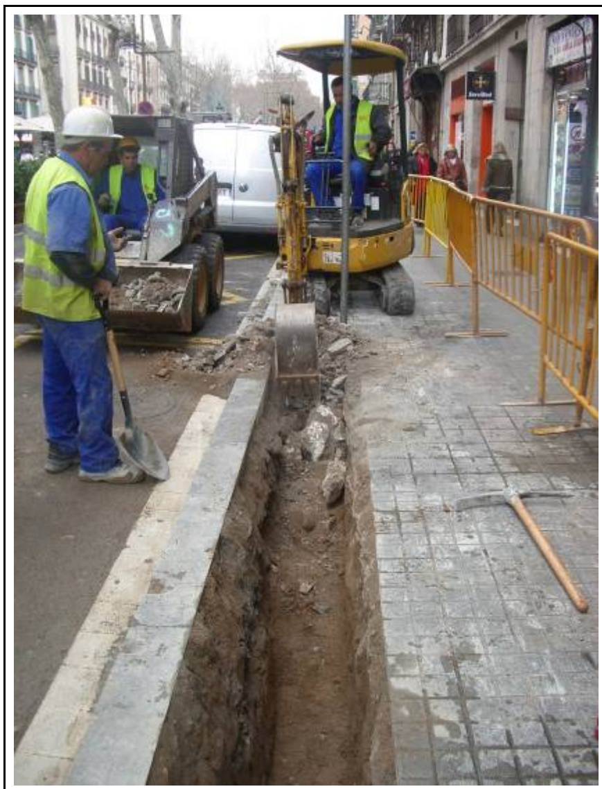
Fotografia 5. Rasa 2000. Procés d'excavació.
