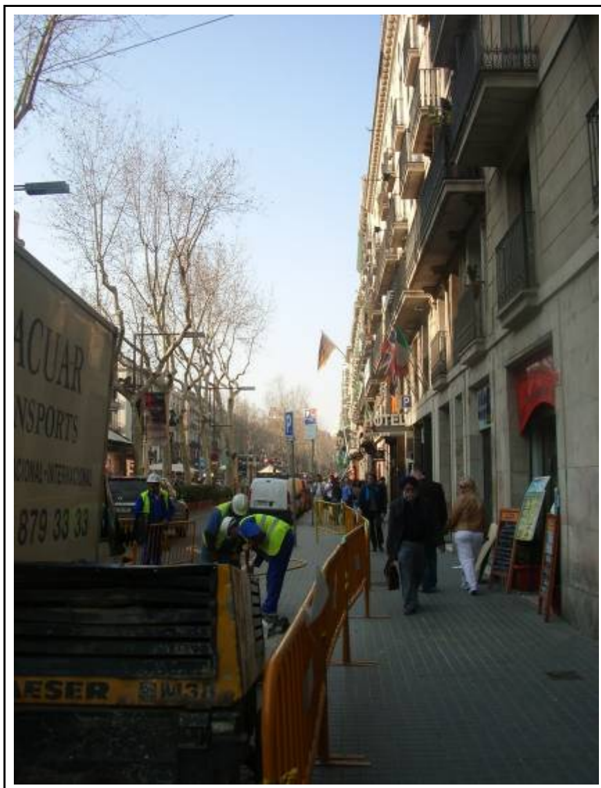
Fotografia 1. Vista del tram de La Rambla on s'efectuaren les rases.
