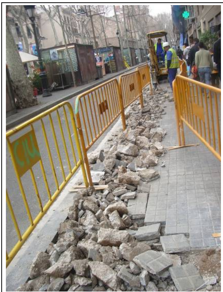
Fotografia 4. Rasa 2000. Procés d'excavació.
