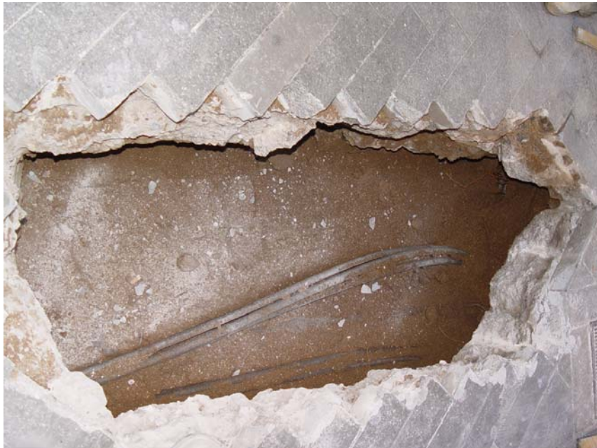
Detall de la U.E. 03. Vegeu la sorra fina per protegir el conducte del gas
