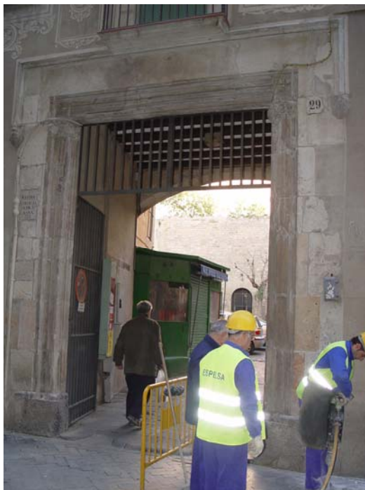
Finalitzant els treballs d'excavació davant el núm. 29
