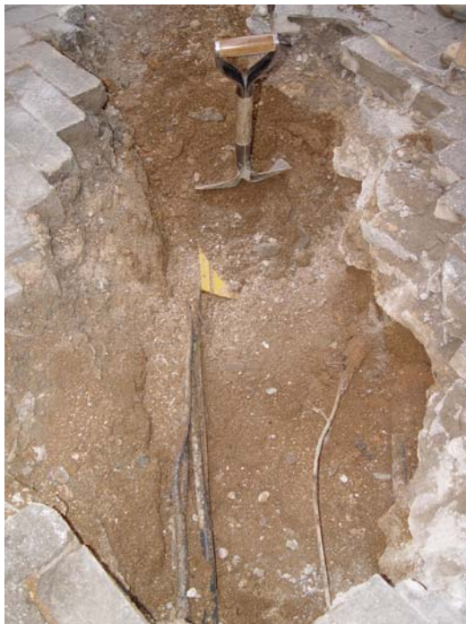
Excavant la U.E.03. el plàstic groc identifica el conducte del gas. A dalt el panot ( U.E.01) i la preparació.U.E.02
