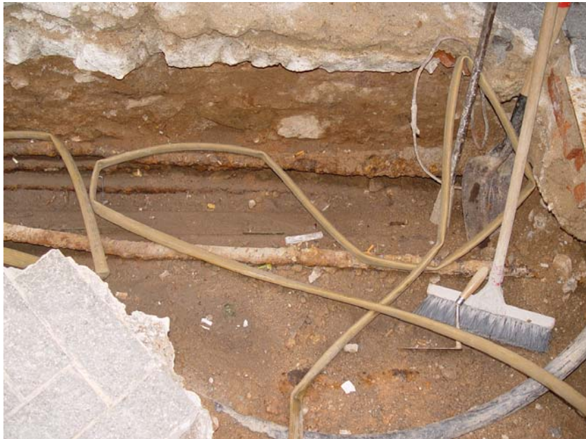
Estesa de cables de serveis anul·lats al mateix lloc que s'excavà la rasa davant el núm.29
