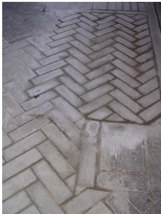
El primer tram de rasa una vegada col·locat el tub i tapat amb panot.
