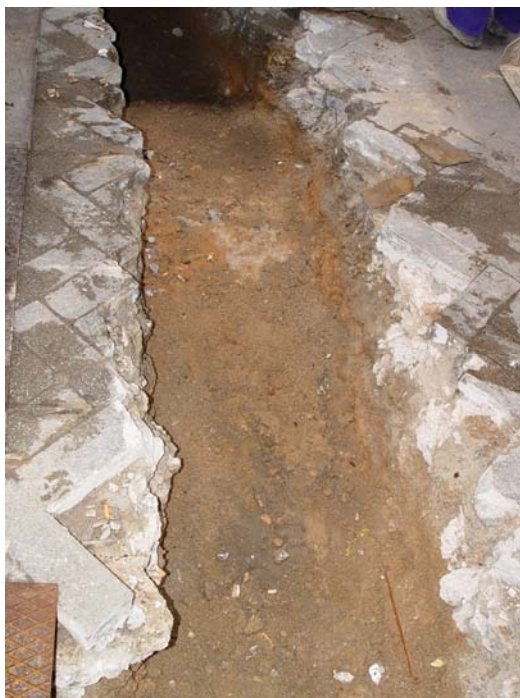
La segona part de la rasa una vegada excavada, netejada i a punt de passar el cablejat elèctric. L'estrat que s'hi observa correspon amb la U.E.03
