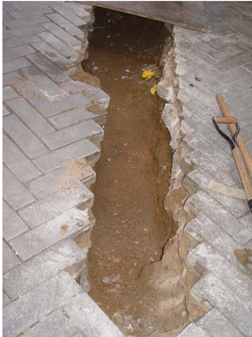
La segona fase dels treballs. Obertura de la rasa davant el núm.27.
