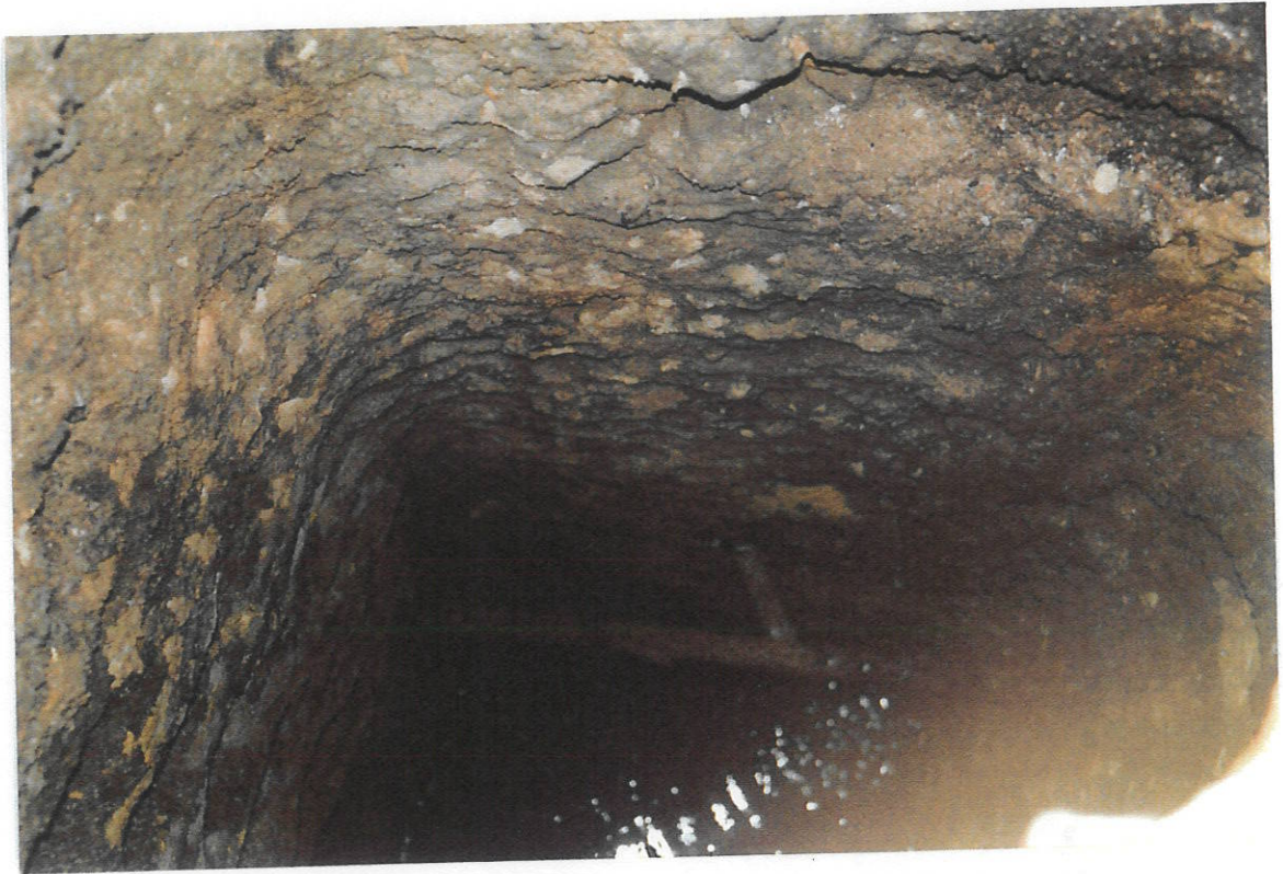
10. Habitació H-2, vista de l'interior del pou on s'observen unes bigues que van de banda a banda.
