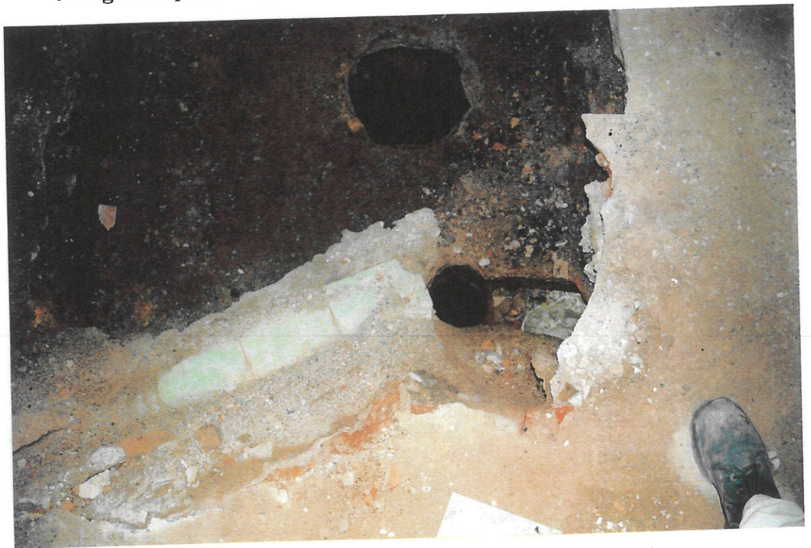
9. Habitació H-2, detall de les clavegueres que desguassen al pou.
