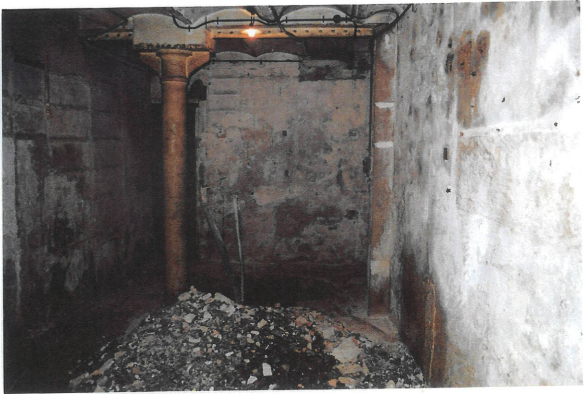
6. Habitació H-2, vista des de la paret sud.
