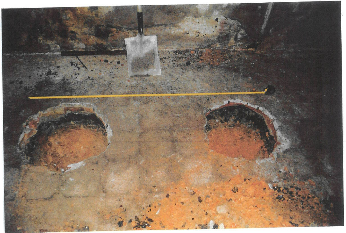
4. Habitació H-1, sondeigs practicats al futur emplaçament de la sabata de fonamentació per la nova escala.
