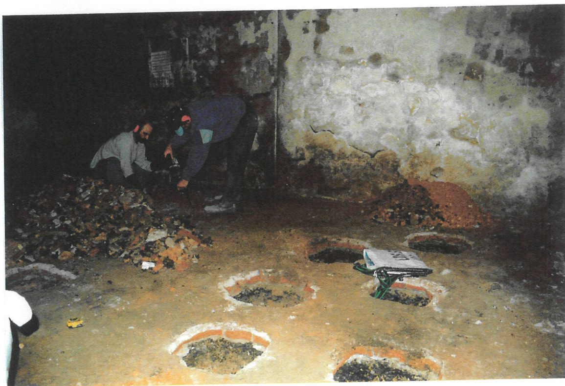
2. Habitació H-1 vista des de la paret nord. Sondeigs i desenvolupament dels treballs.
