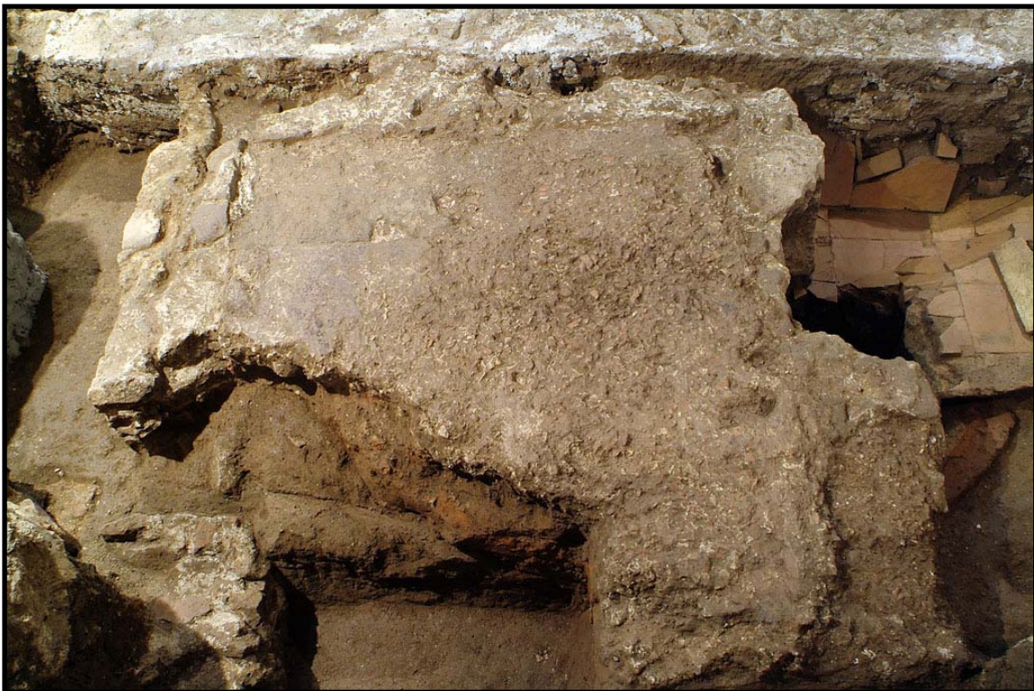
Fot.38. Detall del paviment d'opus signinum conservat sobre les estructures alt-imperials (UE 441) (imatge cedida per Pere Vivas)
