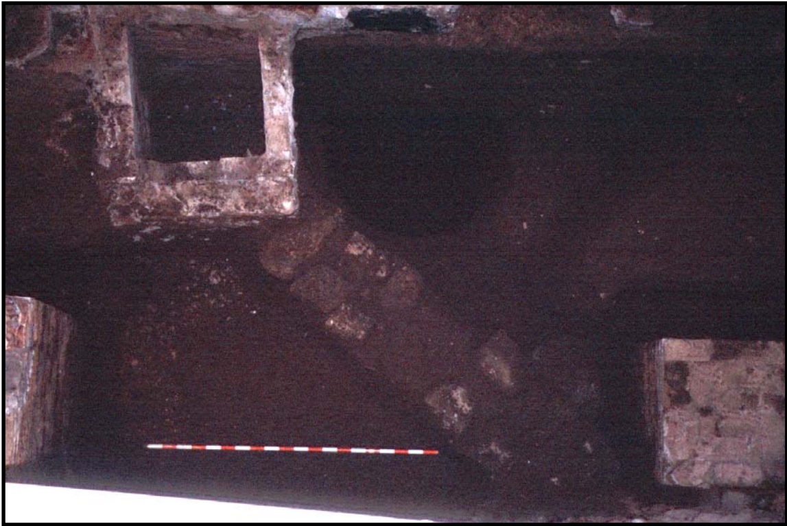
Fot.35. Situació del mur 322.
