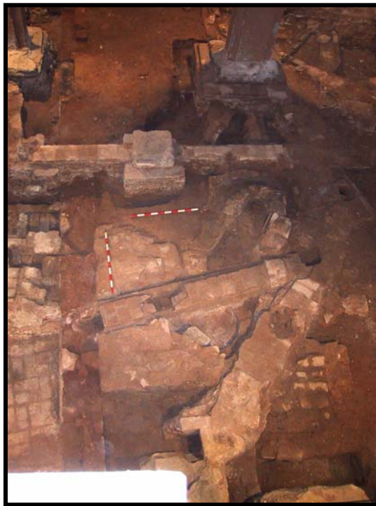
Fot.5.Vista de les fonamentacions i el sistema de clavegueram de l'edifici del XIX i de les estructures del XVII.
