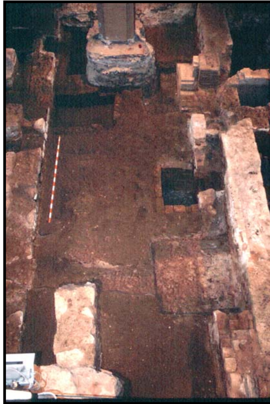
Fot.7. Vista de la segona crugia un cop desmuntat el paviment 80. Apareixen els diversos dipòsits moderns
