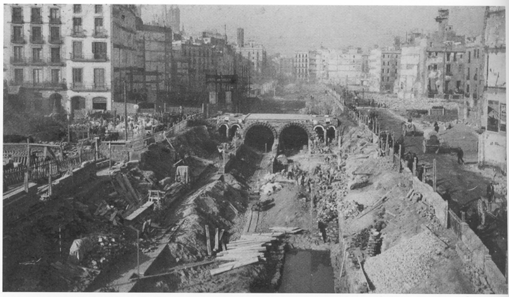
Tunels del futur metro, Via Laietana. (Museu d'Història de la Ciutat)
