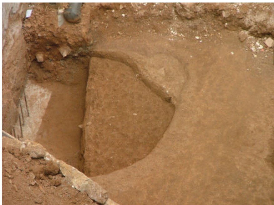
21. Vista aèria del retall 2005 amb el seu rebliment 2006, i la rasa de les pantalles de fonamentació del futur edifici.
