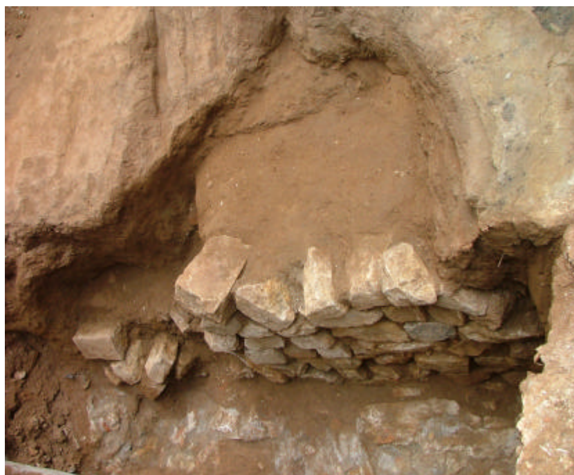
20. Vista general del mur de contenció 1019 i dels retalls 2009 i 2021.
