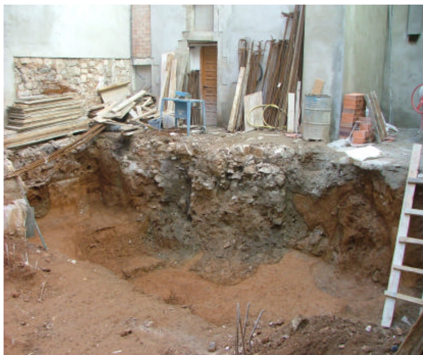
19. Vista general del tall oest del solar, on s'observa la destrucció parcial de les estructures 2018,2011 i la sitja 2007, per un rebaix incontrolat.
