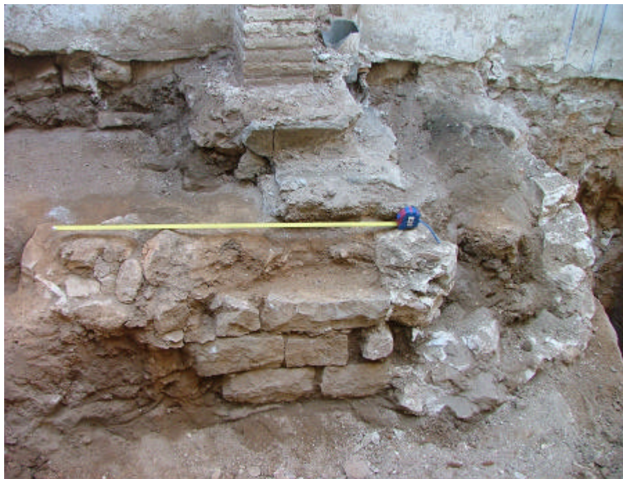
3. Fotografia general del pou 1005 i la fossa sèptica 1006 abans d'excavar.
