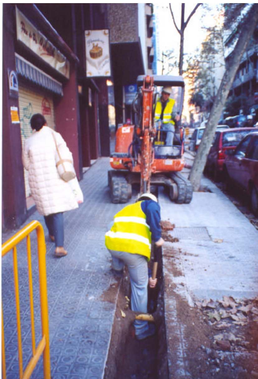
Foto 1.- Vista longitudinal parcial de la RASA 1 amb la retroexcavadora giratòria en segon plànol. La cantonada amb carrer Galileu al fons.
