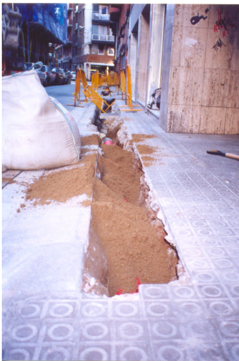
Foto 5.- Vista longitudinal general de la RASA 2 amb els tubs elèctrics instal·lats. La cantonada amb carrer Galileu al fons.
