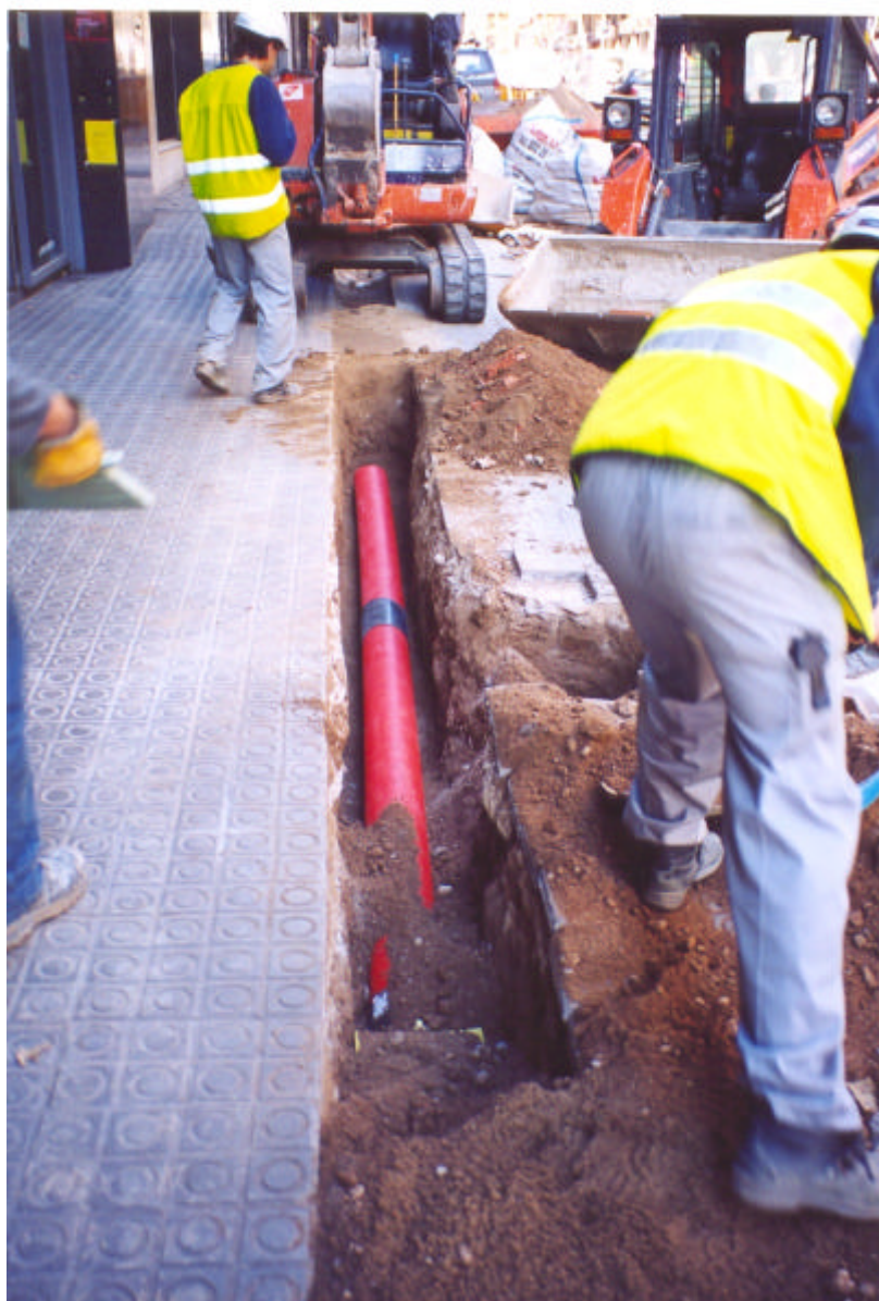
Foto 2.- Vista longitudinal parcial de la RASA 1 amb un dels tubs elèctrics ja col·locats al interior. La cantonada amb el carrer Galileu al fons.
