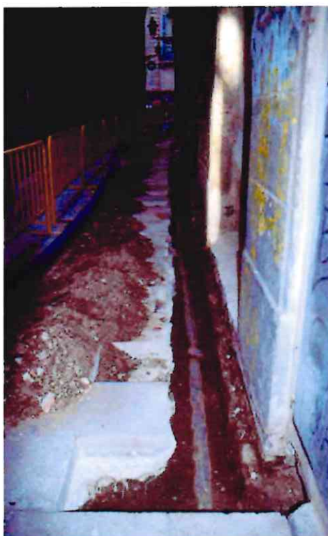
Foto 1: primer tram de la rasa 1
