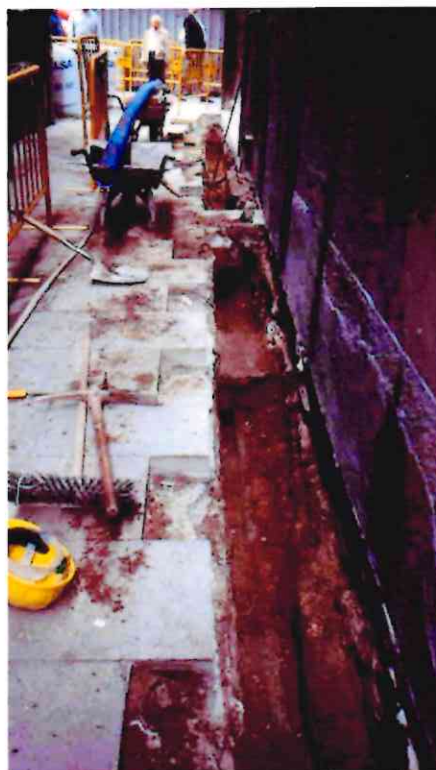
Foto 2: segon tram de la rasa 1
