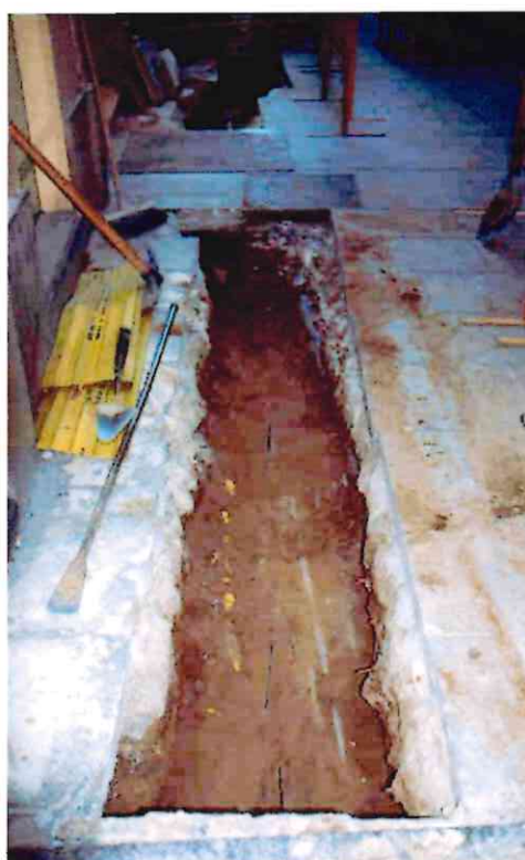
Foto 11: segon tram de la rasa 9
