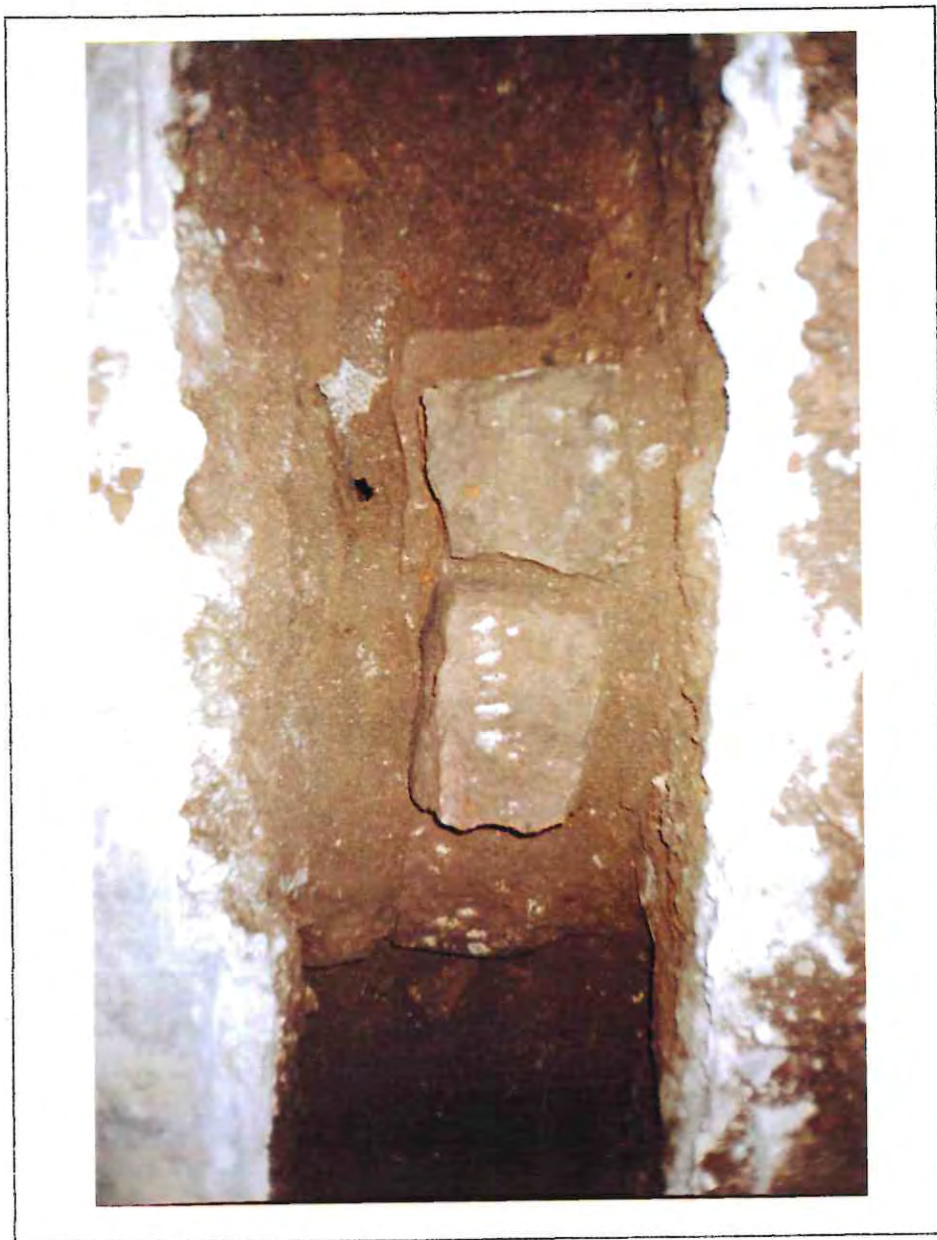
Fotografia nº 3: C/ Portal Nou. Rasa 3000, UE 3003.
