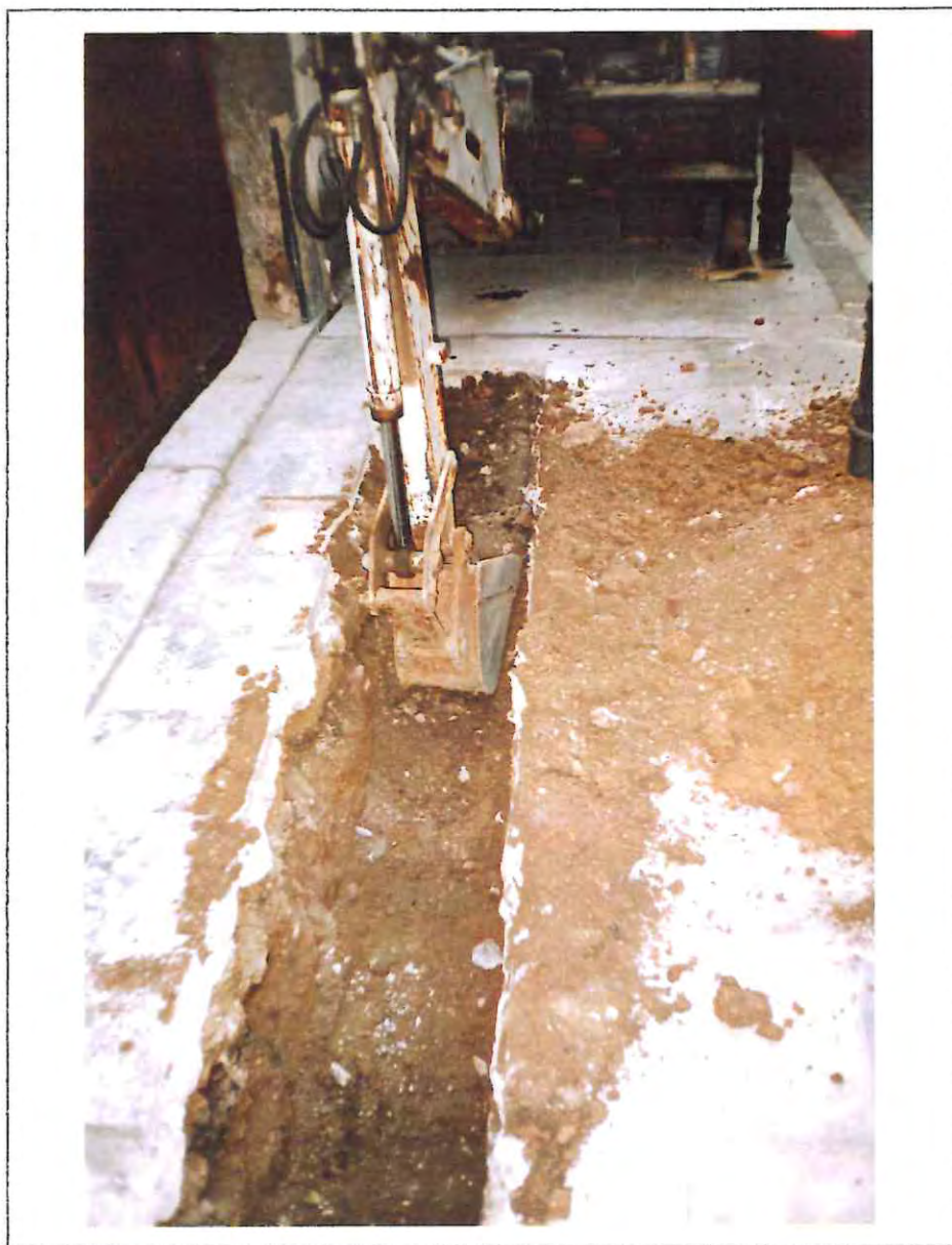
Fotografia nº 2: C/ Portal Nou, procés de rebaix. Rasa 2000.
