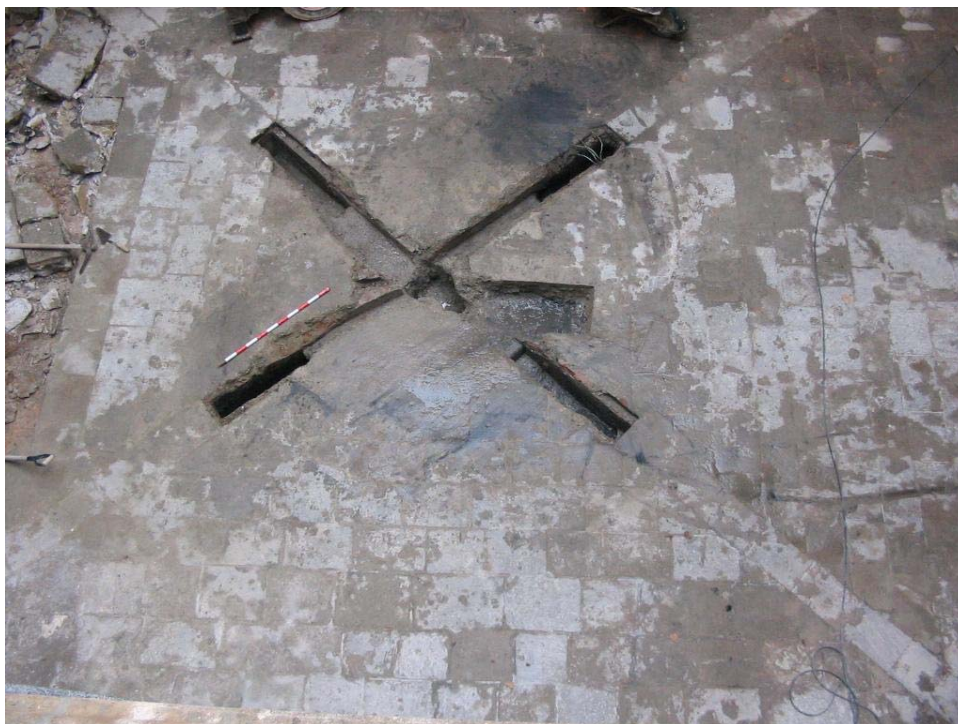
Foto 3. Sistema de desguàs del pati. UE: 112, 113, 114 i 115.
