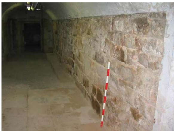
Foto 7. Vista del soterrani.
