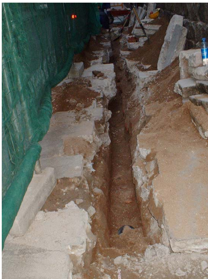
Fotografia 7: Tram de la Rasa 200.
