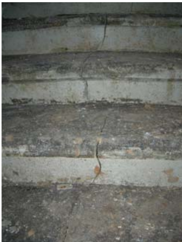
FOTO 89: Entrada-accés 5, graons esquerdat
