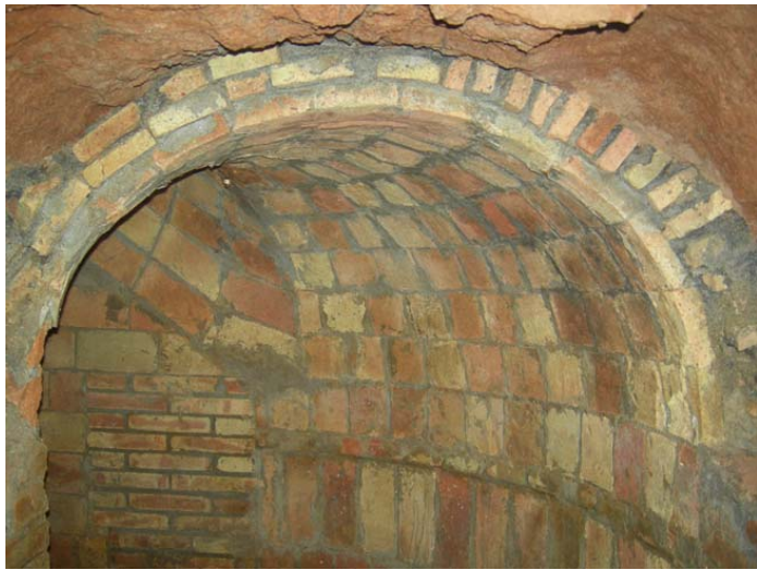
FOTO 99: Entrada 5 exemple de volta catalana
