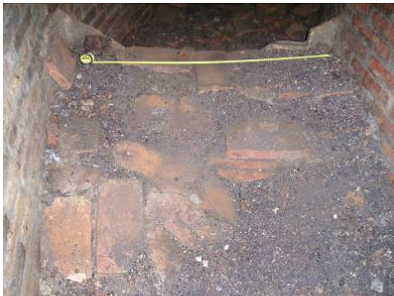
FOTO 12: Tram 1, estructura, vista des de NE
