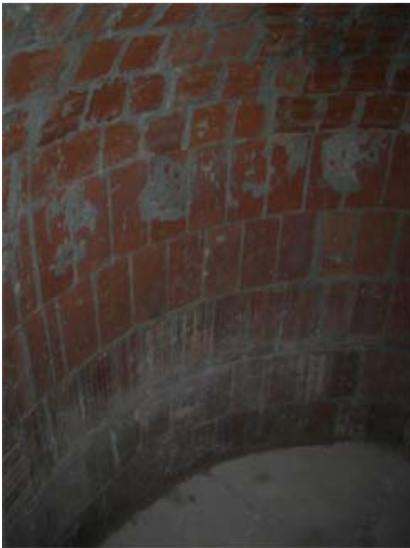
FOTO 131: Entrada-accés 3, maons verticals
