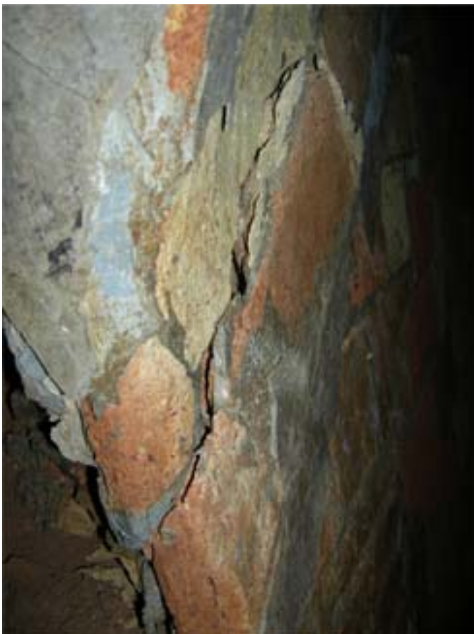
FOTO 101: Entrada 5, esclatxes volta
