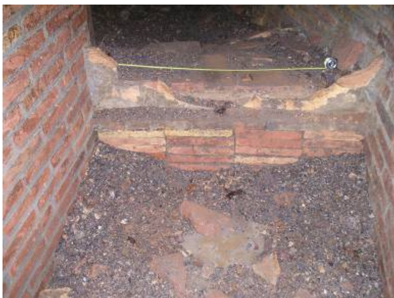
FOTO 13 : Tram 1, estructura, cara SO
