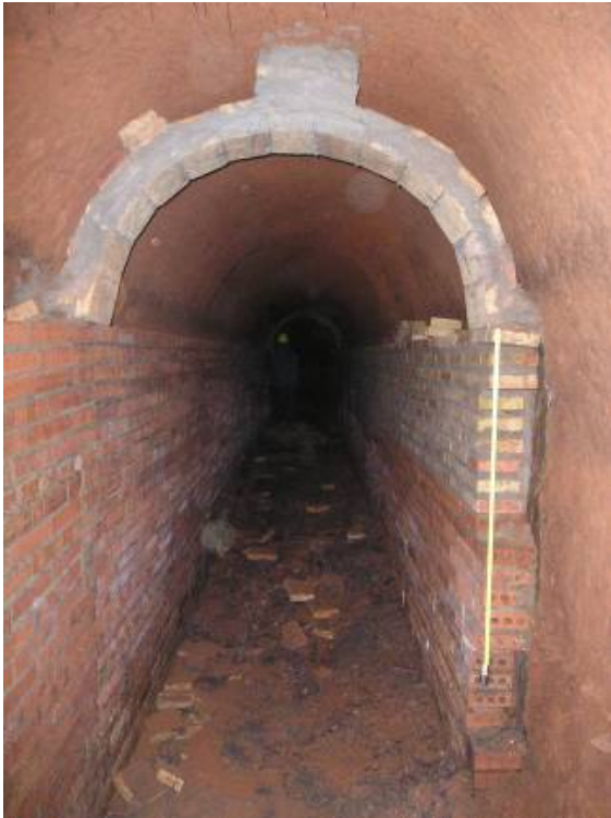
FOTO 135: Tram 3 , paret i sostre a mig construir
