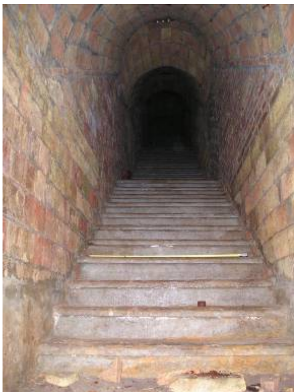
FOTO 18: Final tram 7, escales accés 2
