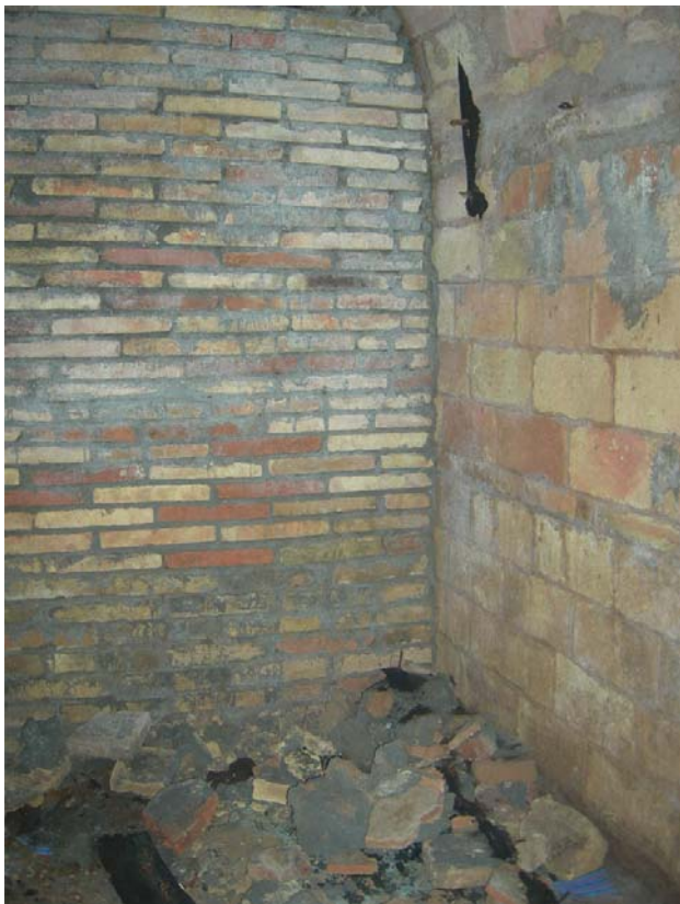
FOTO 49: Entrada accés 3. Interior segona tapia
