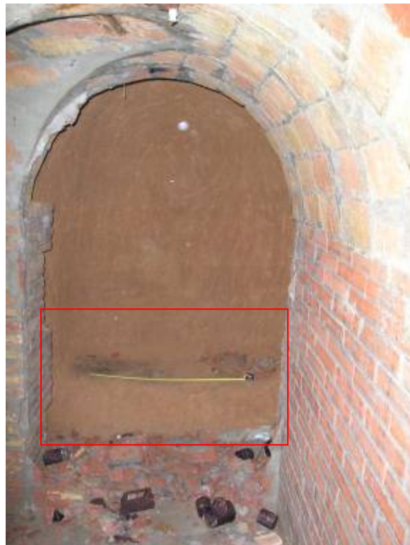
FOTO 30: Accés escala 2, banc d'argila
