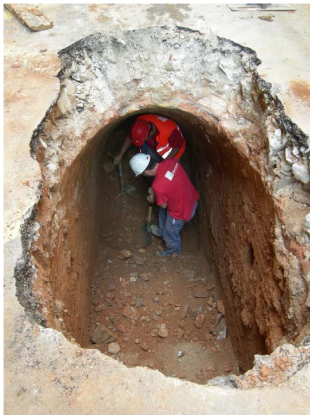
FOTO 37: Entrada accés 3. Desenrunament manual
