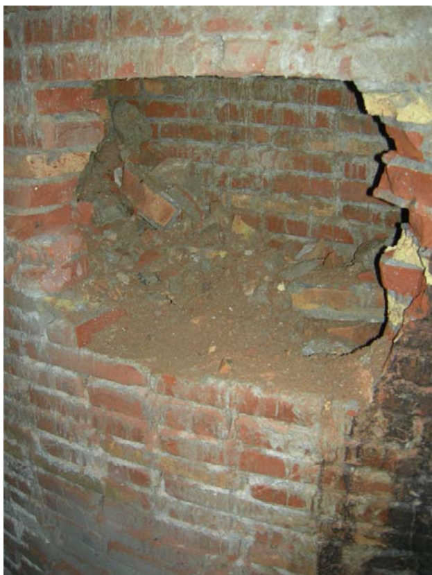
FOTO 27: Entrada 2: Detall reompliment tapia
