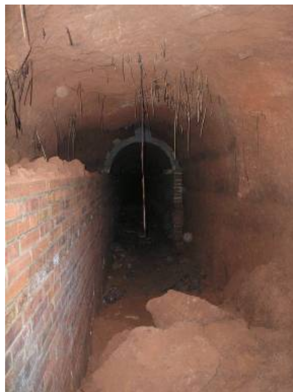
FOTO 14: Tram 3, vista des de NE)
