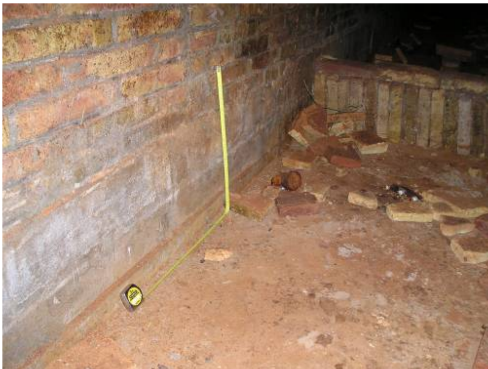
FOTO 32: Tram 7. Encofrat perdut
