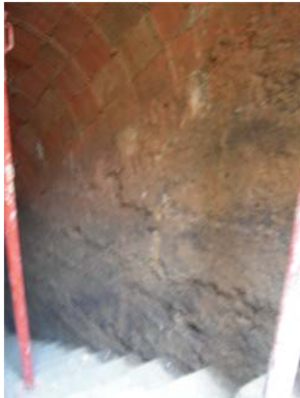
FOTO 132: Entrada-accés 5, encofrat perdut
