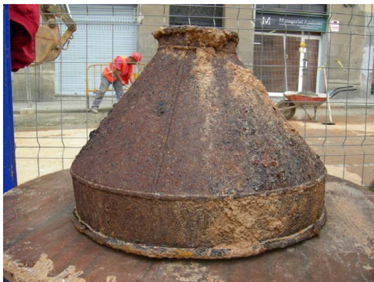
FOTO 58: Tram 8. Campana extractora
