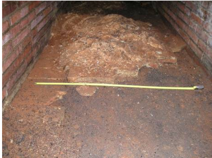
FOTO 128: Tram 5, material constructiu in situ. Morter
