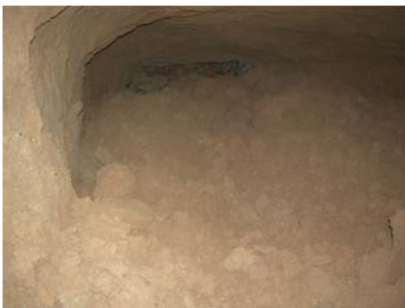
FOTO 94: Tram 9, base col·lector
