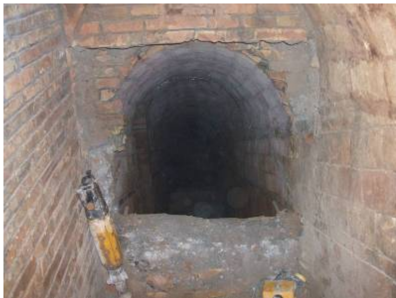
FOTO 40: Entrada accés 3. Mur tapia
