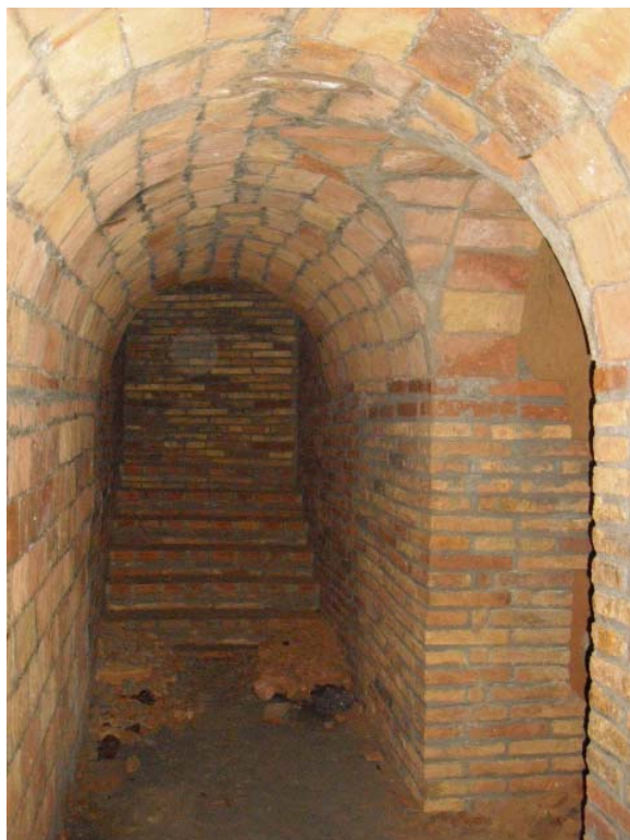
FOTO 76: Tram 4. Galeria i Tapia
