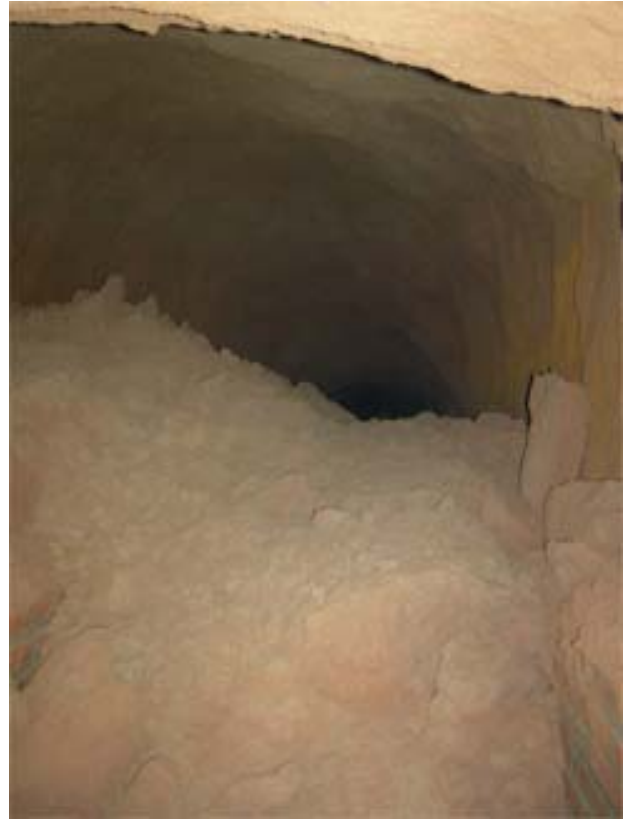
FOTO 104: Entrada 5, ensorrament volta
