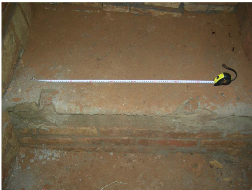
FOTO 45: Entrada accés 3. Encaixos graó
