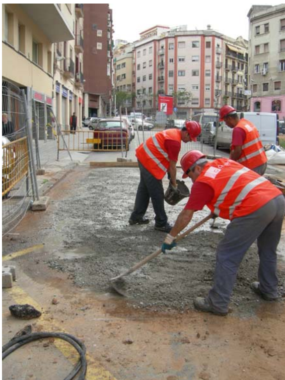
FOTO 75: Entrada-accés 4. Capa formigó
