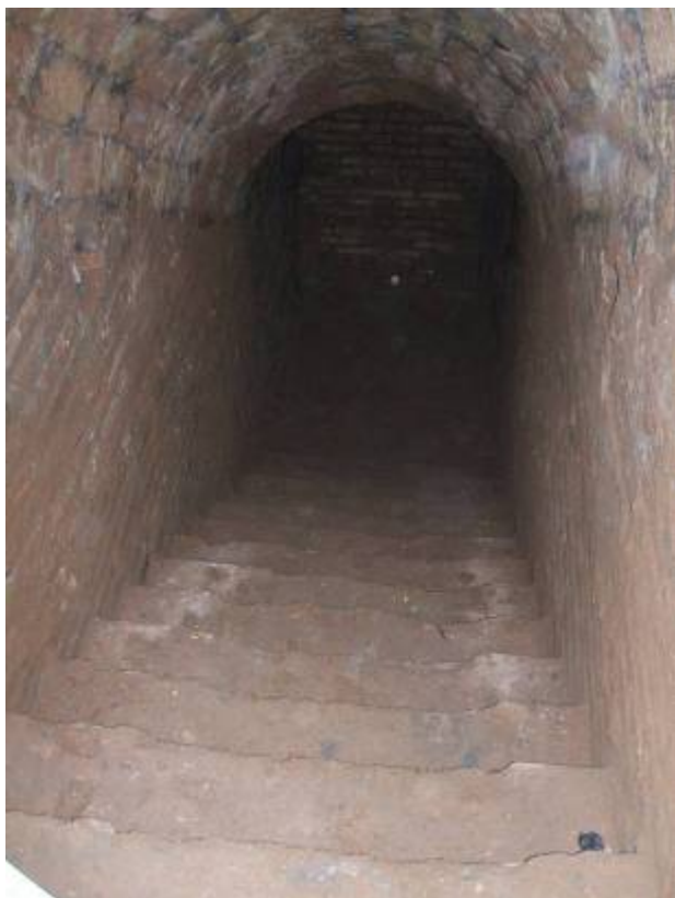
FOTO 39: Entrada accés 3. Tram escales.
