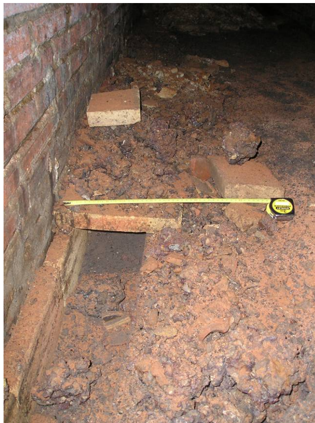
FOTO 140: Tram 5, canal desaigna
