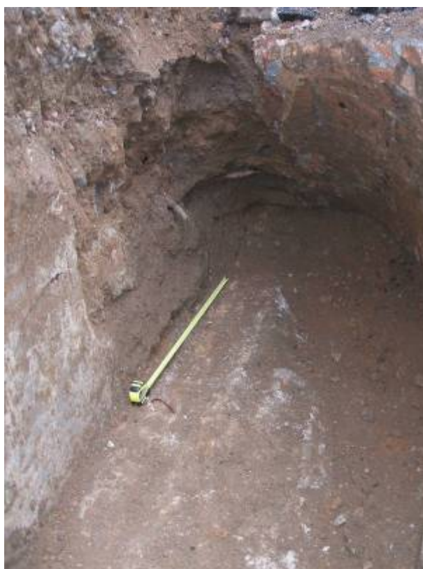
FOTO 74: Entrada-accés 4. Fomigó col.lector
