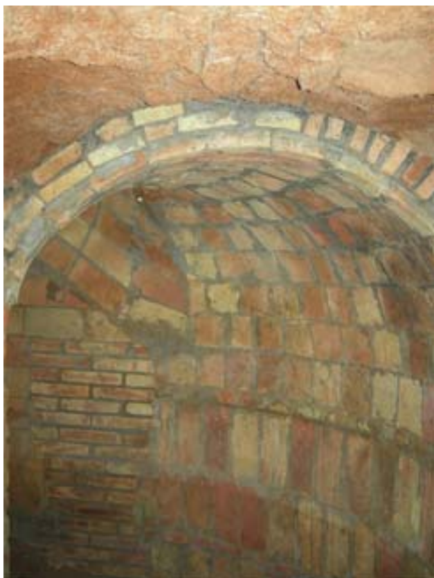
FOTO 91: Entrada-accés 5, final tram volta
