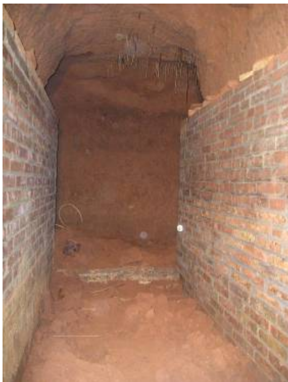
FOTO 11 : Tram 1, vista des de NE
