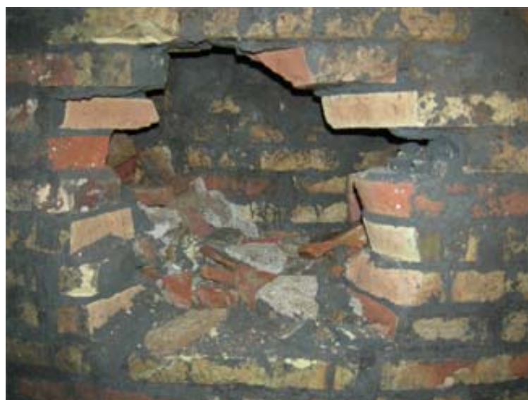
FOTO 86: Entrada-accés 5, detall tapia
