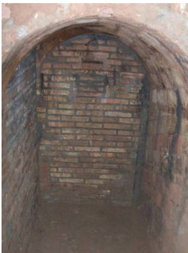
FOTO 41: Entrada accés 3. Tapia dreta i esquerra.
