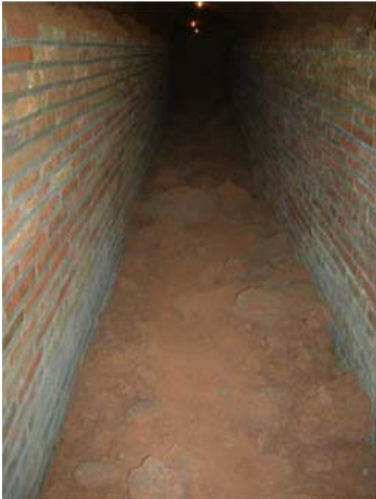
FOTO 113: Tram 9, paviment en ús
