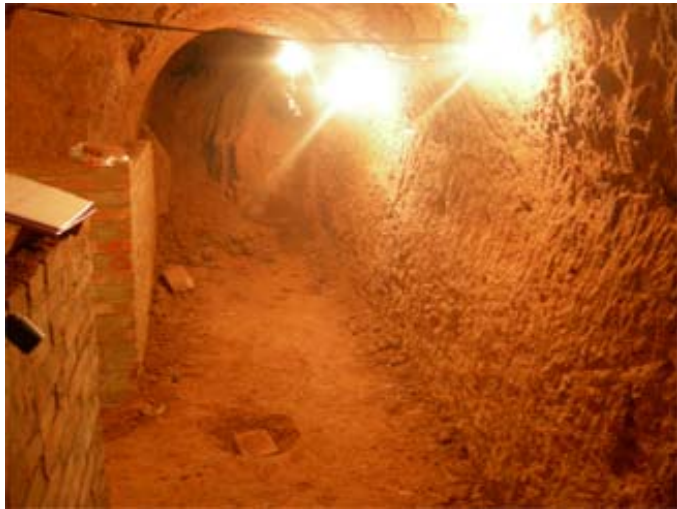
FOTO 107: Tram2/ Pou 1, galeria inacabada
