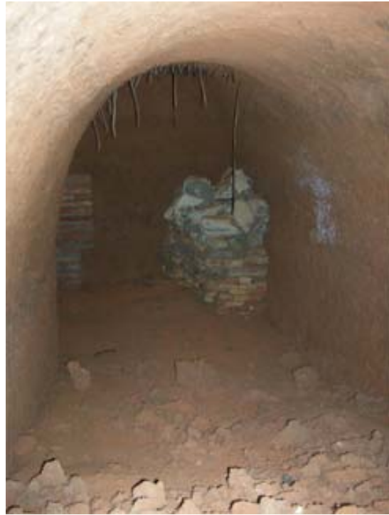
FOTO 116: Tram 9, sacs de ciment i maons
