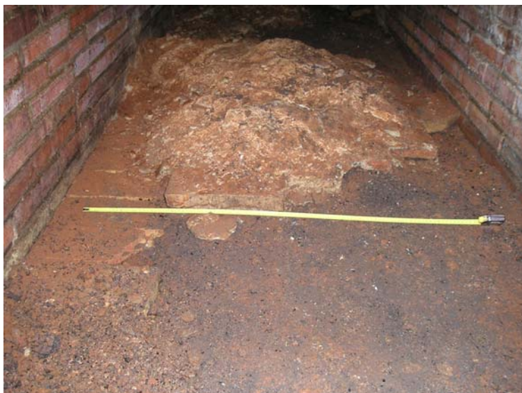
FOTO 143: Tram 5, paviment d'us amb morter
