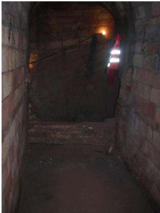
FOTO 50: Entrada accés 3. Segona tapia desmuntada
