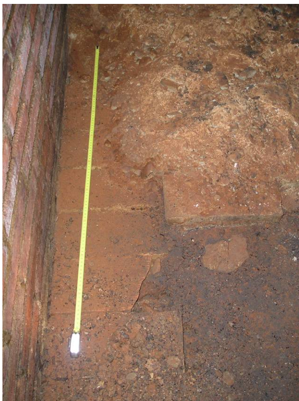
FOTO 141: Tram 5, canal desaigna
