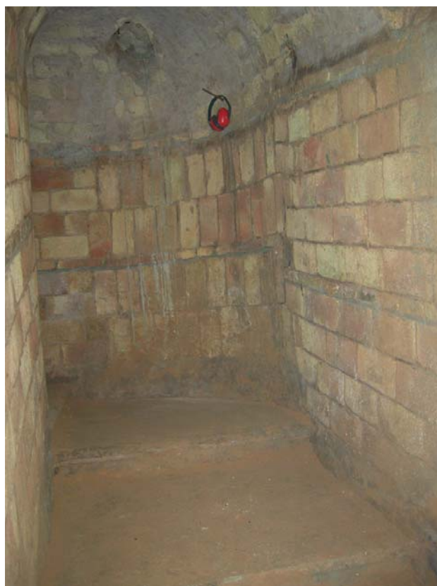
FOTO 52: Entrada accés 3. Replans segon passadís
