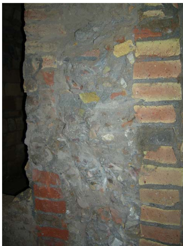
FOTO 42: Entrada accés 3. Reompliment tapia
