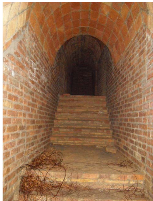
FOTO 134: Entrada-accés 3, replà de maons
