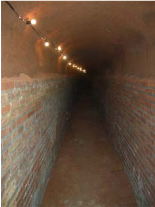
FOTO 127: Tram 9, galeria inacabada
