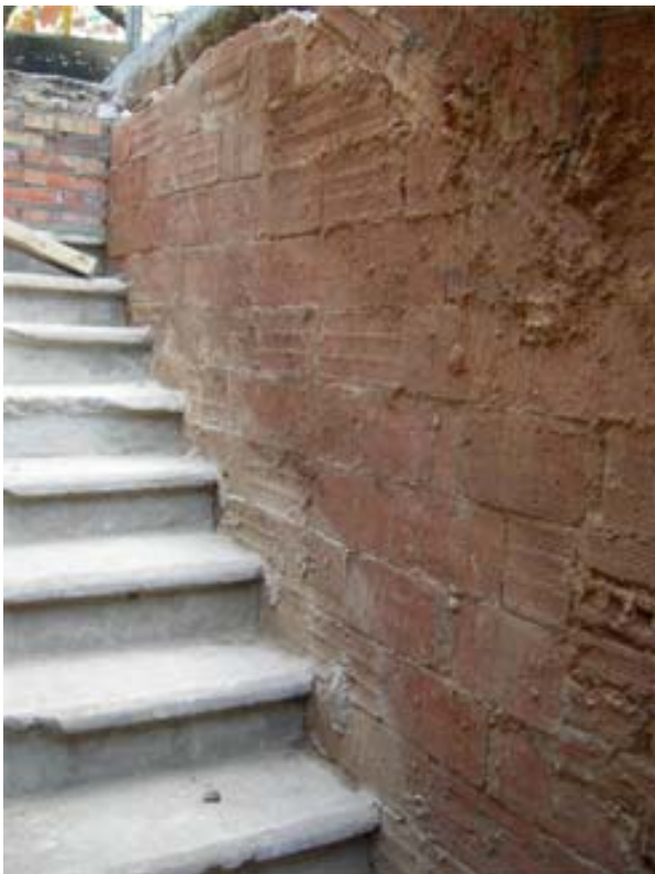
FOTO 129: Entrada-accés 3, maons horitzontals
