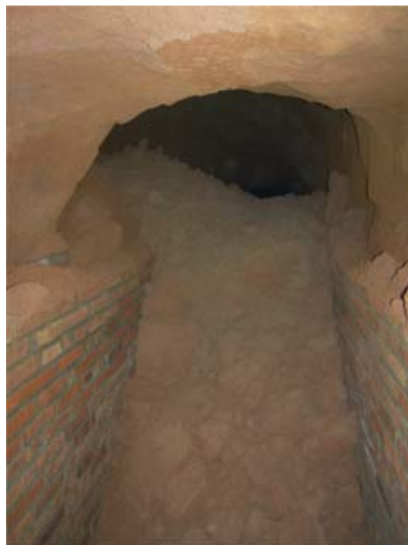
FOTO 98: Entrada 5, tram 9 inacabat
