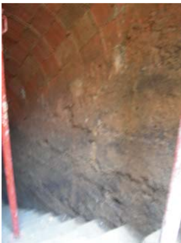
FOTO 85: Entrada-accés 5, encofrat perdut
