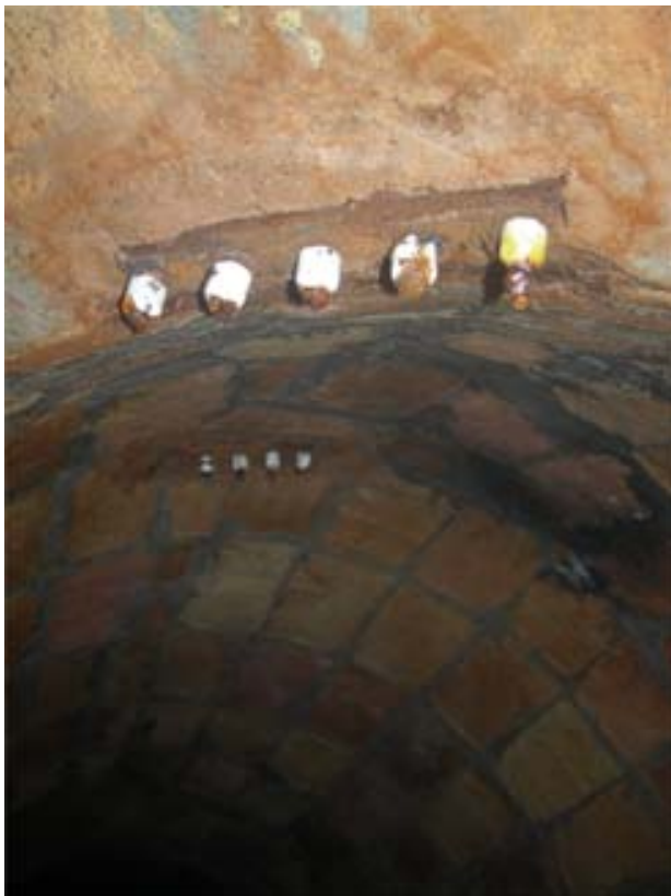
FOTO 137: Entrada-escala 5, aïllants per la llum
